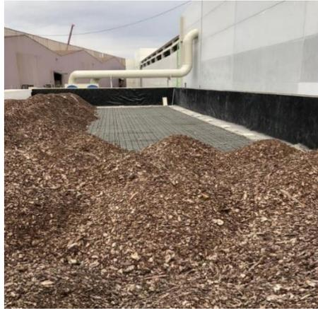
*Figura 3.9 Llenado del biofiltro. Fuente: elaboración propia.*
