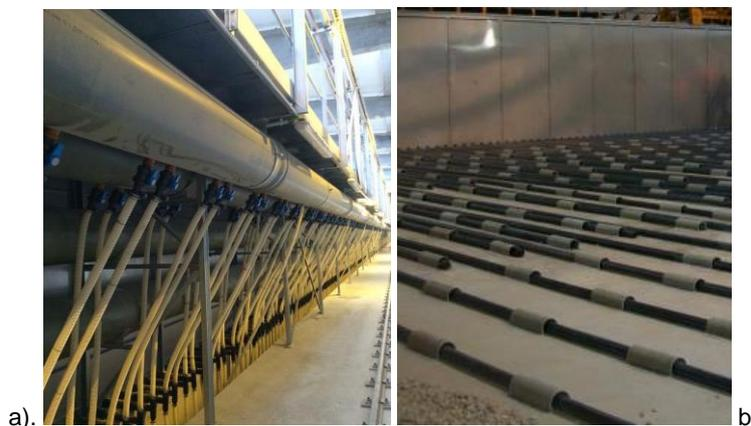
Figura 4.2 a: colectores del reactor b: disposición de las tuberías HDPE en el suelo.
