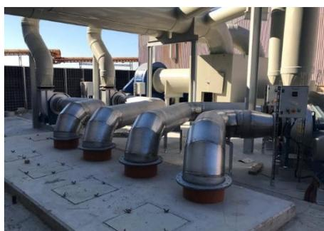
*Figura 4.3 Ventiladores eléctricos. Fuente: elaboración propia.*
