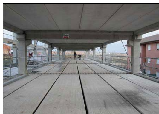
Figure 4.2.2: Alveolar slab plate. Source: http://esp.prefabricatspujol.com
