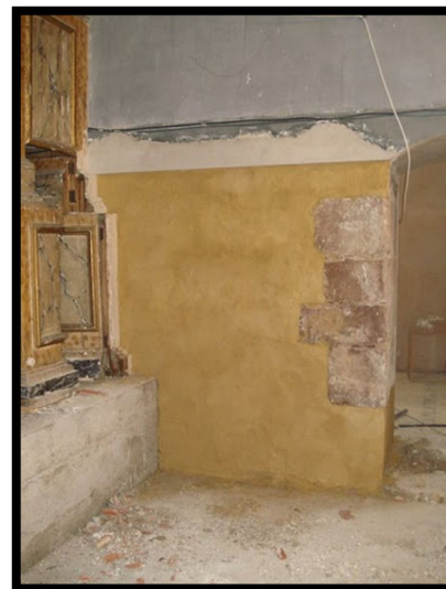
-Acabado en muros y pilares con cemento, elementos vistos de mampuestos de arenisca.-
