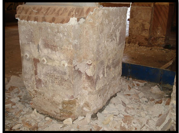
-Picado de las zonas húmedas afectadas. Ejecución de agujeros para sifones de desecamiento.-
