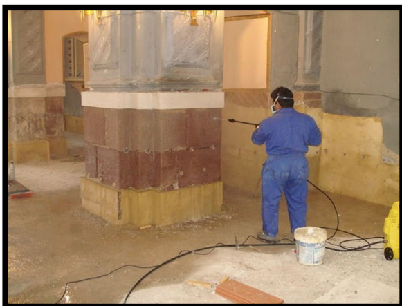
-Acabado en muros y pilares con cemento, elementos vistos de mampuestos de arenisca.-
