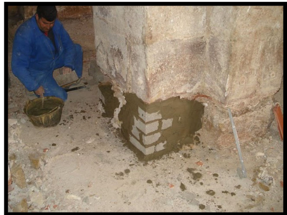
-Picado y reconstrucción del volumen faltante. Instalación de tubos drenantes en muros y pilares.-
