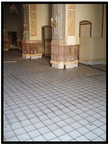
-Mallazo de la solera aislante.-
