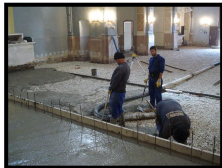
-Vertido de la capa de hormigón de limpieza. Ejecución de juntas de dilatación.-
