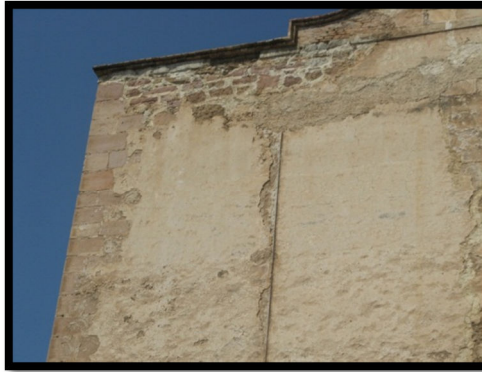
-Detalle de fachada frontal.-
