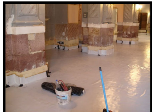
-Colocación de lámina impermeabilizante.-
