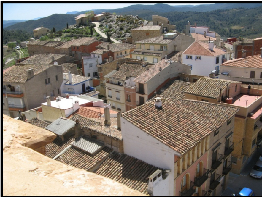
-Vistas al sur-oeste. Ermita de San Cristóbal.-
