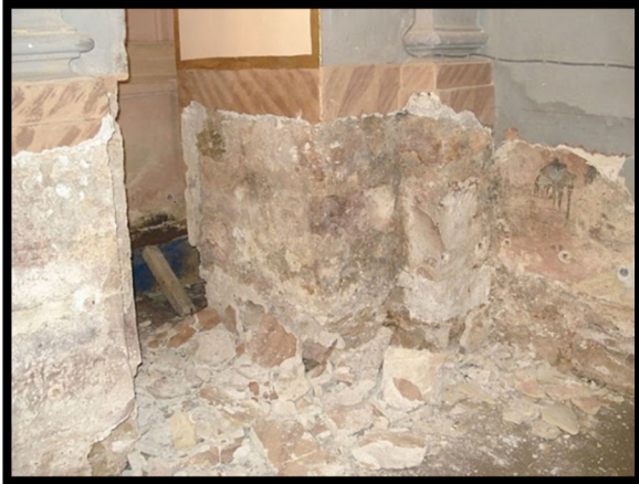
-Picado de las zonas húmedas afectadas. Ejecución de agujeros para sifones de desecamiento.-
