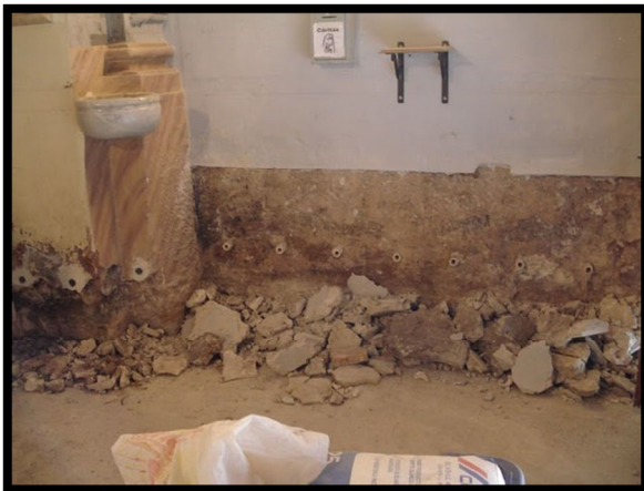
-Picado y reconstrucción del volumen faltante. Instalación de tubos drenantes en muros y pilares.-
