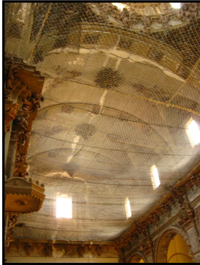
Bóveda de cañón tabicada con lunetos.-
