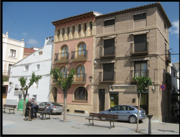
-Plaza mayor, edificio restaurado.-
