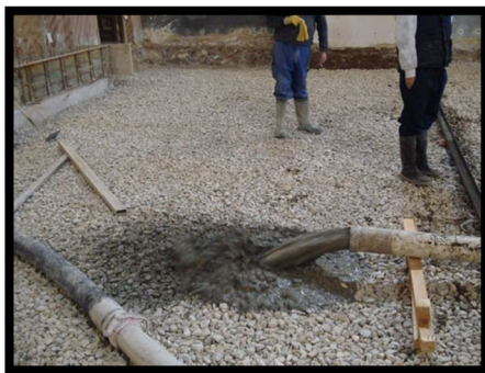
-Vertido de la capa de hormigón de limpieza. Ejecución de juntas de dilatación.-
