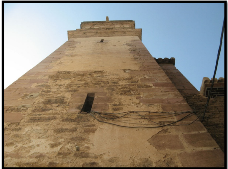
-Foto del lateral de la torre, paramento exterior.-
