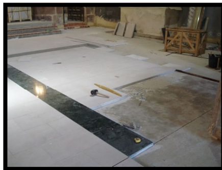
-Colocación del pavimento de mármol.-
