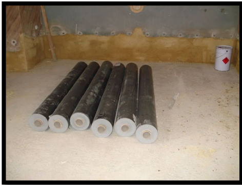
-Colocación de lámina impermeabilizante.-
