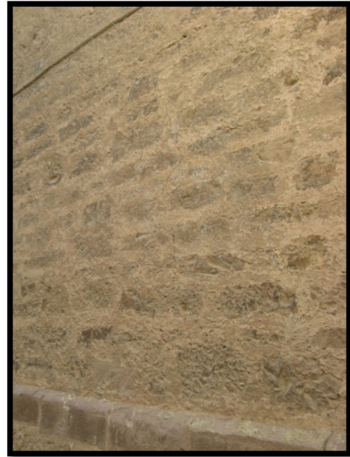
-Detalle de mampostería de los muros perimetrales.-
