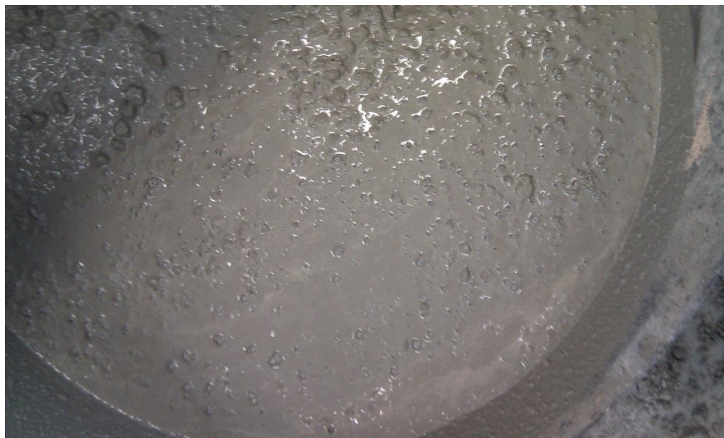
Aspecto del Hormigón
