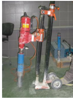
a) Máquina extracción de testigos
