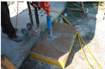
a) Perforación de la loseta
