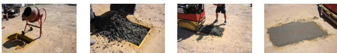
a) Encofrado introducido en el firme b) Vertido del hormigón c) Rodillo compactador d) Acabado superficial
