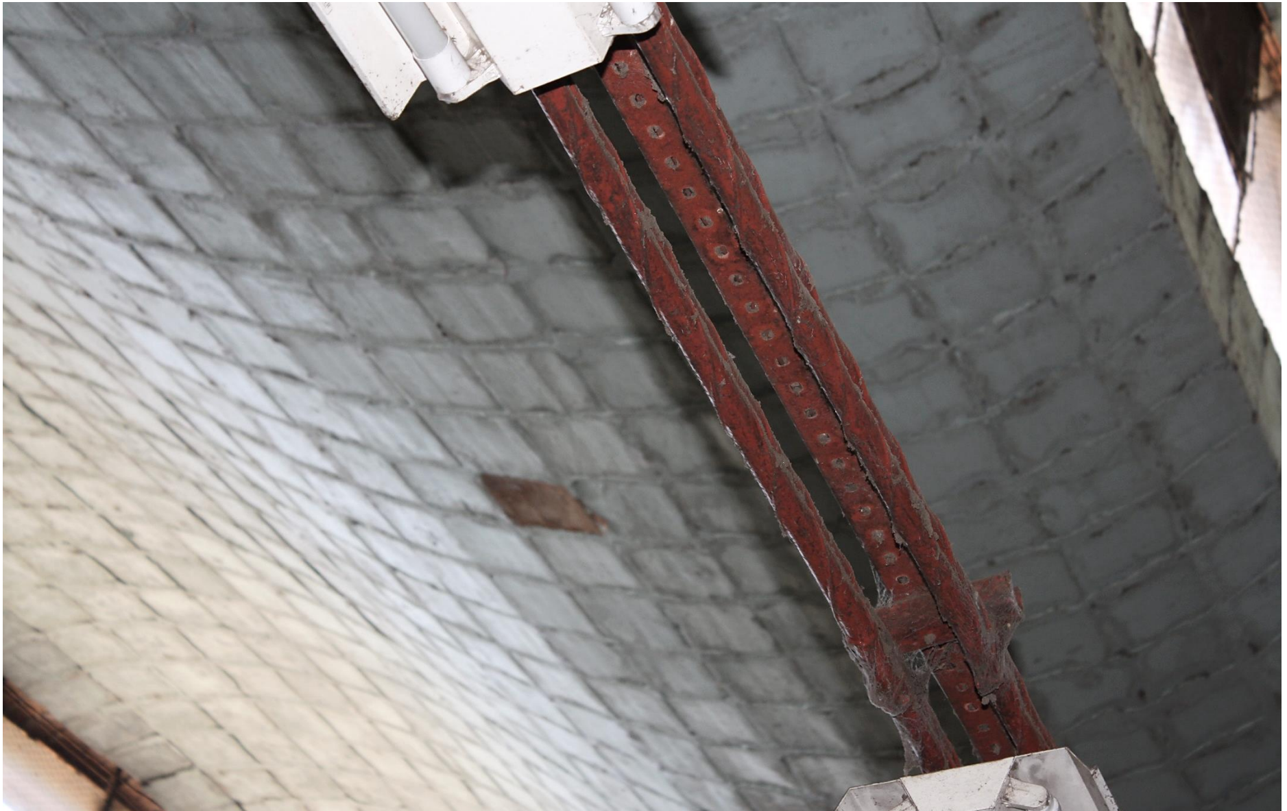
Fig. 69 | Detalle suciedad tirantes y cerámica. Foto: Manoel Seadi.
