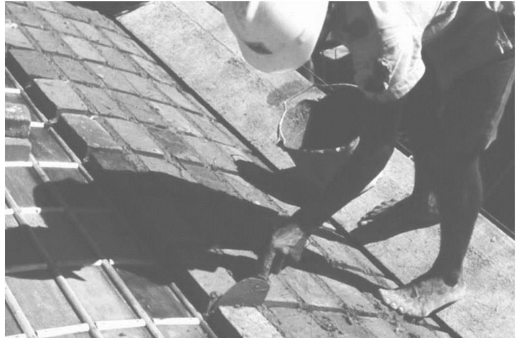
Fig. 42 | Puesta en obra cerámica armada en la CEASA/RS. Fuente: Acervo FAM.
