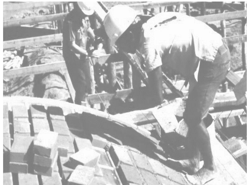
Fig. 49 | Puesta en obra de las bóvedas autoportantes de la CEASA/RS. Fuente:
