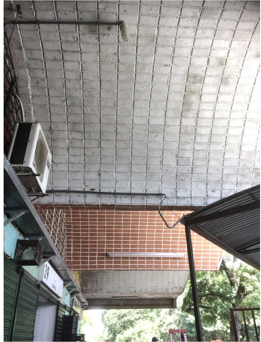
Fig. 66 | Interior actual del pabellón de los comerciantes. Foto: Manoel Seadi.
