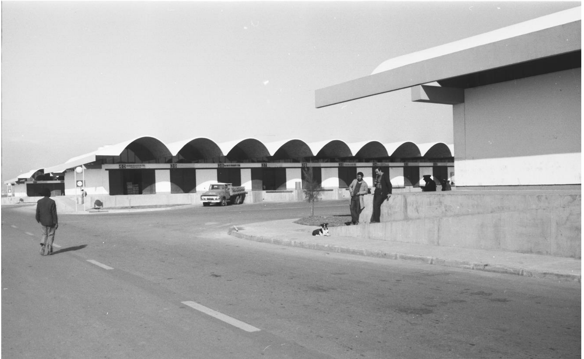
Fig. 37 | Pabellones de los comerciantes en la época. Fuente: Acervo João Alberto FAU UniRitter
