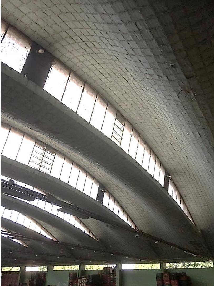
Fig. 61 | Interior actual del pabellón del productor. Foto: Manoel Seadi.
