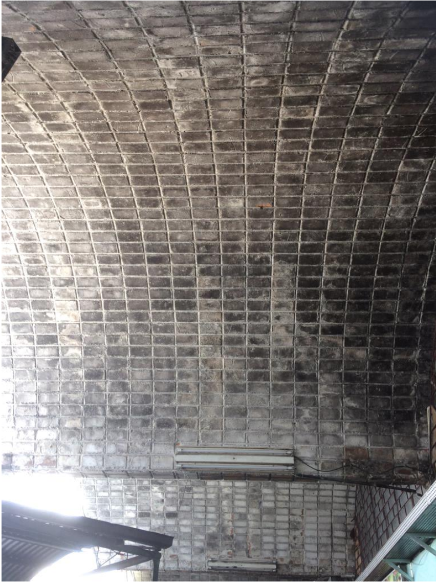
Fig. 65 | Interior actual del pabellón de los comerciantes. Foto: Manoel Seadi.
