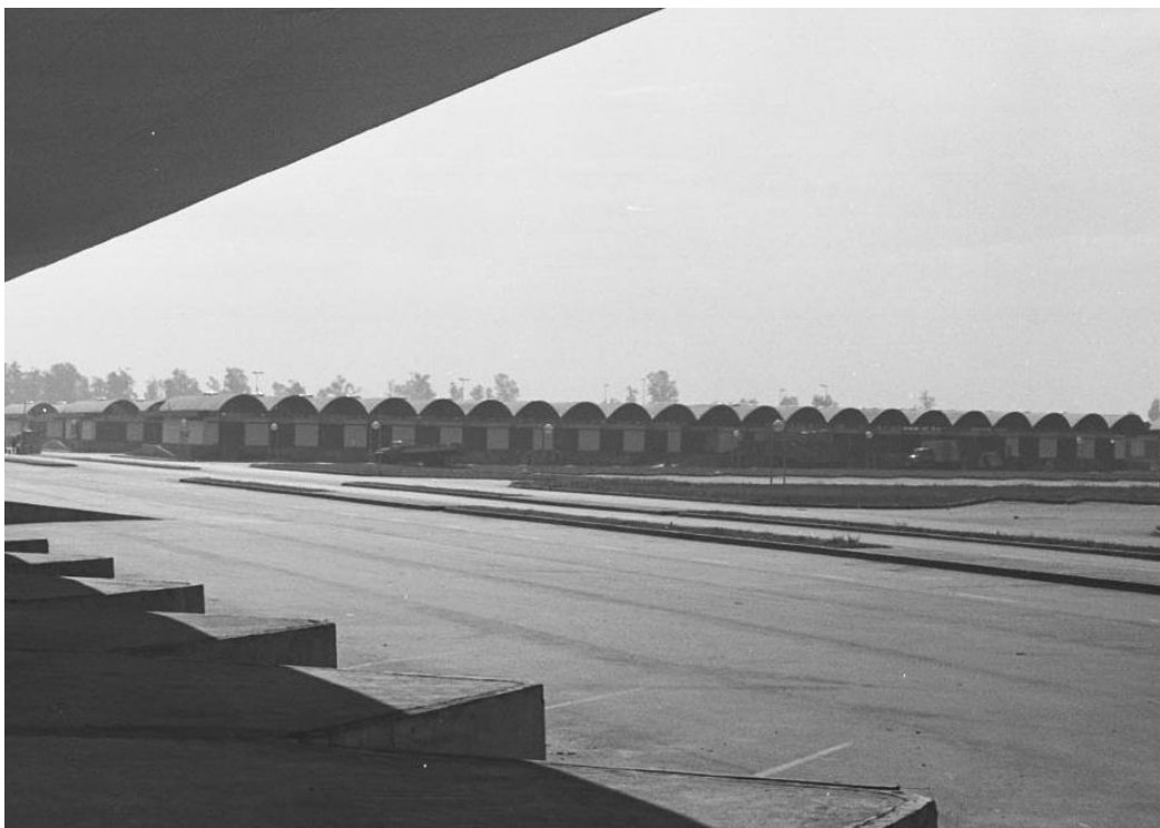
Fig. 35 | Pabellones de los comerciantes en la época. Fuente: Acervo João Alberto FAU UniRitter
