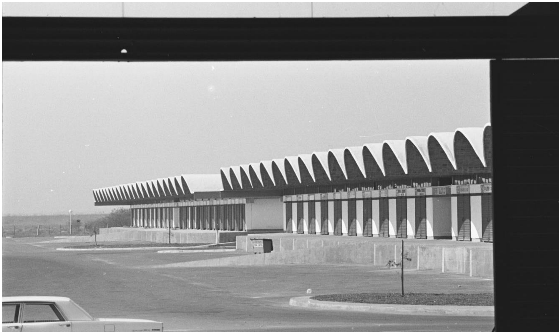
Fig. 38 | Pabellones de los comerciantes en la época. Fuente: Acervo João Alberto FAU UniRitter
