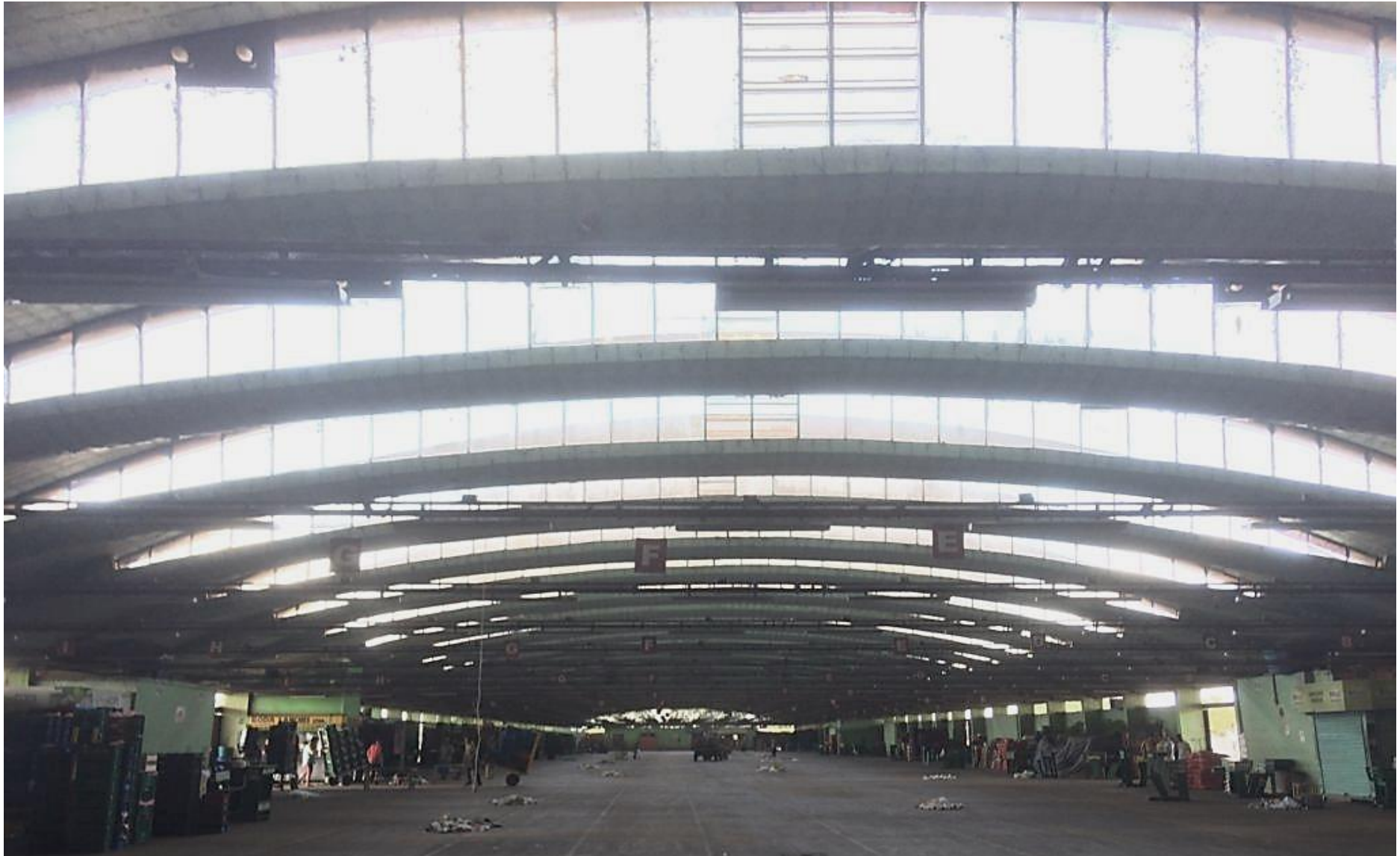
Fig. 60 | Interior actual del pabellón del productor de la CEASA/RS. Foto: Manoel Seadi
