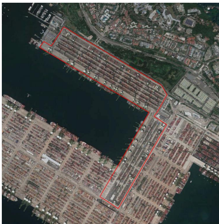
Figura 50. Imagen satelital de Pasir Panjang Terminal 1. Fuente: Google Earth.
