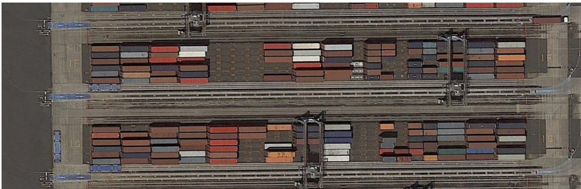
Figura 26. Ejemplo de segregación de tráfico externo en Tobishima Container Berth (Nagoya). Fuente: Google Earth.
