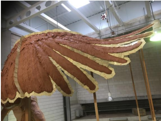
Figs. 154 y 155. Chapas de separación para la realización del molde de las alas y puntales de sujeción.
