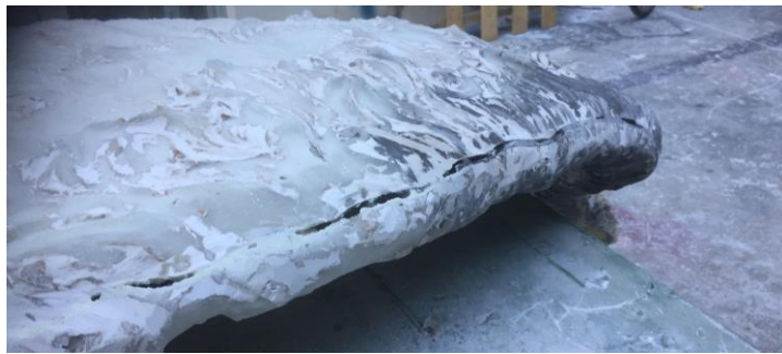
Fig. 200. Limpieza, emplaste y repaso de las juntas.
