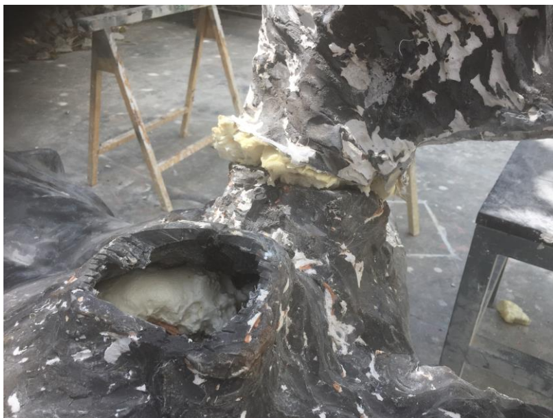
Fig. 204. Limpieza de la junta desmontable.
