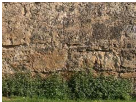
Vegetación en juntas, parte baja del paredón.
