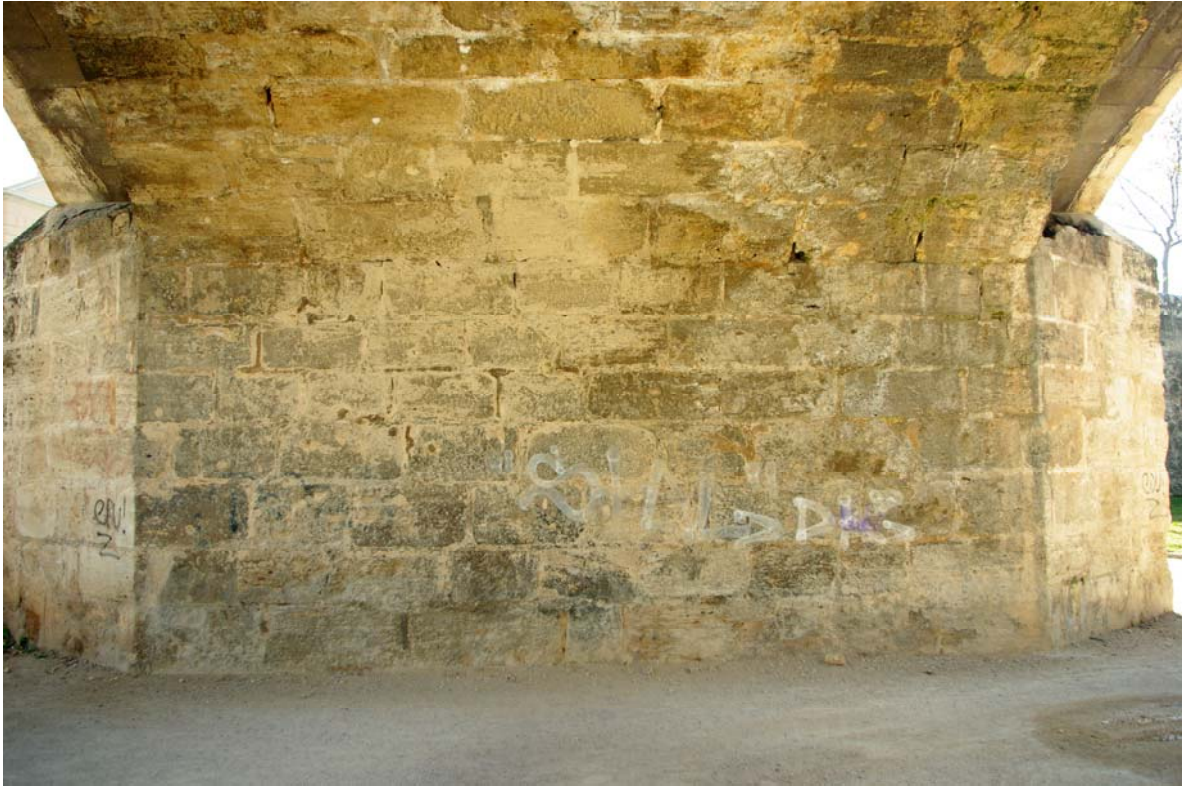
Pila con tajamares laterales y bóveda
