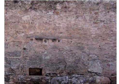
Restos de antiguas casetas adosadas al muro, suciedad, costras negras.
