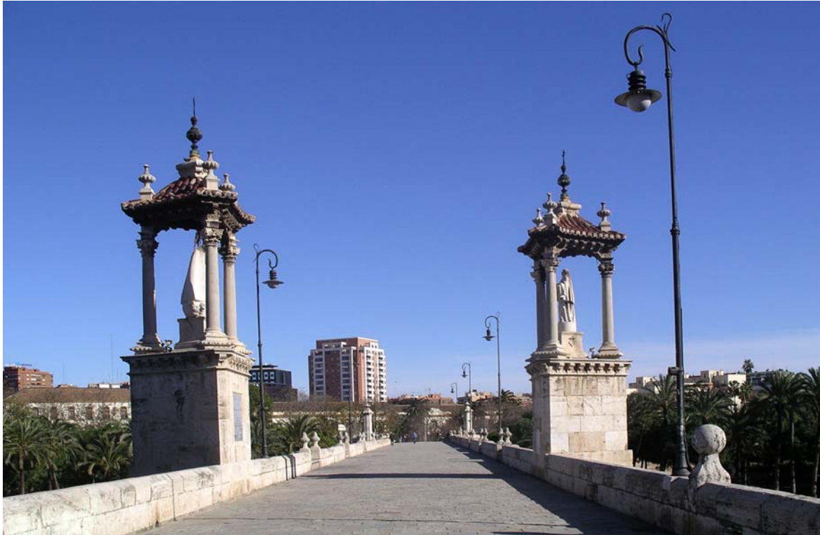
Puente del Mar. A la izquierda, casilicio de la Virgen de los Desamparados, a la derecha, el de San Pascual Bailón. Vista general desde arranque plaza América
