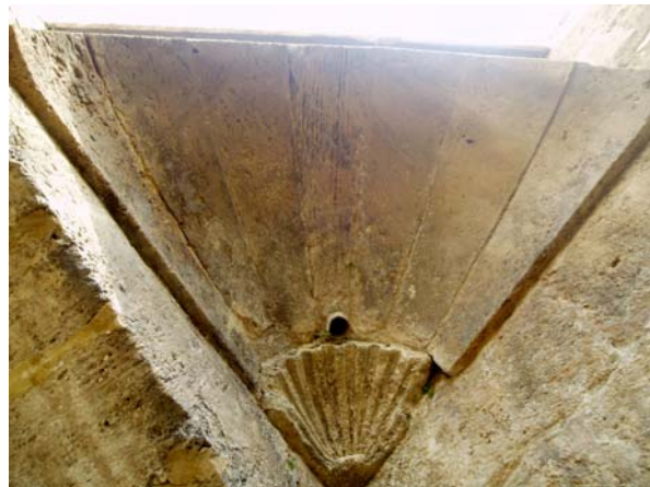
Alzado posterior del banco, bajo él, la pechina labrada que cierra la esquina.
