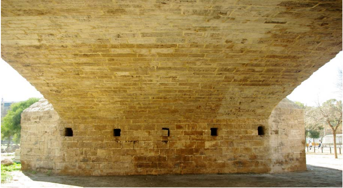
Bóveda, pila con los tajamares en los extremos.
