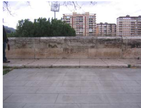
Suciedad generalizada formación de costras negras en pretil.
