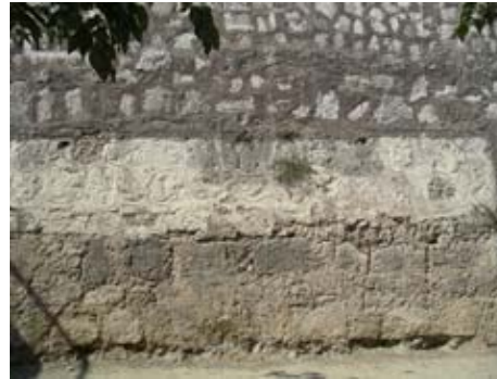
Restos pintura de antiguas casetas.
