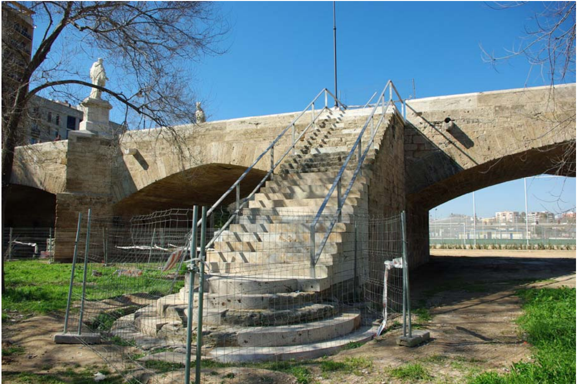
Escalera en continuidad con la tercera pila. Su arranque lo conforman 5 peldaños de planta circular.
