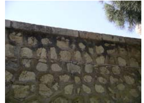
Suciedad generalizada con formación de costras negras en pretil.
