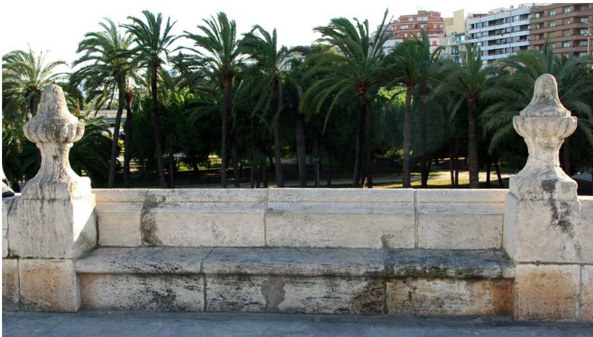
Alzado banco pétreo con ornato sobre el pretil del puente
