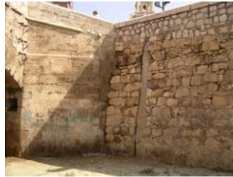
Cableados eléctricos adheridos al muro.
