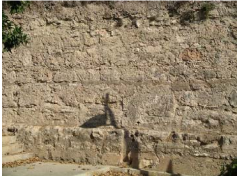
Roza longitudinal oculta con mortero de cemento.
