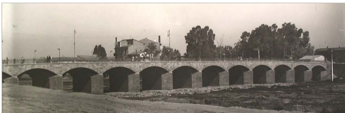
Fotografía del puente de San José tras su ampliación 1906-1908 El puente ya luce sus nuevos arcos y sobre éstos barandilla metálica causante de gran controversia. Archivo histórico Municipal de Valencia.
