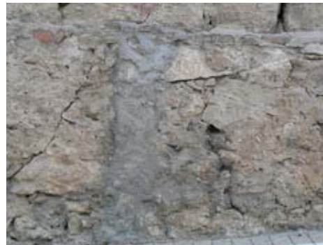
Parcheados con mortero de cemento Rejuntados con mortero de cemento
