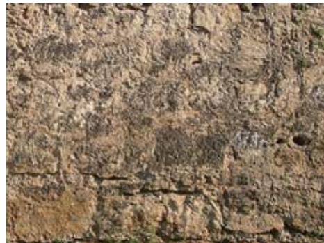
Suciedad generalizada con formación de costra negra.
