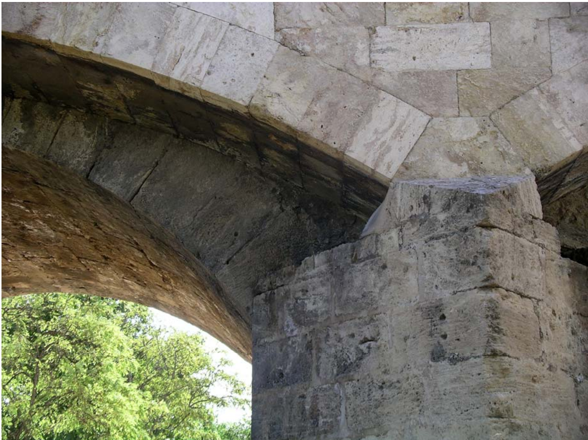
Detalle de encuentro del arco nuevo con el tajamar.
