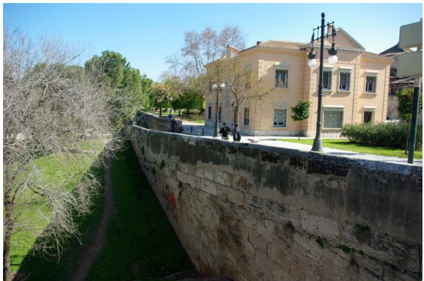
Pretel y muro de la rampa, realizado con mampostería concertada
