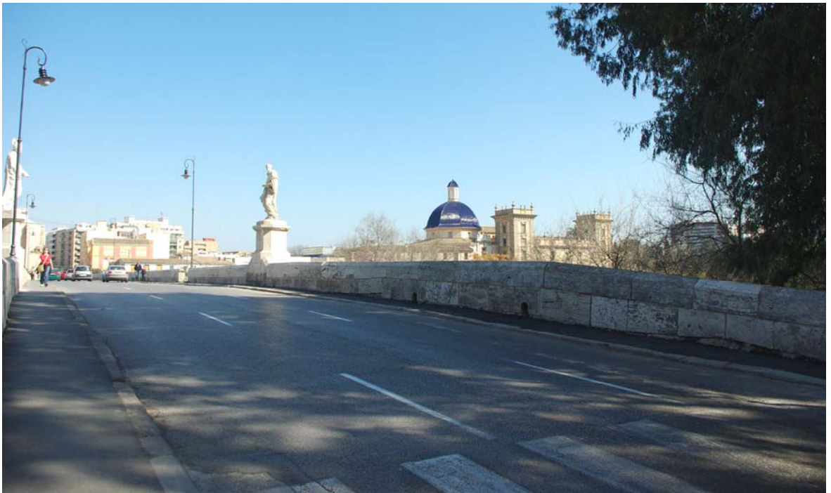
Vista general del tablero puente desde su arranque derecho
