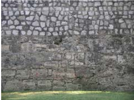
Suciedad generalizada con formación de costra negra.
