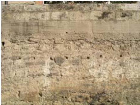
Parcheado longitudinal con mortero de cemento longitudinal.
