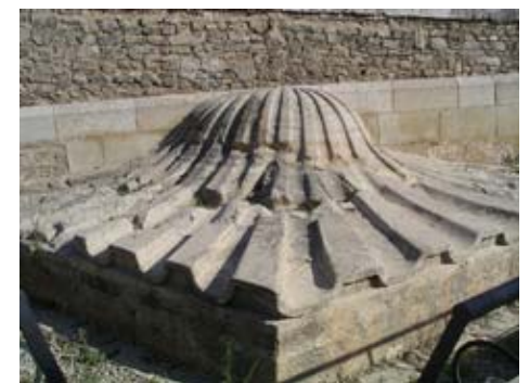
"LA PETXINA": suciedad, erosión, roturas.
