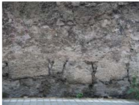
Disgregación de los materiales.
