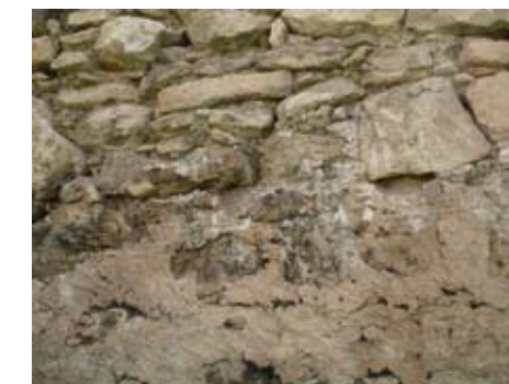
Parcheados con mortero de cemento.
