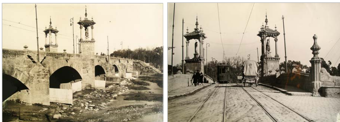
Fotografías de B. Masip (derecha) Estado del puente del Real entre 1926 y 1936, dotado con alumbrado eléctrico, el pavimento aparece surcado por las vías el tranvía (disco nº 8) procedente del Grao. Archivo Histórico Municipal de Valencia.
