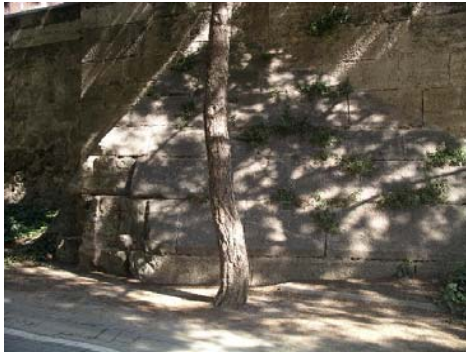
Roturas de estribos.
