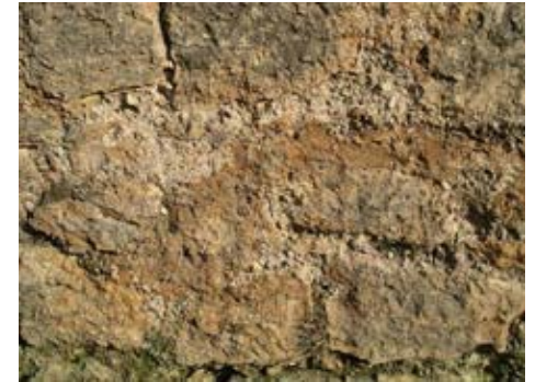
Disgregación del material de agarre.
