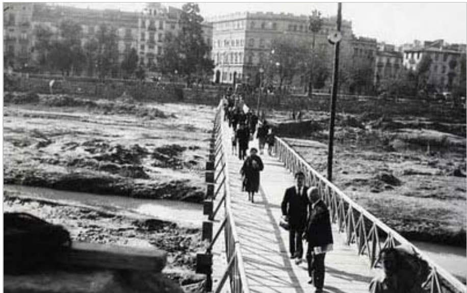
Pont de Fusta provisional.
