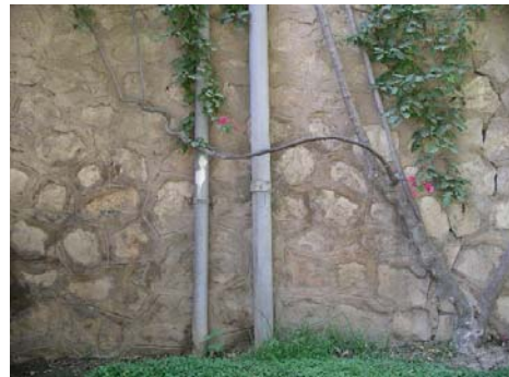
Bajante adherida al muro.
