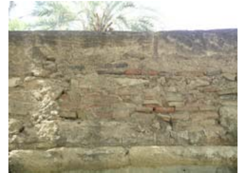
Reparaciones inadecuadas con ladrillo cerámica y cemento.
