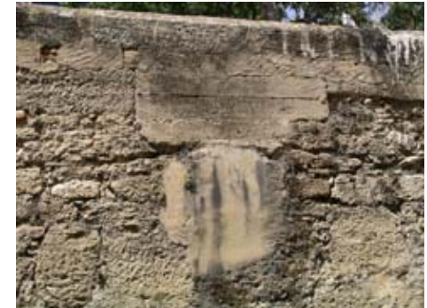
Parcheados con mortero de cemento.
