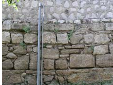
Canalizaciones de agua adheridas al muro.
