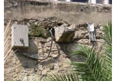
Cableados eléctricos adosados al paredón. Roza longitudinal que recorre todo el tramo.
