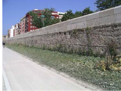
Roza longitudinal en todo el paredón. Vegetación adherida muro.
