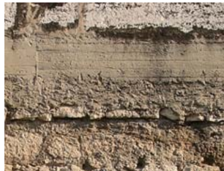
Parcheado de cemento que recorre longitudinalmente todo el tramo en su parte alta.
