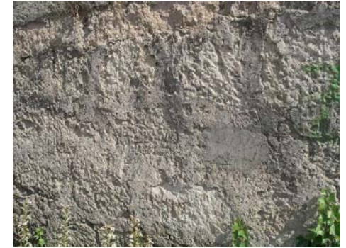
Rejuntados con mortero de cemento.
