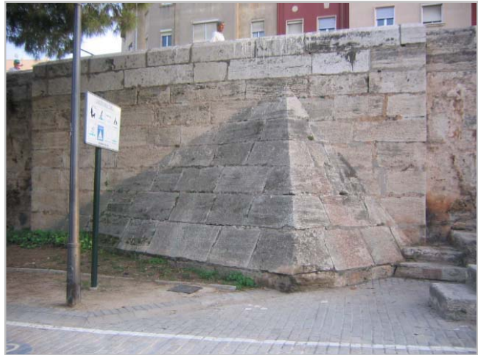
Fotografía actual de uno de los estribos, construidos tras la riada de 1731
