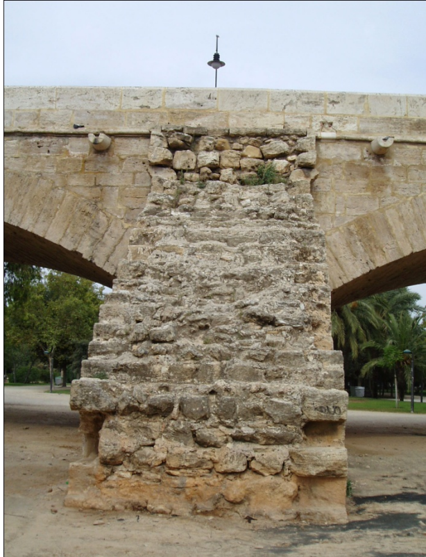
Perfil y alzado de los vestigios de la escalera, continuidad de la séptima pila aguas abajo.
