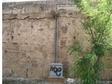
Canalizaciones de agua adheridas al pretil
