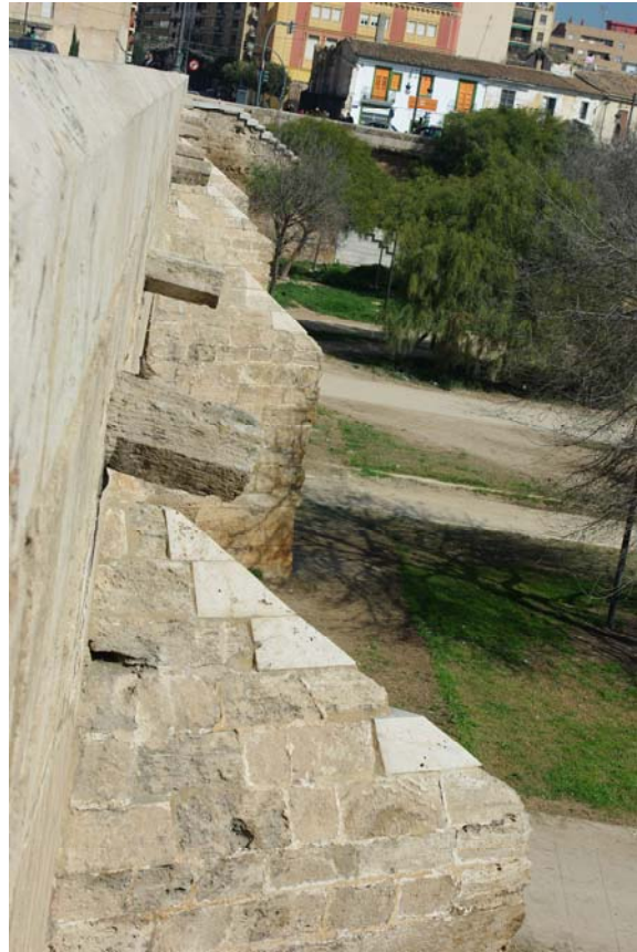
Perspectivas donde se observa la continuidad de los tajamares y gárgolas.
