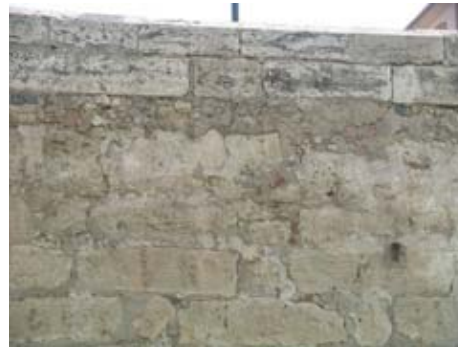
Rejuntados con mortero de cemento.
