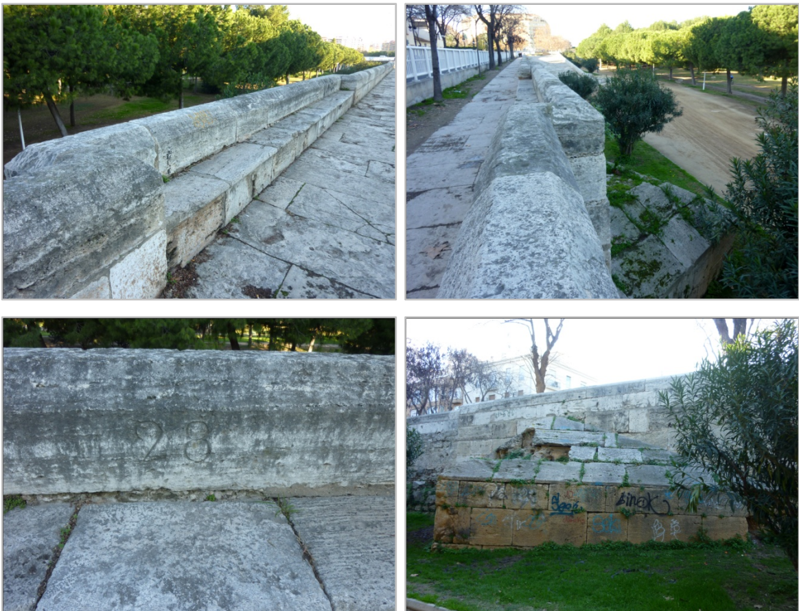
Estribos y bancos pétreos numerados situados en el Paseo de la Pechina.
