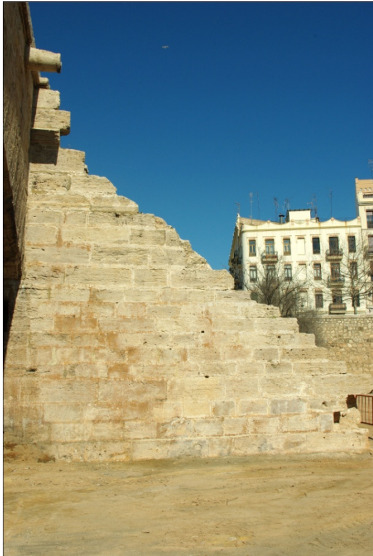
Perfil y alzado de los vestigios de la escalera, continuidad de la séptima pila aguas abajo.
