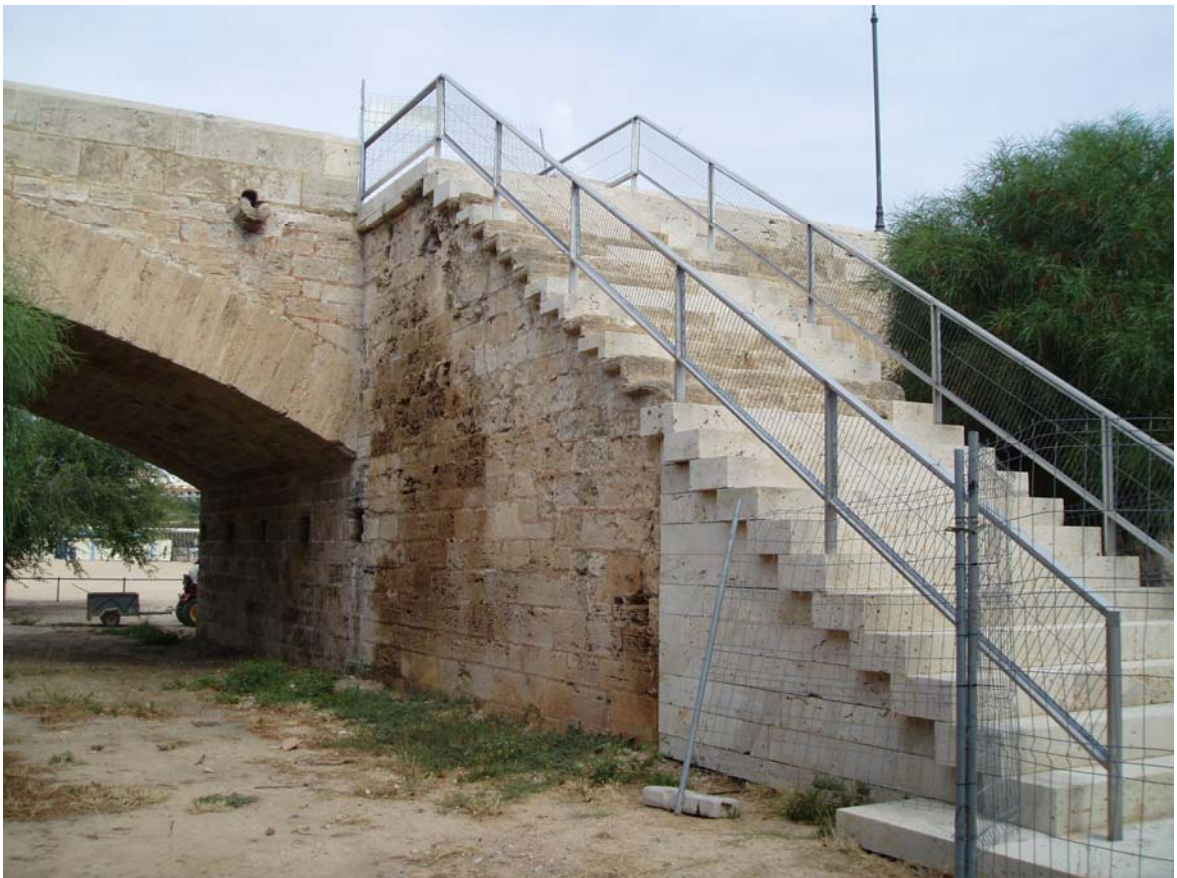
Escalera situada a continuación de la octava pila. En la imagen se hace patente las restituciones realizadas.
