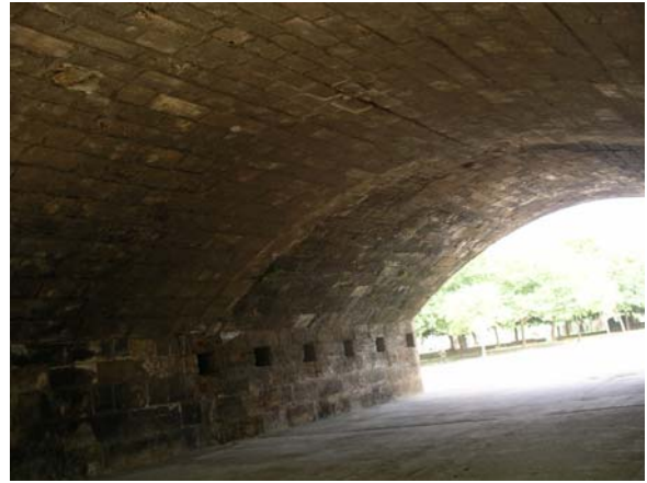
Junta encuentro puente original y ampliación
