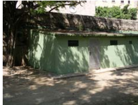
Casetas adosadas al paredón.
