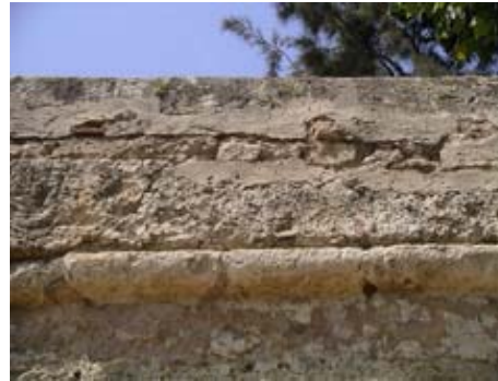
Disgregación del material de revestimiento. Parcheados con mortero de cemento.
