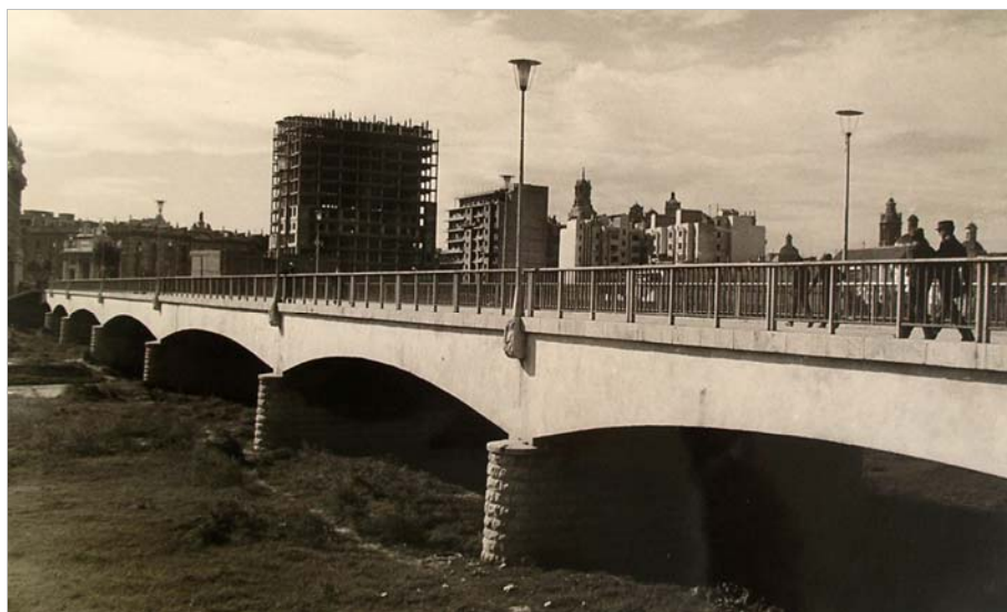
Fotografía de Luis Vidal donde se muestra de la pasarela de la Alameda o Exposición construida tras la riada de 1957. Archivo Histórico Municipal de Valencia.
