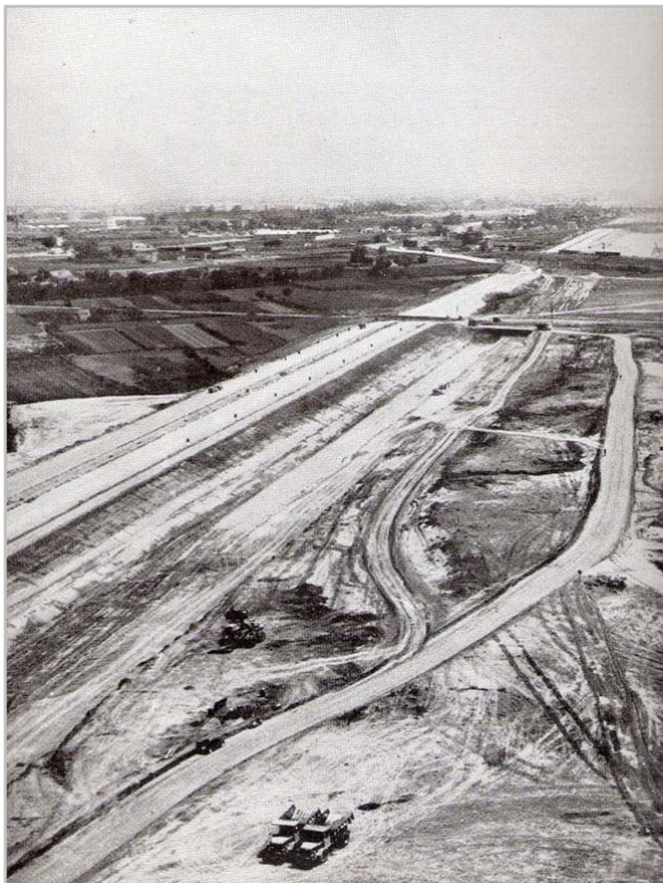
Obras en el nuevo trazado del cauce del río Turia
