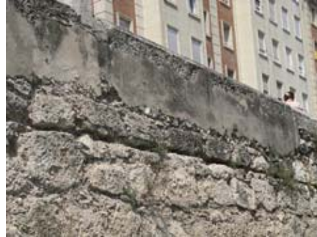
Parcheados con mortero de cemento.
