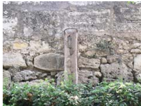
Restos de antiguos portes eléctricos.
