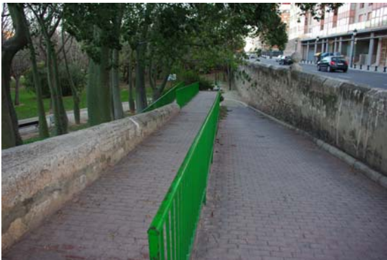
Rampa acceso cauce margen derecha aguas abajo puente
