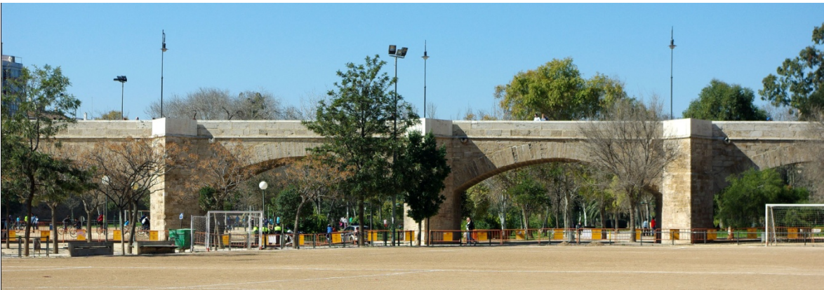
Vistas generales del puente de Serranos
