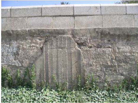
Parcheados con mortero de cemento.
