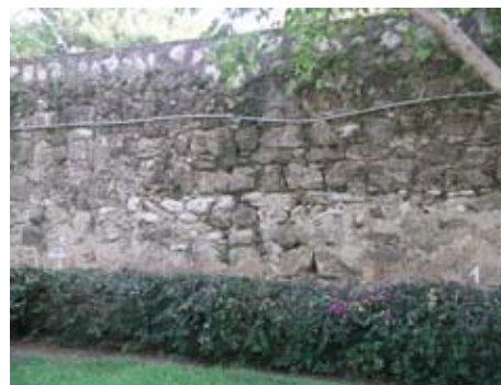
Cableado recorriendo longitudinalmente el tramo. Zona ajardinada lindante con el paredón.
