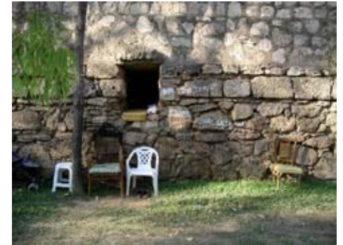
Antiguos desagües utilizados como "viviendas".
