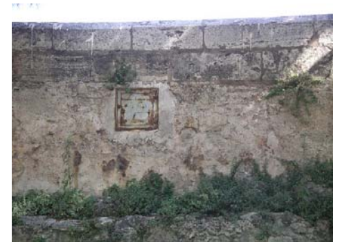
Trapa eléctrica inutilizada y rejuntada mortero de cemento.
