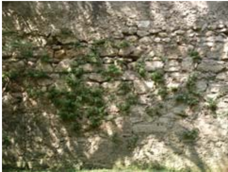
Disgregación generalizada.
