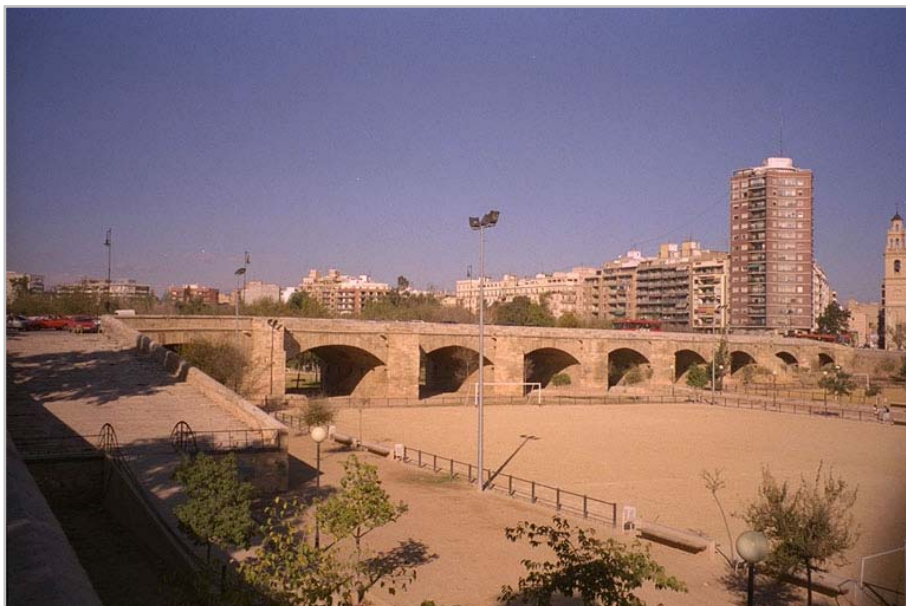
Fotografía del puente de Serranos tomada en 1998. Cedida por el servicio de coordinación de obras en vías públicas y mantenimiento – Infraestructuras - inventario de pasos de vehículos y ferrocarril. Ayuntamiento de Valencia.
