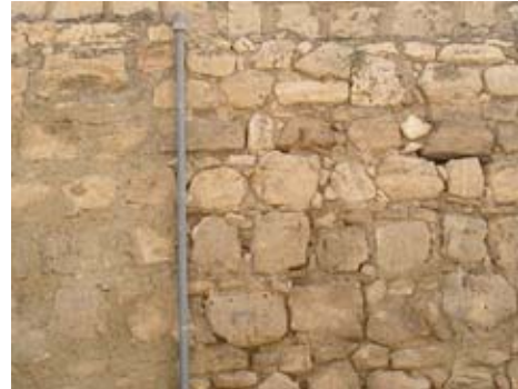
Canalizaciones de agua adheridas al muro.
