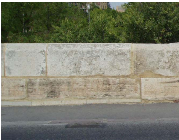
Pretil 2 hiladas de sillería
