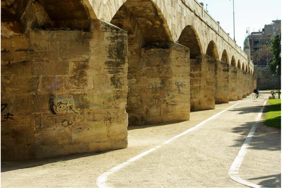
Perspectiva del puente desde el cauce
