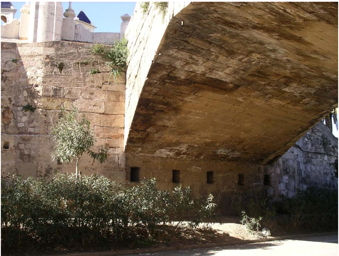
Arranque del puente
