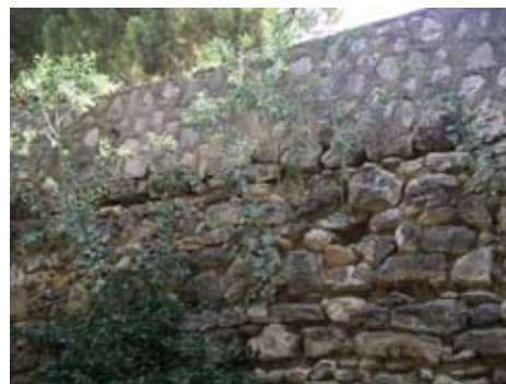
Vegetación superior en juntas. Suciedad generalizada, formación de costras negras. Falta de material conglomerante en juntas.
