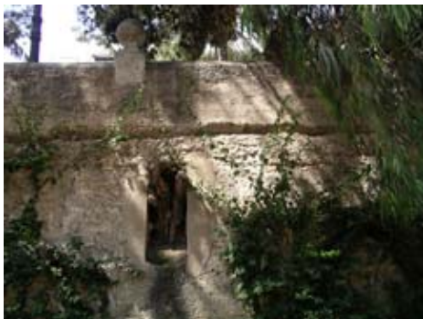
Roza longitudinal que recorre todo el tramo.
