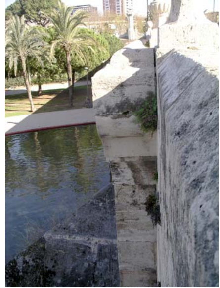
Estribos sobre los tajamares centrales
