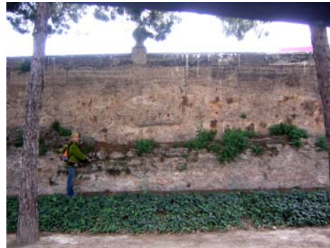
Humedades en zona baja, vegetación . Suciedad generalizada, restos de pinturas .
