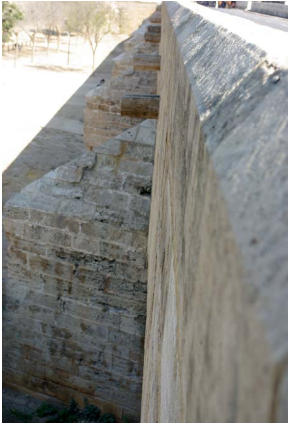
Perspectivas donde se observa la continuidad de los tajamares y gárgolas.
