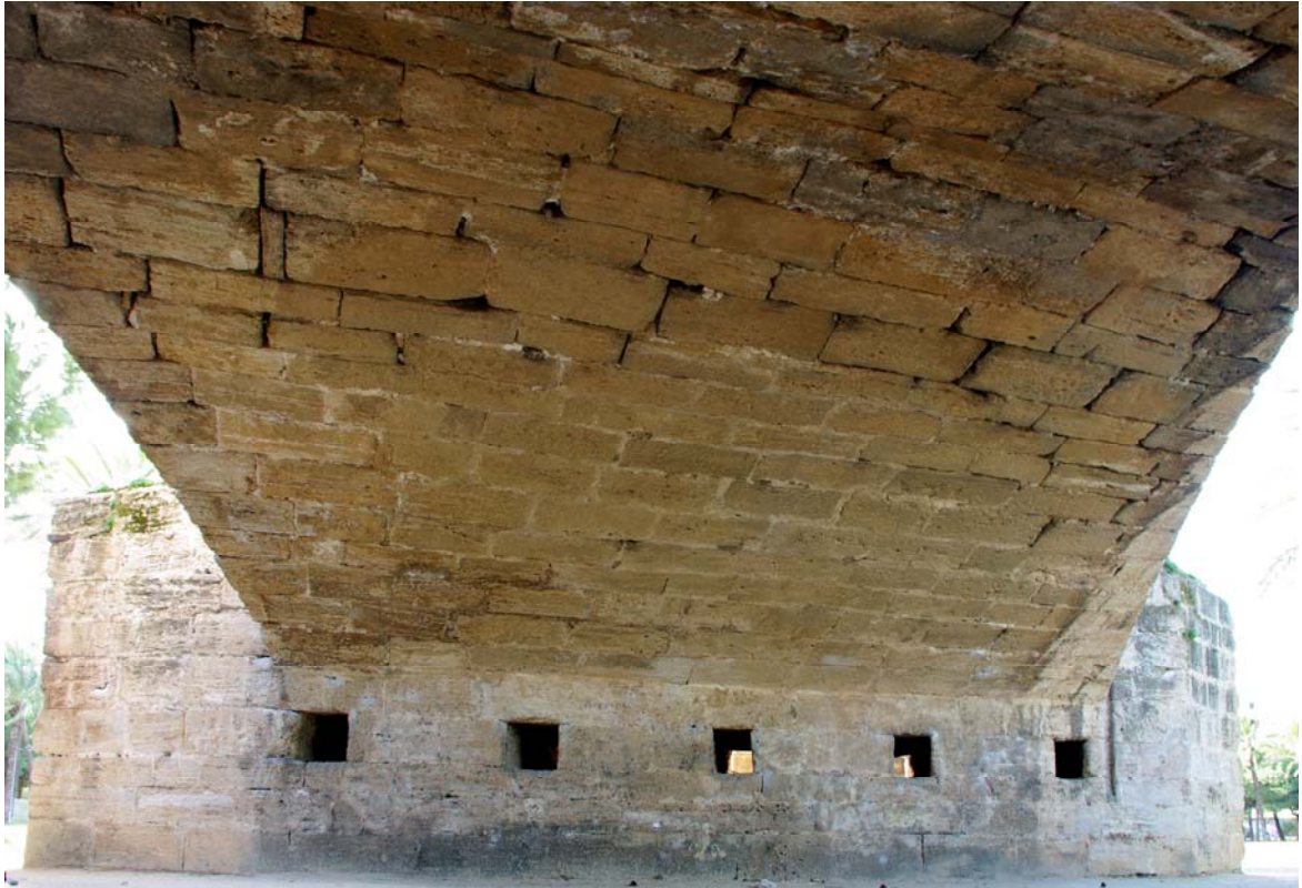
Pila, tajamares y bóveda
