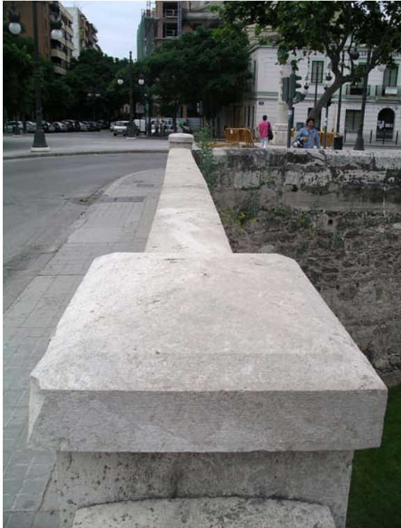
Pretil del puente de San José
