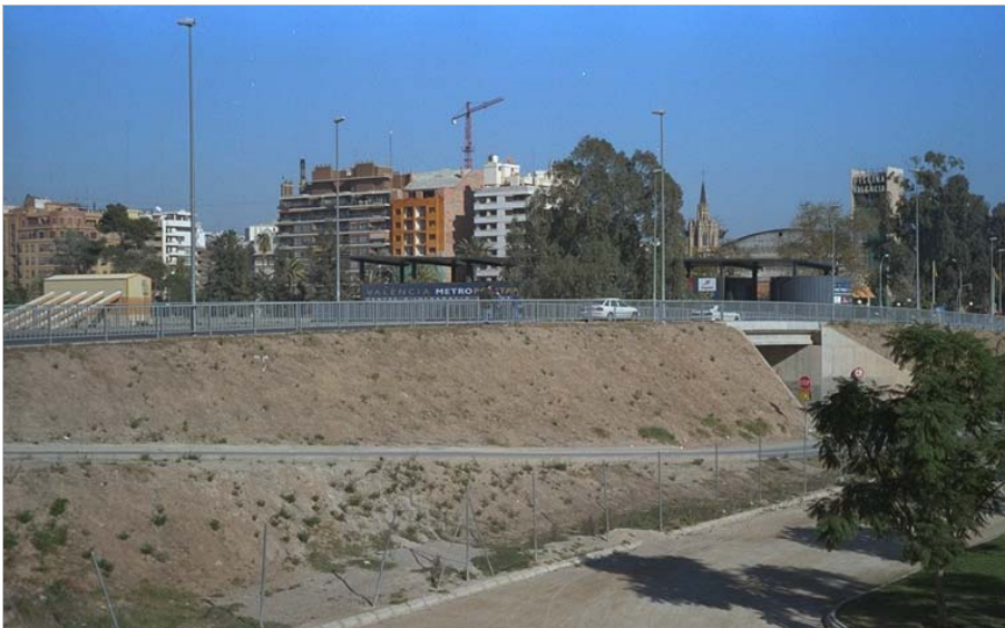
Pontón Provisional. 1998. Fotografía cedida por el Servicio de Coordinación de Obras en Vías Públicas y Mantenimiento-Infraestructuras-Inventariado de pasos de Vehículos y Ferrocarriles. Ayuntamiento de Valencia.
