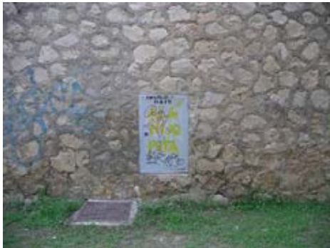
Trapas eléctricas insertadas en el paredón.
