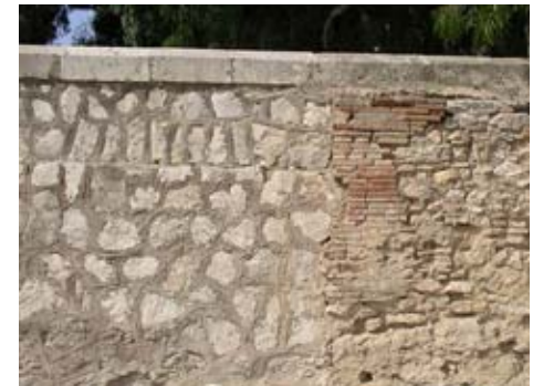
Actuaciones indebidas, reparaciones con ladrillo cerámico.
