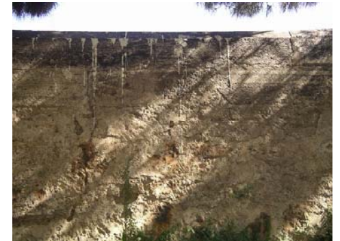
Suciedad generalizada, costras negras, restos de pintura en pretil.
