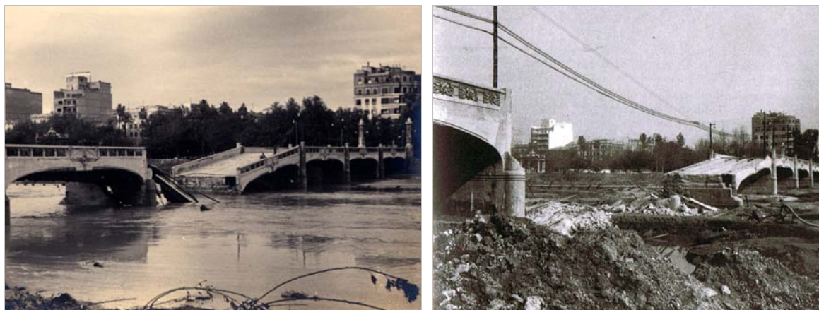
Fotografías de la pasarela de la Alameda, tras el desplome de sus arcos en la riada de 1957. Fotografías del Archivo Histórico Municipal de Valencia.
