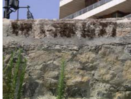
Rejuntados con mortero de cemento. Costra negra, musgo.
