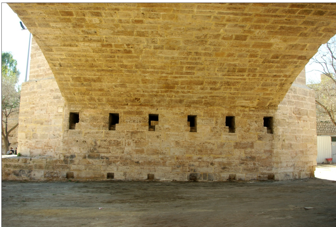
Pila - tajamares y bóveda.
