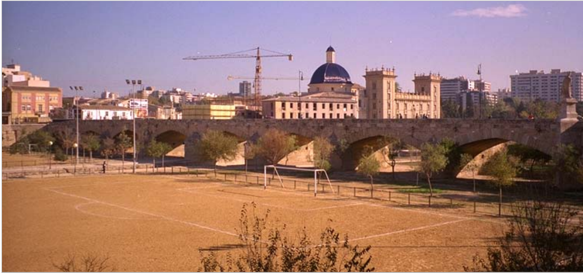
Fotografía del alzado, aguas arriba, del puente de la Trinidad en 1998, cedida por el Servicio de coordinación de obras en vías públicas y mantenimiento -infraestructuras- inventariado de pasos de vehículos y ferrocarril. Ayuntamiento de Valencia.
