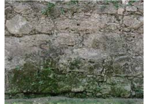
Humedades con formación de musgo en parte baja.
