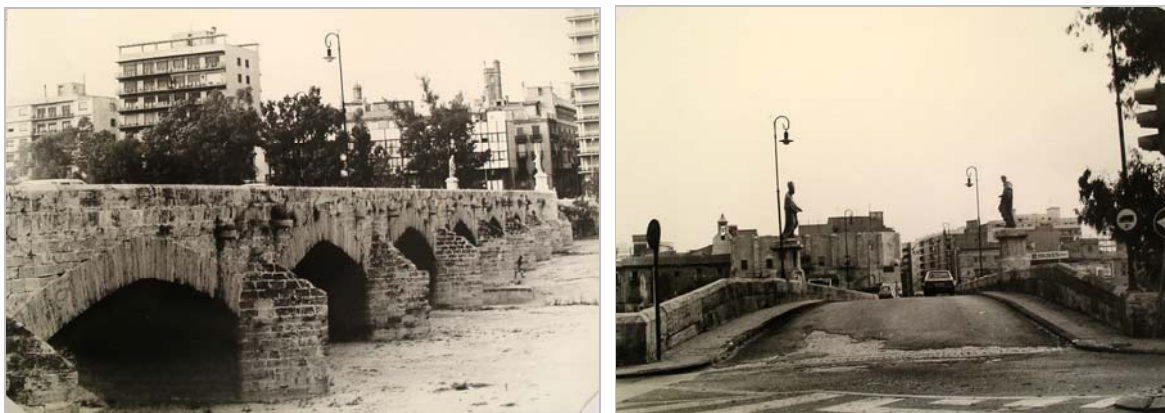
Como había ocurrido a lo largo de toda su historia, el puente de la Trinidad resistió a la gran avenida acontecida en octubre de 1957. Entre 1950 y 1960, es pavimentado con hormigón asfalto y se ejecutan unas nuevas aceras. Estas fotografías muestran el estado en el que se encontraba en 1980. Sus paramentos bien cuidados y tallados, se muestran ensombrecidos por manchas de costra negra y suciedad generalizada debida a su exposición continua a la intemperie. En 1996, se denuncian la existencia de grandes grietas en sus arcos, pero tras la inspección por los técnicos municipales estas no se consideran relevantes, calificándolas de “normales” 248 . Por lo demás, el puente aún conserva toda la riqueza que lo otorga su fábrica gótica. Fotografías anónimas. Archivo Histórico Municipal de Valencia
