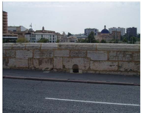
Pretil 3 hiladas y media de sillería
