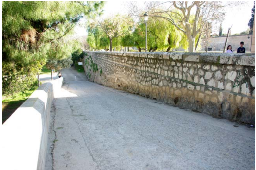
Bajada de acceso al cauce
