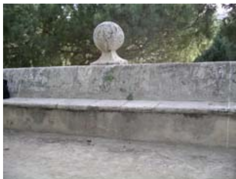
Bancos de descanso con suciedad generalizada Disgregación de las piedras, parcheados con mortero de cemento.
