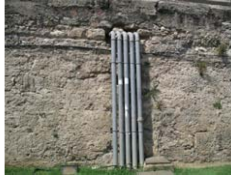
Canalizaciones de agua rompiendo el paredón.
