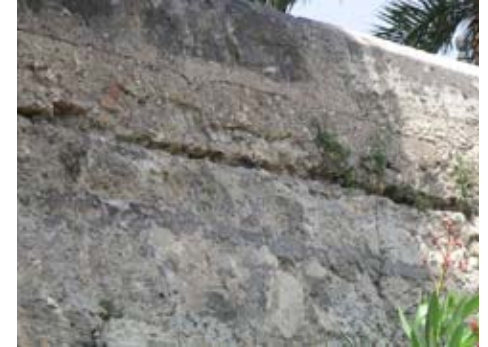
Roza longitudinal que recorre todo el tramo.
