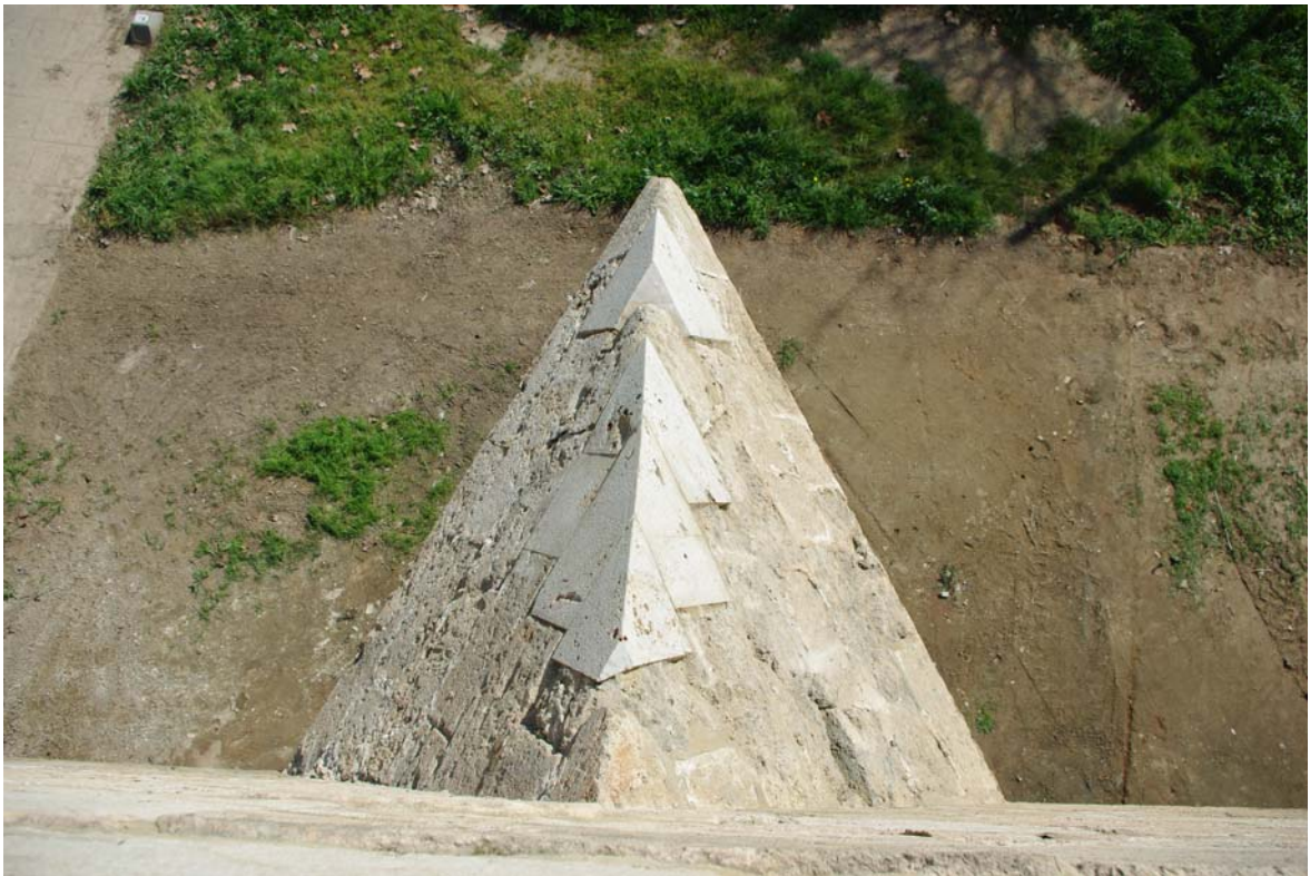
Planta aérea del tajamar, donde se aprecian las últimas restituciones realizadas en él.
