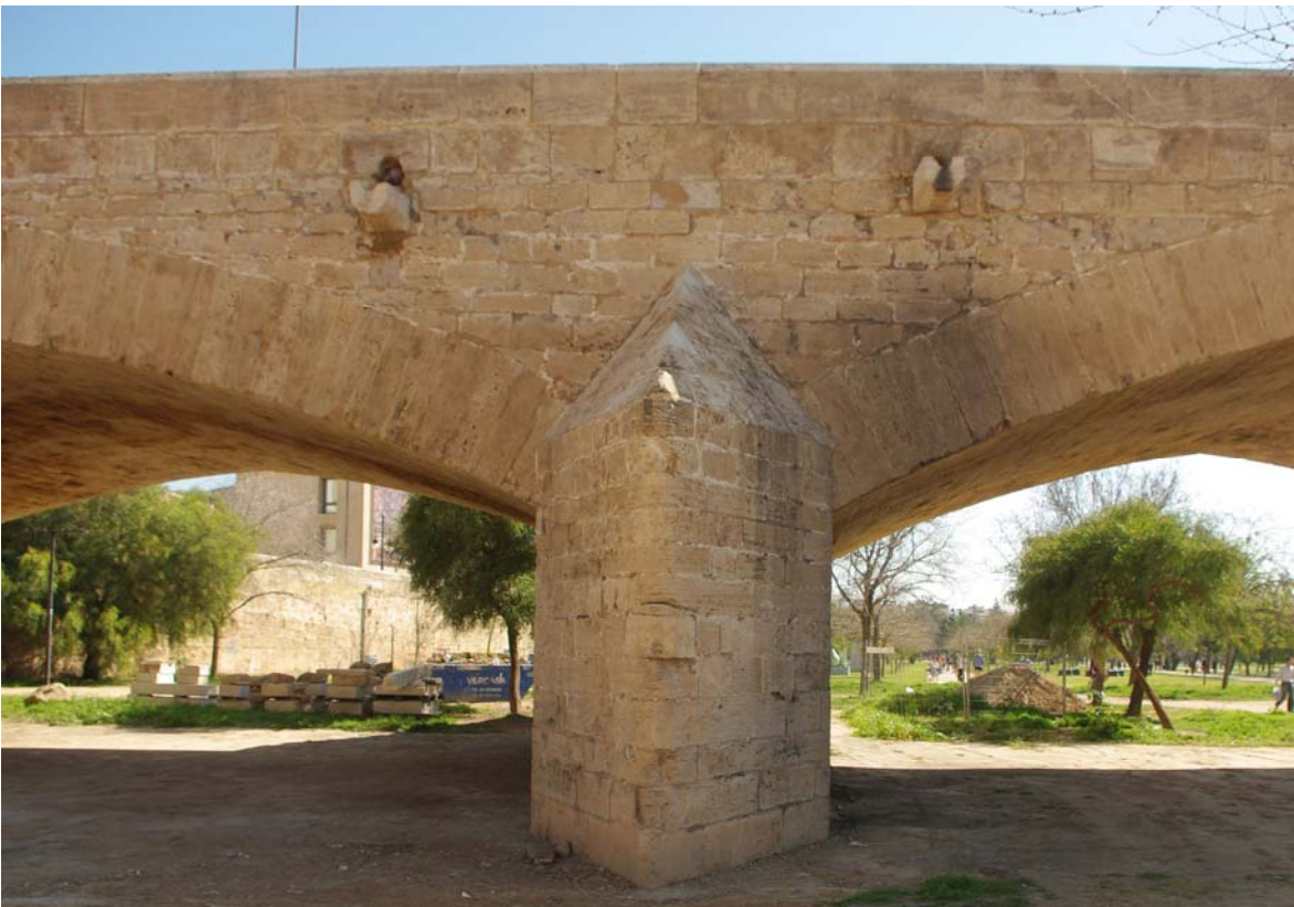
Tajamar de planta triangular, sobrepasando 2 hiladas el arranque del arco y sombrero con forma piramidal. A ambos lados, en la enjuta de los arcos se sitúan las gárgolas.
