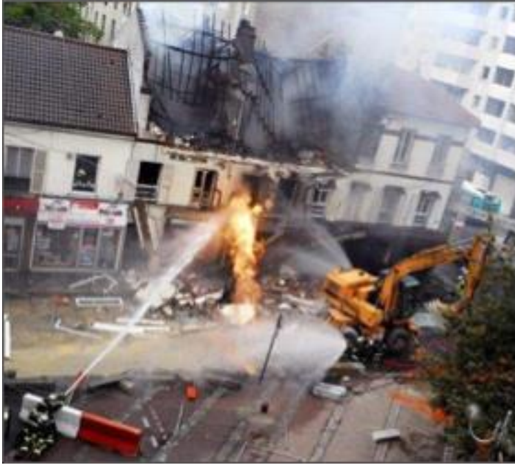
Figure 7 : Explosion mortelle de GAZ à Bondy en 2007
