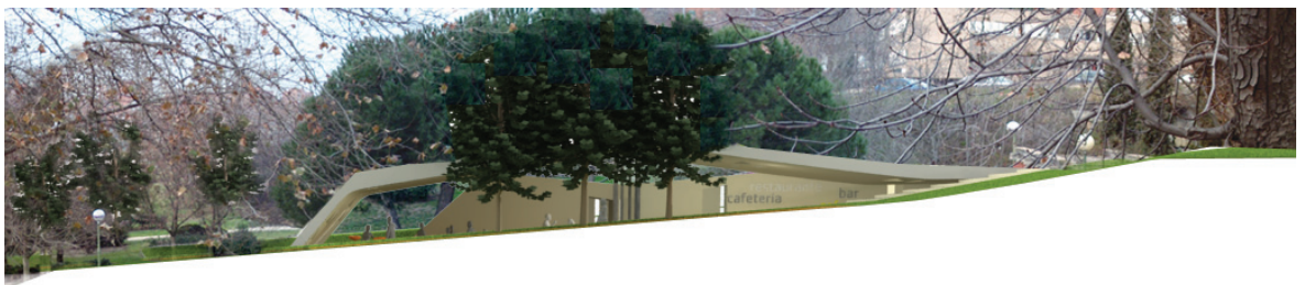
FIG. 37 Vista lateral del parque
