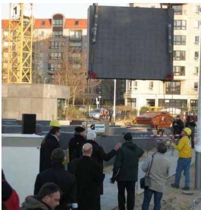
Colocación de las estelas.
