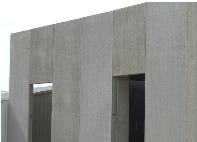
11.13. Con moldeo simple: rayado. Ref. Prevalosa
