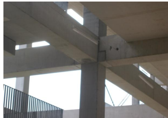
6.1. Union Viga Pilar Articulada (apoyo simple y a media madera), Ref. Prevalesa
