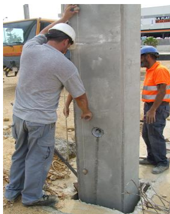
2.21. Acuñado, nivelado, aplomado y estado final del pilar, Ref. Prevalesa
