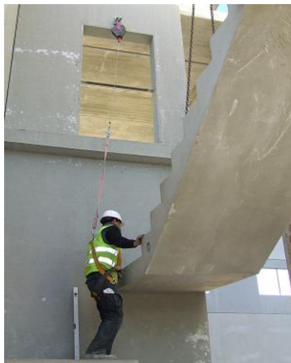
17.3. Medidas Preventivas durante el montaje de elementos prefabricados, Ref. Prevalesa
