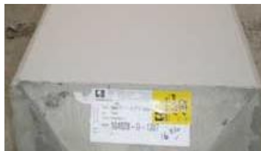
9.2. Viselad de esquinas para favorecer el desencofrado
