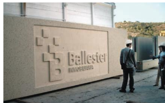
11.10. Tipos de acabados (matrices especiales). Ref. tecnyconta y Prevalesa
