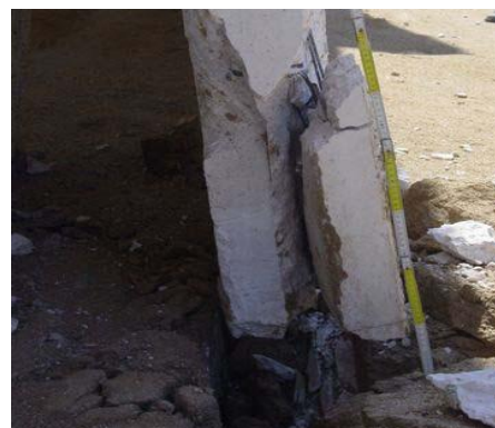
14.1. Accidentes en un forjado y en un panel por no respetar las tolerancias máximas
