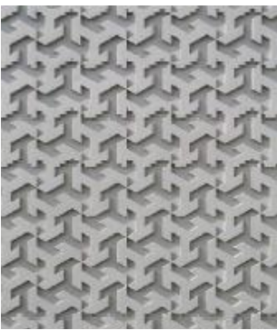
11.5. Tipos de acabados (con lámina de neopreno). Ref. Prevalesa y Preborquisa
