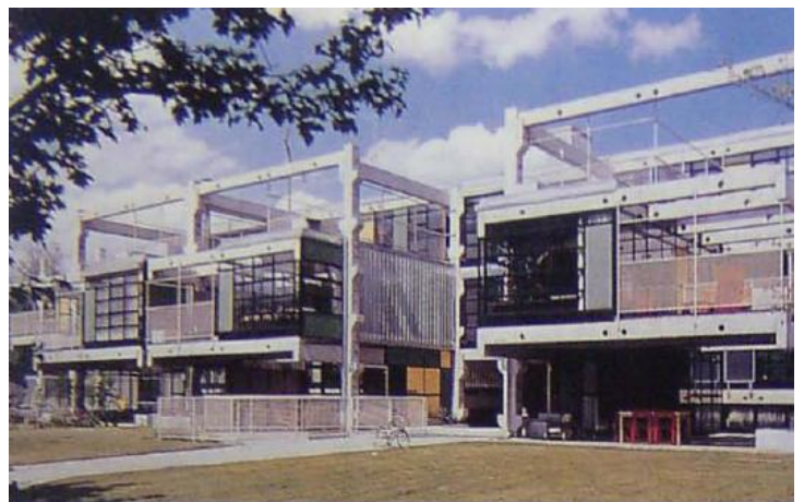
1.2. Viviendas de Otto Steider en Munich 1974
