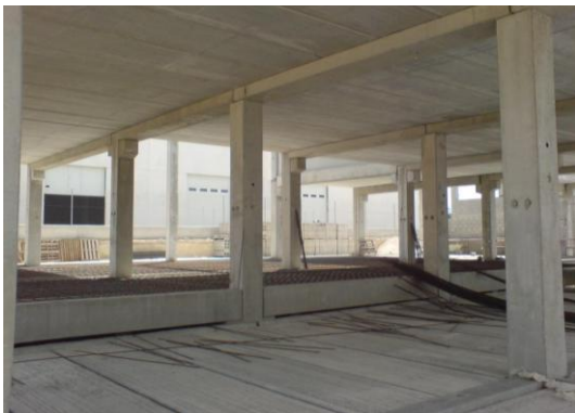
6.1. Union Viga Pilar Articulada (apoyo simple y a media madera), Ref. Prevalesa
