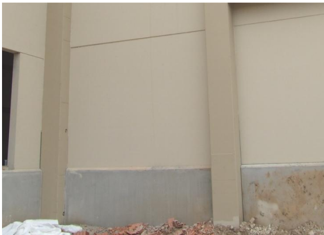
11.12. Con moldeo simple: fratasado. Ref. Prevalosa
