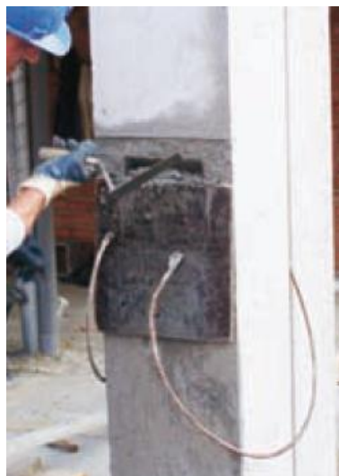
5.7. Proceso de montaje de un Pilar tipo Buzón, Ref. Rubiera
