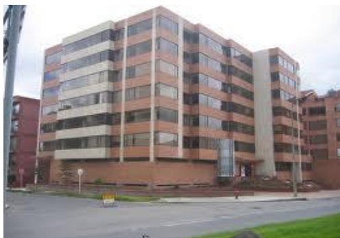
8.1. Fachada "in situ"
