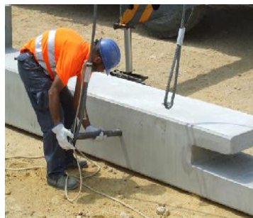
2.20. Acopio en obra, manipulado y posicionamiento del pilar, Ref. Prevalesa
