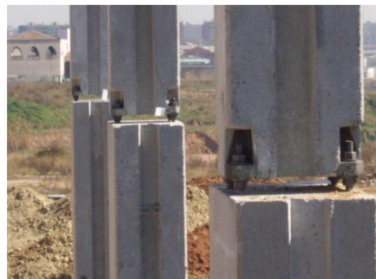
5.2. Unión Pilar-Pilar Atornillada, Ref. Uniones Piekko
