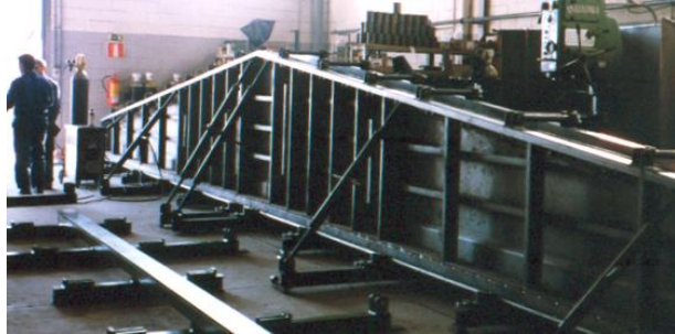
2.11. Molde Viga Delta
