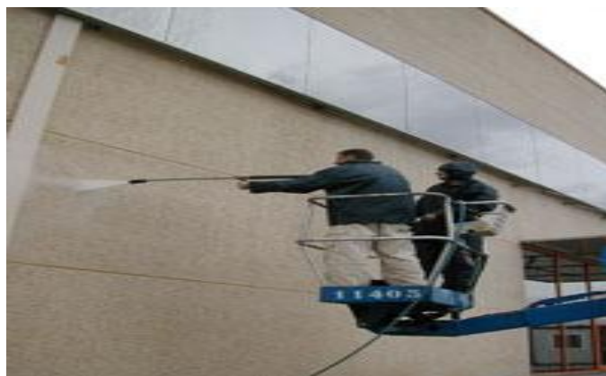
15.1. Limpieza de edificios prefabricados de hormigón, Ref. Grupo Bn
