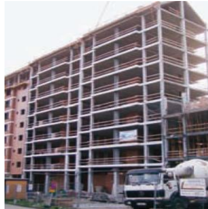
5.5. Ejemplo de edificio en altura con pilares Rubiera
