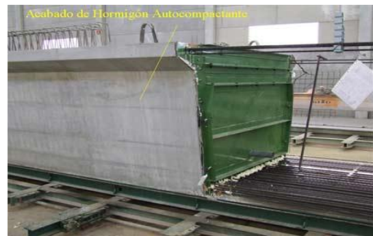
2.2. Acabado de vigas en U con hormigón autocompactante, Ref. Prevalesa
