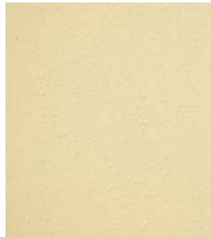
11.12. Con moldeo simple: fratasado. Ref. Prevalosa
