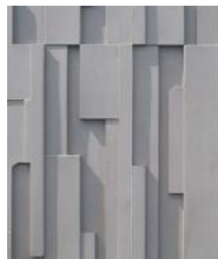
11.5. Tipos de acabados (con lámina de neopreno). Ref. Prevalesa y Preborquisa
