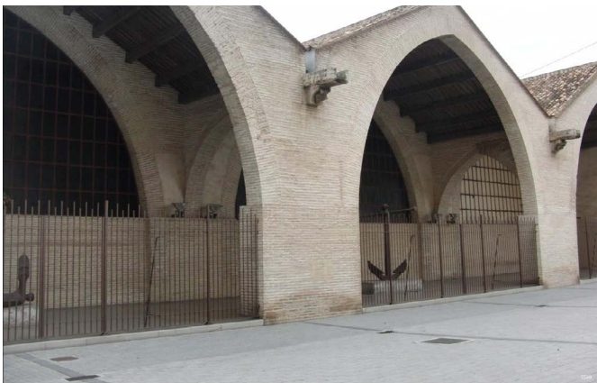
Fig 70. Imatge actual de l'exterior de les drassanes del port.
