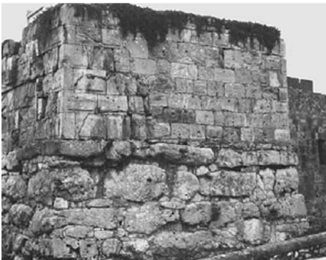
Fig 30. Carreus d' opus quadratum de la Torre de Minerva de la muralla de la ciutat datada sobre l'any 200 a. de C.
