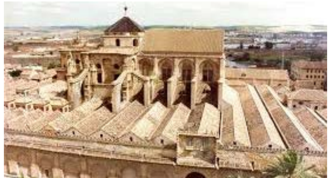
Fig 41. Cobertes independents a dos aigües de la mesquita de Córdoba.
