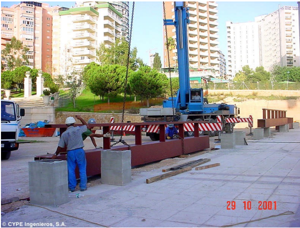
Imagen 33: Montaje final en obra por las limitaciones de transporte.
