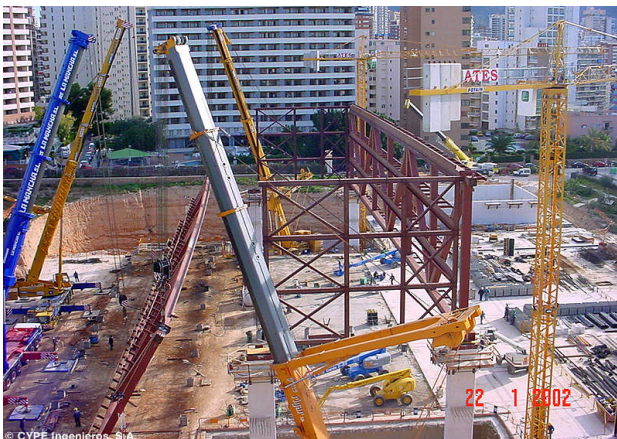
Imagen 35: Aprovisionamiento de la estructura mediante las piezas de arriostramiento.
