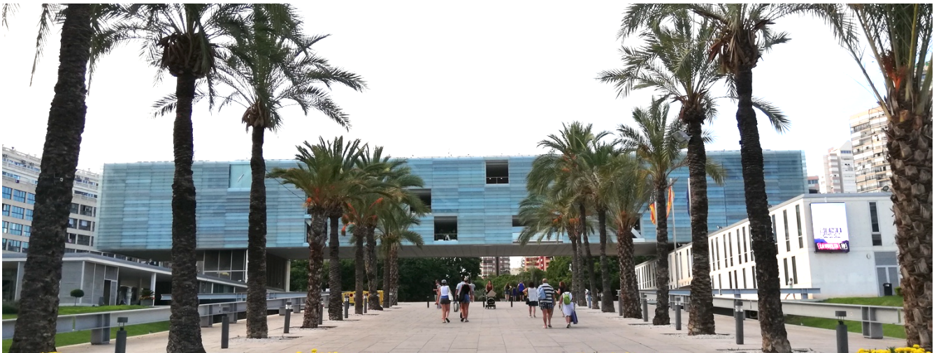
Imagen 23: Alzado sur. Fachada de lamas de vidrio serigrafiado.
