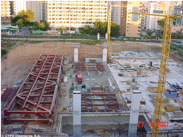
Imagen 32: Acopio de las estructuras metálicas en obra.
