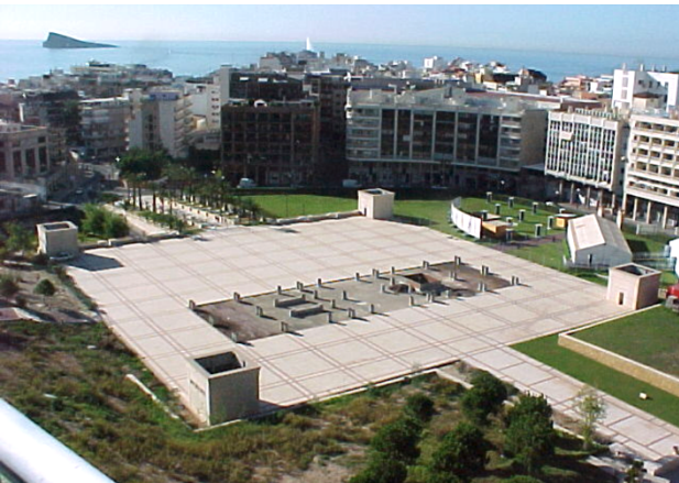
Imagen 14: Plaza a medio construir, antes del comienzo de las obras de la nueva sede del ayuntamiento.
