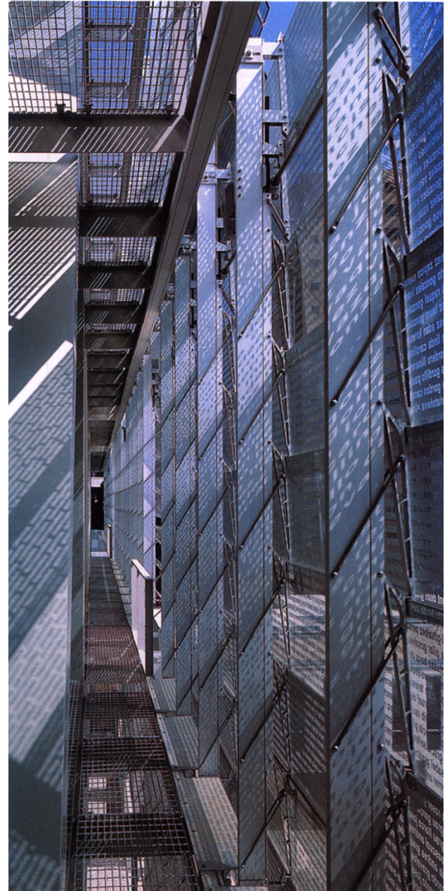
Imagen 38: Pasarela accesible de mantenimiento y limpieza.
