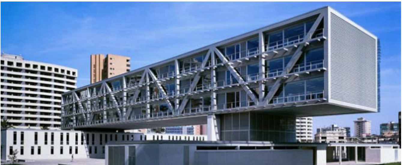
Imagen 25: Alzado norte. Cercha principal vista.
