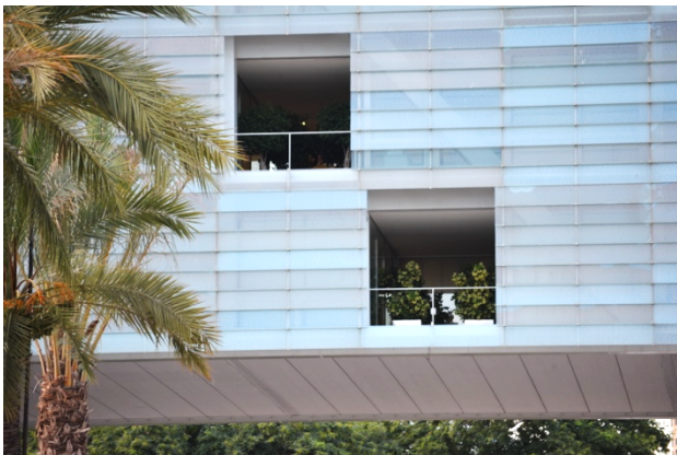
Imagen 39: Sistema de protección solar mediante lamas de vidrio serigrafiado.
