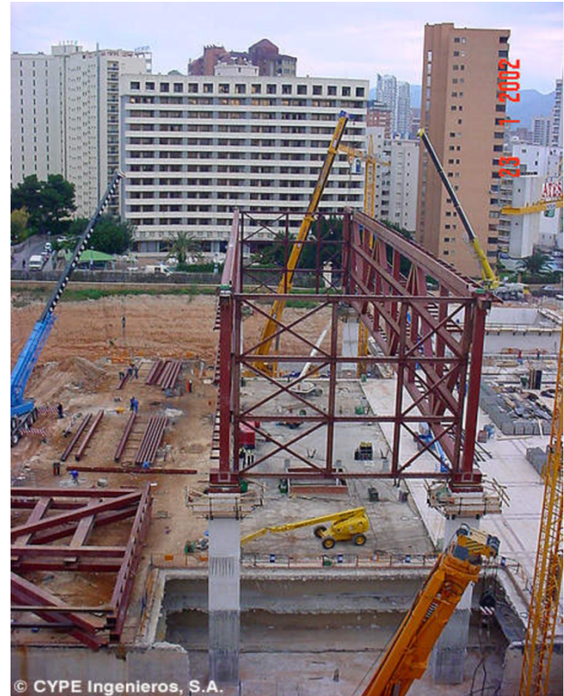
Imagen 36: Estructura aprovisionada a falta de voladizos.
