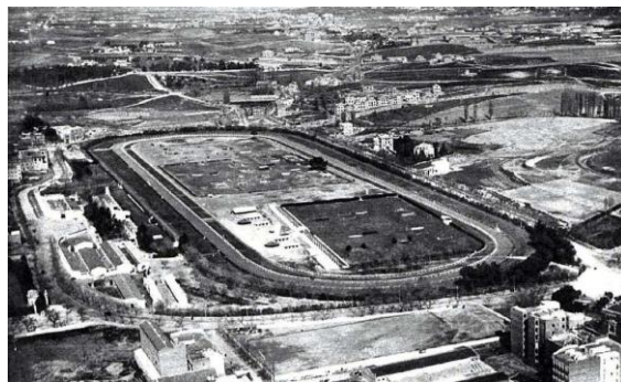
Figura 5. Vista aérea del Hipódromo Real de la Castellana
