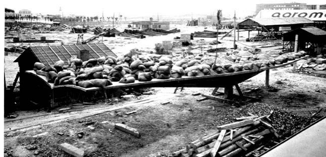
Figura 19. Ensayo de carga del módulo.
