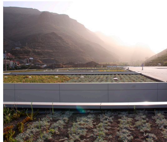
Hospital de la Gomera - Canvas Arquitectos.
