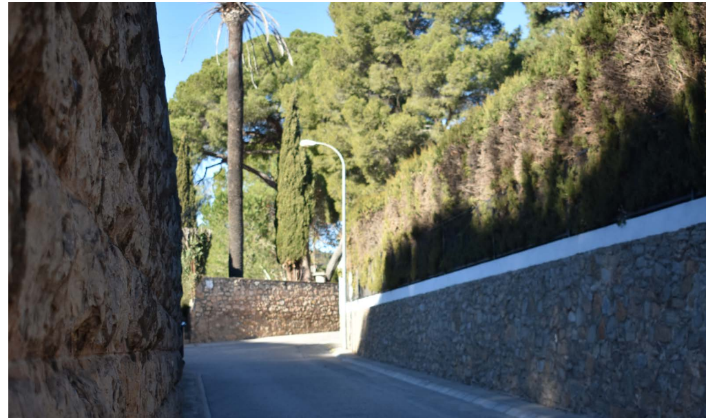
Muros y recorridos
