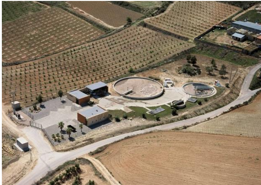
Figura 14. Vista aérea de la planta. Fuente: EPSAR
