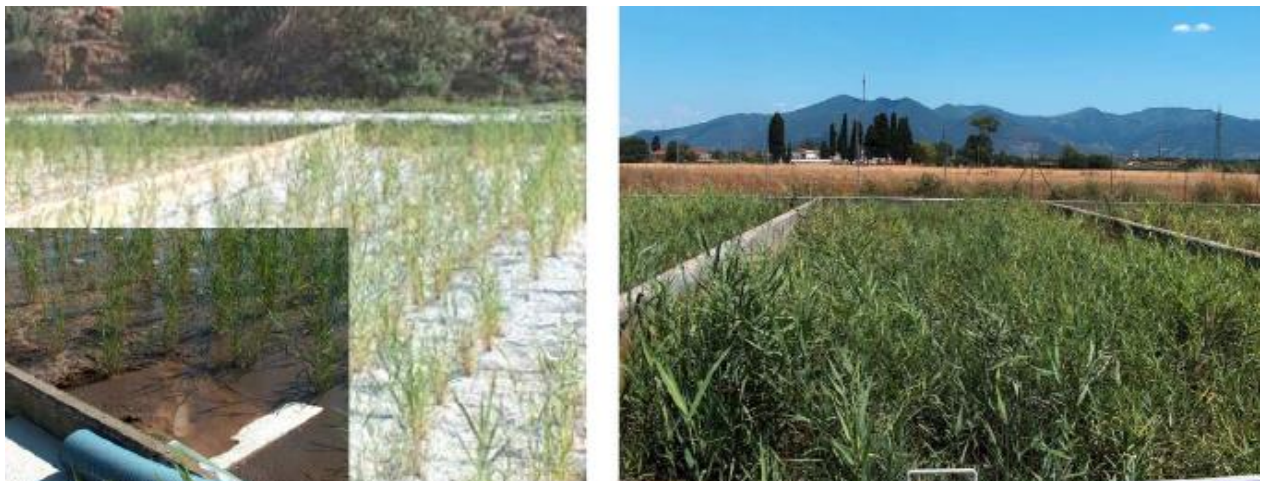
Figura 10. Lechos de carrizo en sistemas a escala real en Italia.
