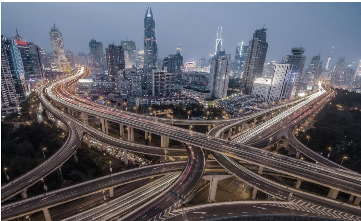
Fig. 3 Infraestructuras en Shanghai
