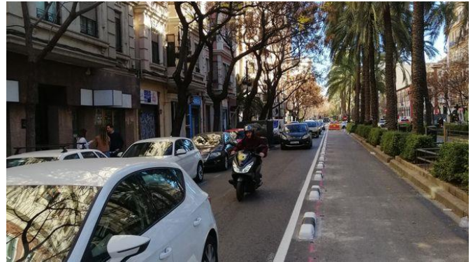
Fig.73: Avenida del Reino de Valencia con la construcción del carril bici (Fuente: https://www.eldiario.es/cv/Ciudadanos-Fiscalia-Regne-Valencia-Sindic_0_865114490.html )
