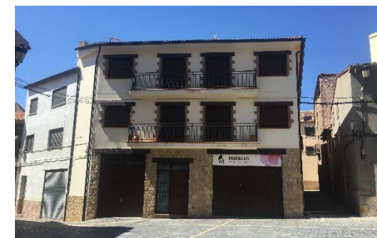
Figura 10. Fachada actual del edificio.
