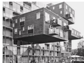
FIG 48. Voladizos de fachada. (Fuente: web "Plataforma arquitectura")
