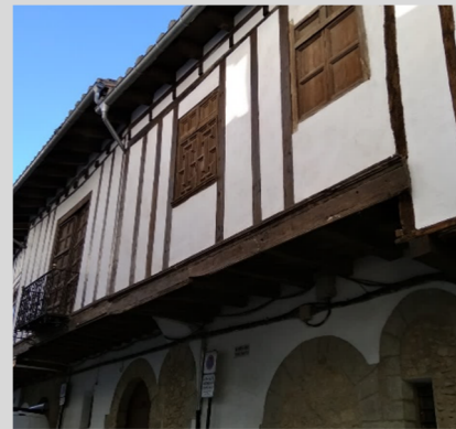
[Fig. 2.023] Fotografía vivienda plaza Tarrascons 4. Fuente: <E. Ripollés>.
