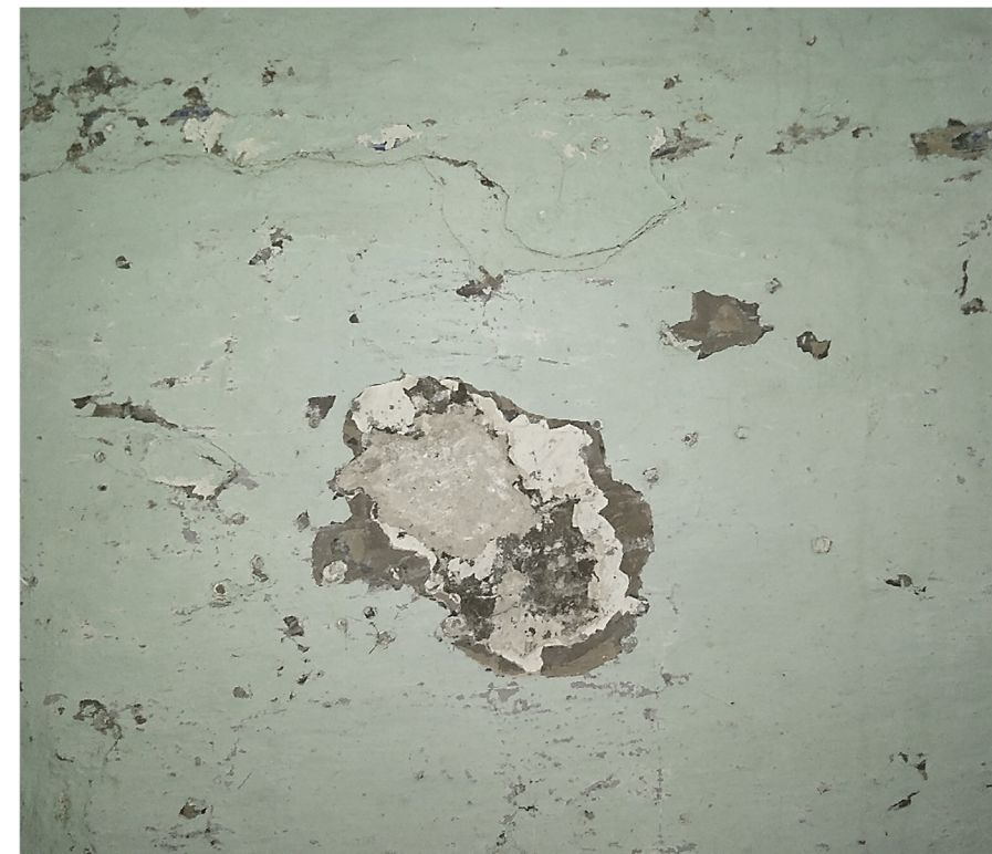
[Fig. 1.03] Fotografía de la cata tomada en la galería de la calle Virgen del Rosario, 28. Fuente: <E. Ripollés>.
