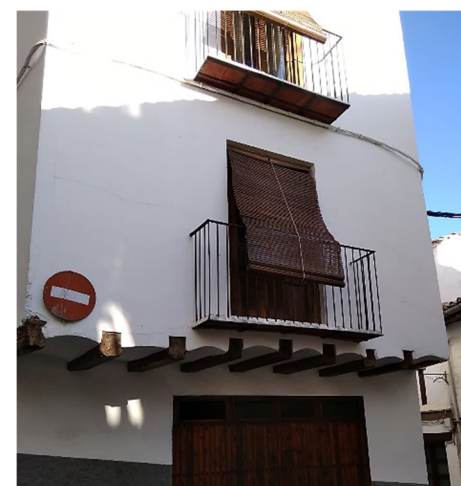
[Fig. 2.148] Fotografía vivienda plaza Tarrascons 1, galería de ladrillo. Fuente: <E. Ripollés>.
