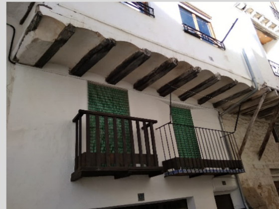
[Fig. 2.070] Fotografía vivienda calle del Sol 50-52. Fuente: <E. Ripollés>
