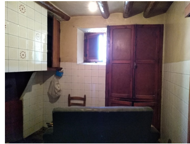
[Fig. 3.006] Fotografía interior 2 Vivienda Virgen del Rosario, 28. Fuente: <E. Ripollés>.
