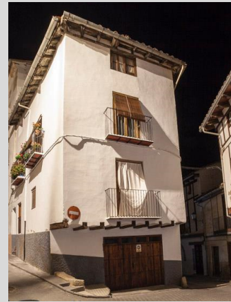
[Fig. 2.011] Fotografía vivienda plaza Tarrascons 1. Fuente: <E. Ripollés>.
