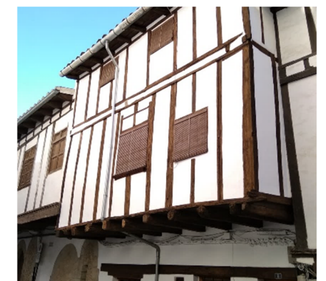
[Fig. 2.158] Fotografía vivienda plaza Tarrascons 5-6, pintura de color blanco. Fuente: <E. Ripollés>.
