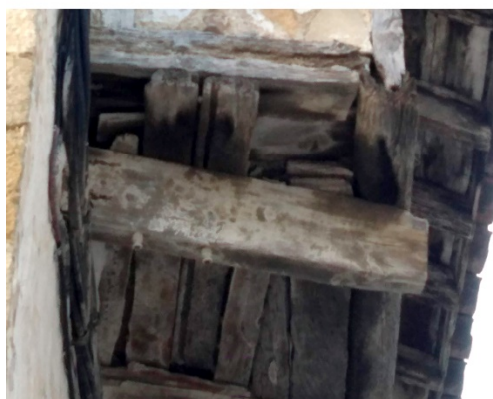
[Fig. 3.037] Fotografía detalle 2 alteración y deshidratación de la madera. Fuente: <E. Ripollés>.
