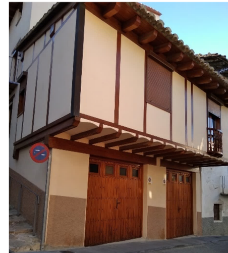
[Fig. 2.144] Fotografía vivienda calle Virgen del Rosario 25, fachada de muro de ladrillo más enlucido exterior. Fuente: <E. Ripollés>.
