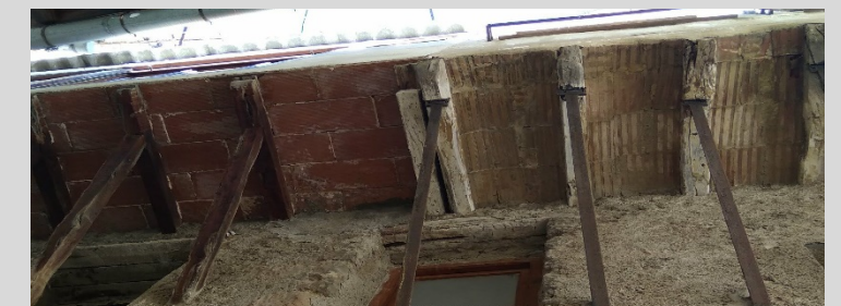
[Fig. 2.123] Fotografía detalle, Callejón de la Presó 19. Fuente: <E. Ripollés>.
