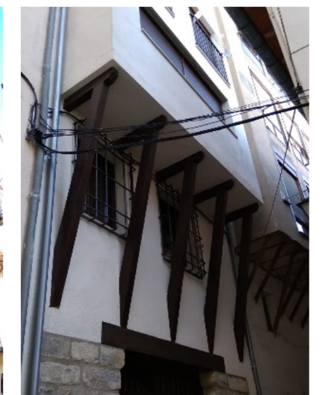
[Fig. 2.142] Fotografía vivienda callejón de la Presó 3A, galería REFORMADA. Fuente: <E. Ripollés>.
