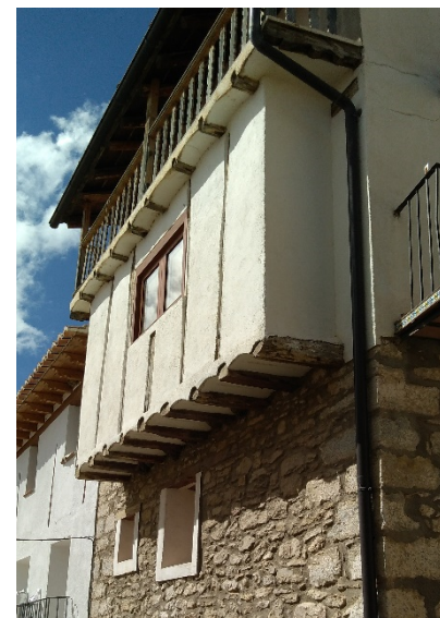
[Fig. 4.05] Fotografía galerías en Zorita. Fuente: <E. Ripollés>.
