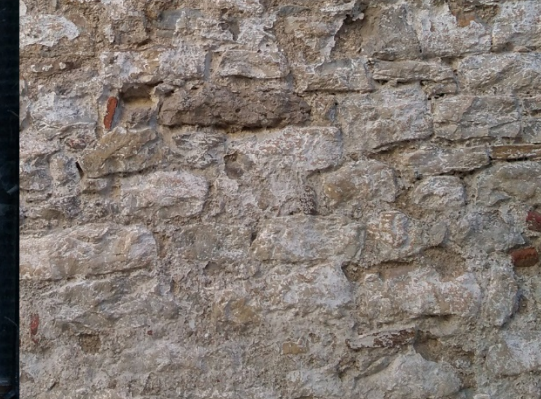
[Fig. 3.040] Fotografía detalle 2 pérdida de material. Fuente: <E. Ripollés>.
