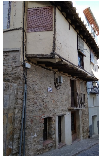
[Fig. 2.143] Fotografía vivienda calle Cofradía 1, fachada de muro de piedra visto. Fuente: <E. Ripollés>.
