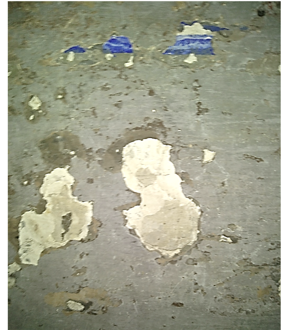
[Fig. 1.04] Fotografía de la cata tomada en la galería de la calle Virgen del Rosario, 28, de las capas de pintura y mortero. Fuente: <E. Ripollés>.
