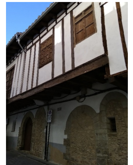
[Fig. 2.146] Fotografía vivienda plaza Tarrascons 4, fachada de muro de piedra más enlucido con arcos de piedra vista. Fuente: <E. Ripollés>.
