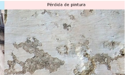
[Fig. 3.036] Fotografía detalle 1 pérdida de pintura. Fuente: <E. Ripollés>.
