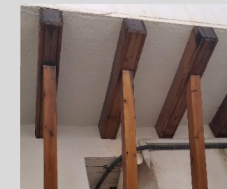
[Fig. 2.112] Fotografía detalle, Callejón de la Presó 13. Fuente: <E. Ripollés>.
