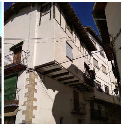
[Fig. 2.136] Fotografía vivienda calle del Sol 54-56, 2 alturas. Fuente: <E. Ripollés>.
