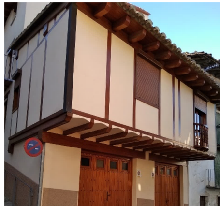
[Fig. 2.135] Fotografía vivienda calle Virgen del Rosario 25, 1 altura. Fuente: <E. Ripollés>.
