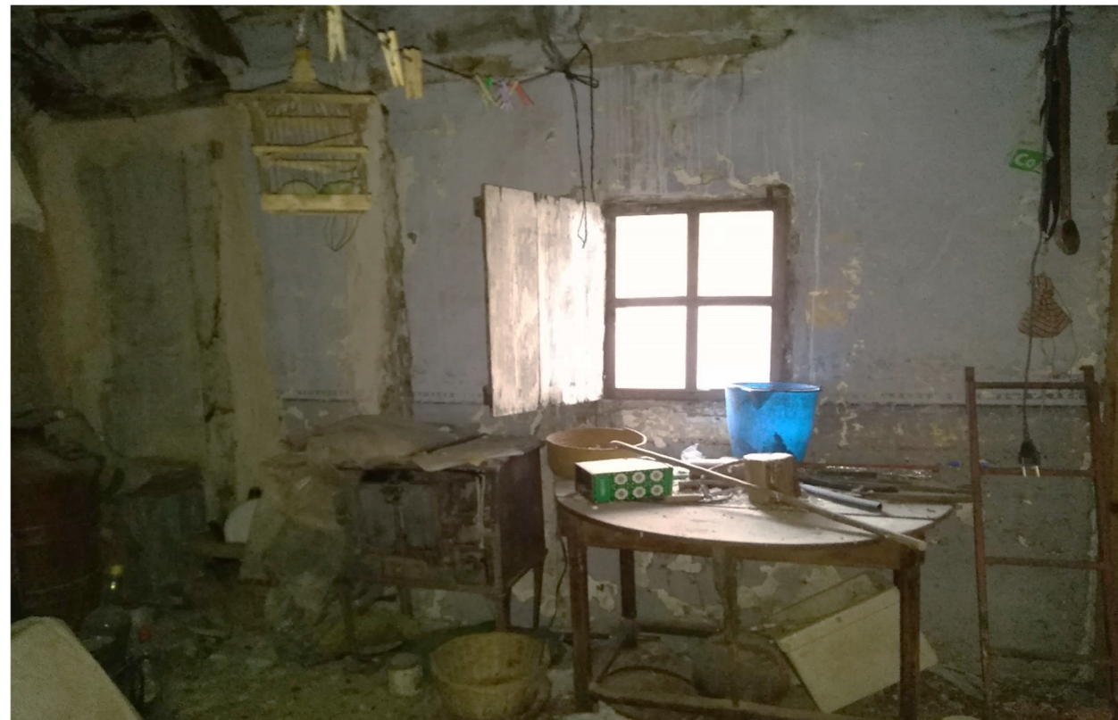
[Fig. 3.008] Fotografía interior 5 Vivienda Virgen del Rosario, 28. Fuente: <E. Ripollés>.
