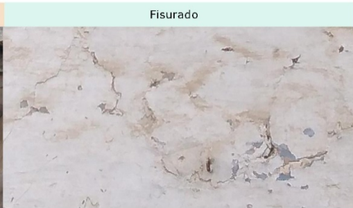
[Fig. 3.032] Fotografía detalle 1 fisurado. Fuente: <E. Ripollés>.
