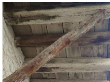
[Fig. 2.160] Fotografía vivienda calle Sol 46-48. Fuente: <E. Ripollés>.
