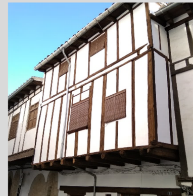
[Fig. 2.029] Fotografía vivienda plaza Tarrascons 5-6. Fuente: <E. Ripollés>.
