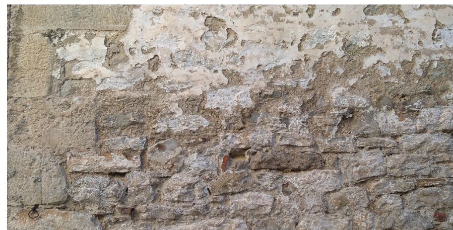
[Fig. 3.011] Fotografía detalle fachada de mampostería Vivienda Virgen del Rosario, 28. Fuente: <E. Ripollés>.
