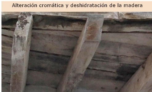
[Fig. 3.031] Fotografía detalle 1 alteración y deshidratación de la madera. Fuente: <E. Ripollés>.
