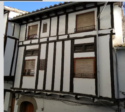
[Fig. 2.035] Fotografía vivienda plaza Tarrascons 7. Fuente: <E. Ripollés>.
