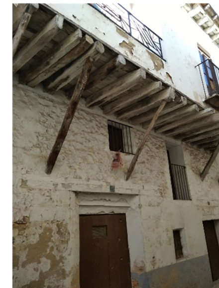
[Fig. 2.145] Fotografía vivienda calle Sol 46-48, fachada de muro de piedra más enlucido exterior. Fuente: <E. Ripollés>.
