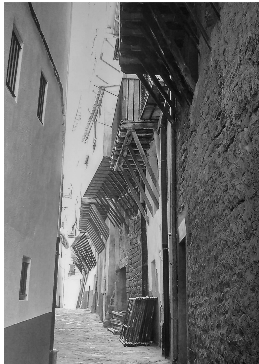
[Fig. 2.008] Fotografía del Callejón de la Presó. Fuente: <Miguel Ángel Trancho>.
