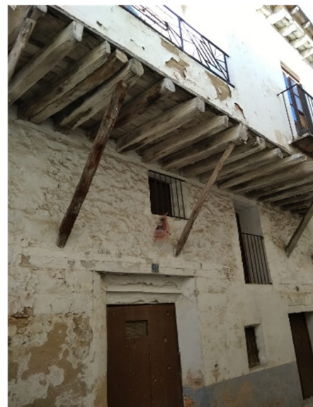
[Fig. 2.161] Fotografía vivienda calle Sol 46-48. Fuente: <E. Ripollés>.
