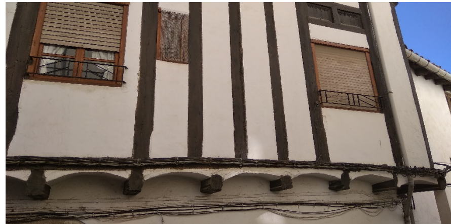
[Fig. 2.154] Fotografía detalle, Plaza Tarrascons 7 forjado con revoltones. Fuente: <E. Ripollés>.
