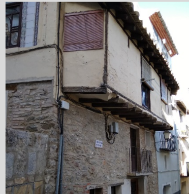
[Fig. 2.098] Fotografía vivienda calle Cofradía 1. Fuente: <E. Ripollés>.
