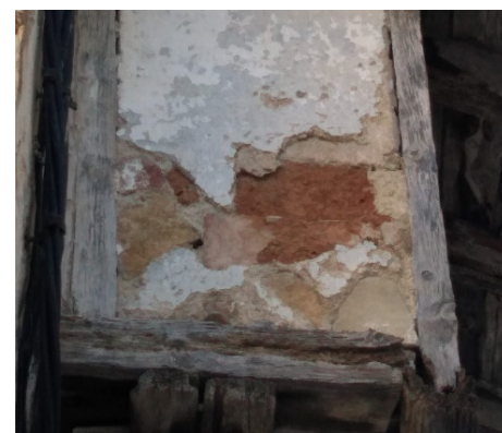
[Fig. 2.150] Fotografía vivienda calle Virgen del Rosario 28, detalle galería de lajas de piedra más montantes de madera vista. Fuente: <E. Ripollés>.
