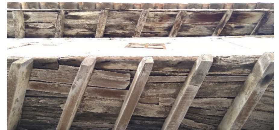
[Fig. 2.156] Fotografía detalle, calle Virgen del Rosario 28, forjado de tableros de madera. Fuente: <E. Ripollés>.
