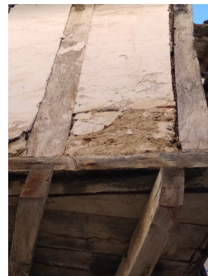
[Fig. 2.162] Fotografía vivienda calle Sol 46-48. Fuente: <E. Ripollés>.
