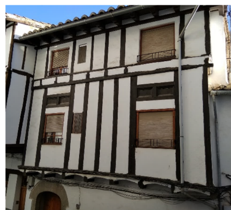
[Fig. 2.147] Fotografía vivienda plaza Tarrascons 7, galería de ladrillo más montantes de madera vista. Fuente: <E. Ripollés>.
