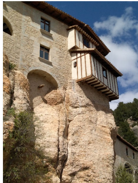
[Fig. 4.03] Fotografía galerías en el Santuario de la Balma. Fuente: <E. Ripollés>.
