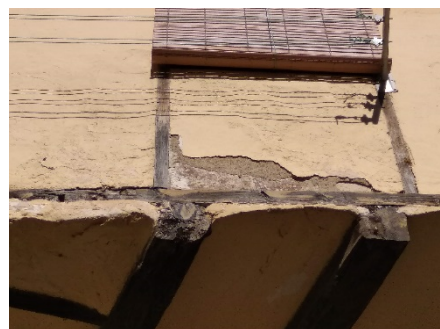
[Fig. 2.159] Fotografía vivienda Calle Cofradía 1. Fuente: <E. Ripollés>.
