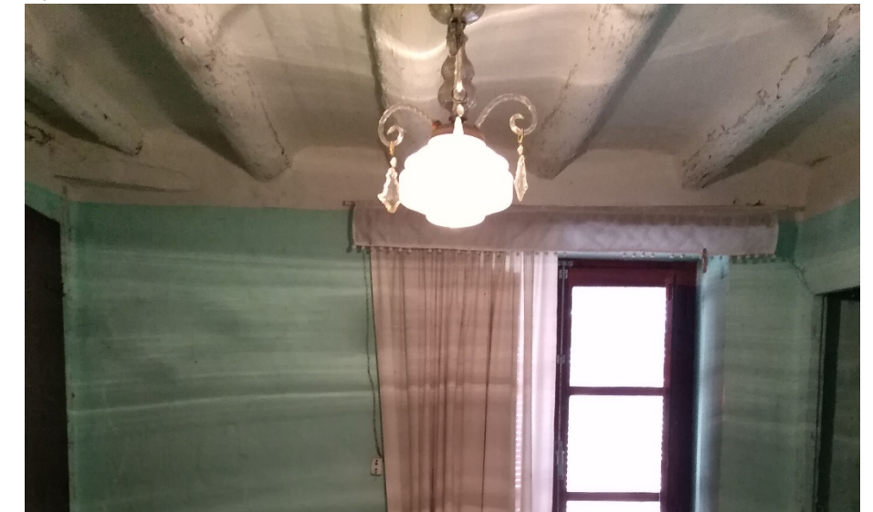
[Fig. 3.019] Fotografía detalle forjado de revoltones vivienda Virgen del Rosario, 28. Fuente: <E. Ripollés>.
