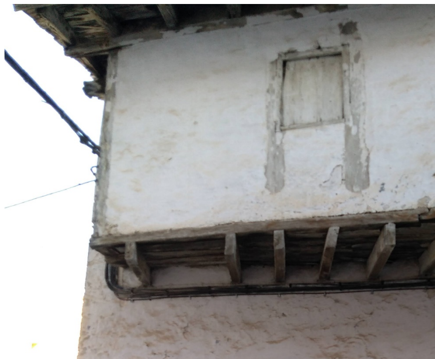
[Fig. 3.015] Fotografía detalle carpintería vivienda Virgen del Rosario, 28. Fuente: <E. Ripollés>.
