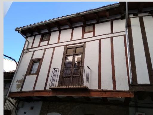
[Fig. 2.017] Fotografía vivienda plaza Tarrascons 2-3. Fuente: <E. Ripollés>.
