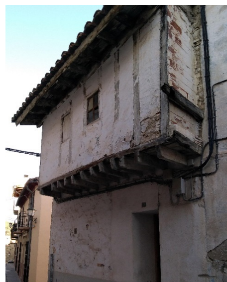
[Fig. 2.149] Fotografía vivienda calle Virgen del Rosario 28, galería de lajas de piedra más montantes de madera vista. Fuente: <E. Ripollés>.
