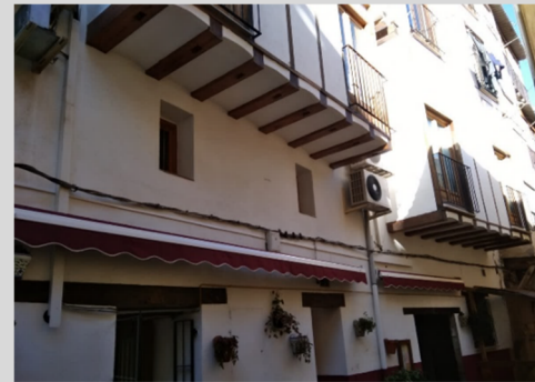
[Fig. 2.093] Fotografía vivienda calle de Fortea 4-6. Fuente: <E. Ripollés>.
