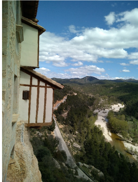
[Fig. 4.02] Fotografía galerías en el Santuario de la Balma. Fuente: <E. Ripollés>.
