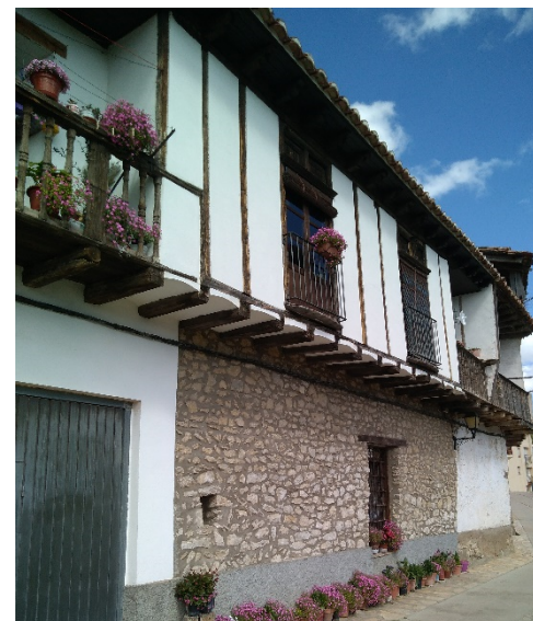
[Fig. 4.104] Fotografía galerías en Zorita. Fuente: <E. Ripollés>.
