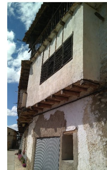
[Fig. 4.06] Fotografía galerías en Zorita. Fuente: <E. Ripollés>.
