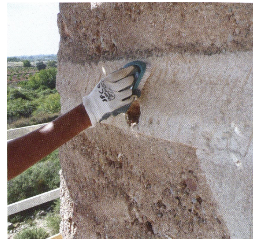
[Fig. 3.054] Detalle limpieza de la fachada con cepillo manual. Fuente: < VEGAS, F Y MILETO, C. Aprendiendo a restaurar. COAV ED., Valencia, 2011 (pp. 370)>.
