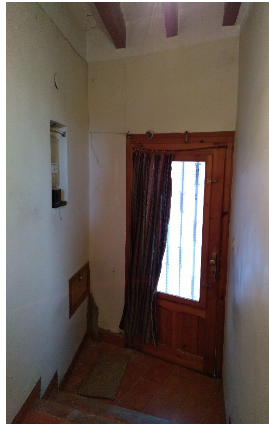
[Fig. 3.005] Fotografía interior 1 Vivienda Virgen del Rosario, 28. Fuente: <E. Ripollés>.
