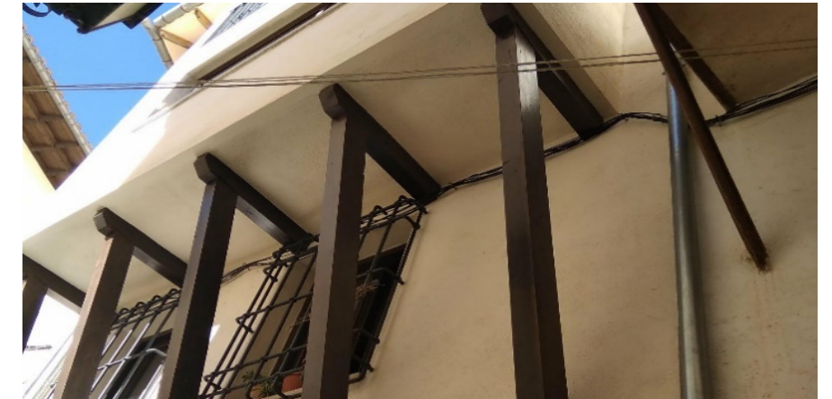
[Fig. 2.155] Fotografía detalle, Callejón de la Presó 3ª, forjado con rasillas cerámicas. Fuente: <E. Ripollés>.
