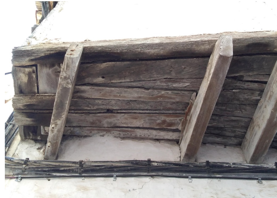
[Fig. 3.017] Fotografía detalle forjado de entablado de listones de madera vivienda Virgen del Rosario, 28. Fuente: <E. Ripollés>.
