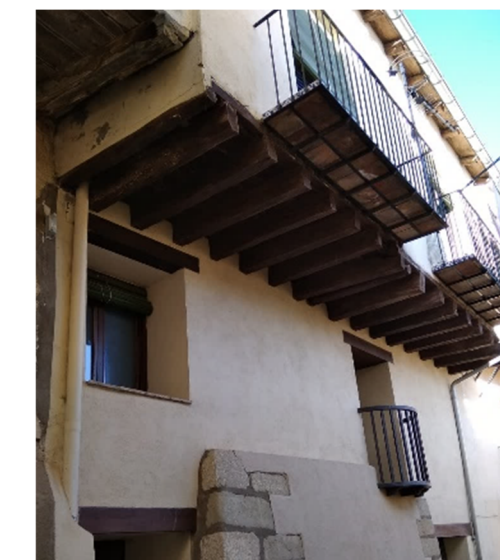
[Fig. 2.141] Fotografía vivienda calle Sol 38, galería REFORMADA. Fuente: <E. Ripollés>.
