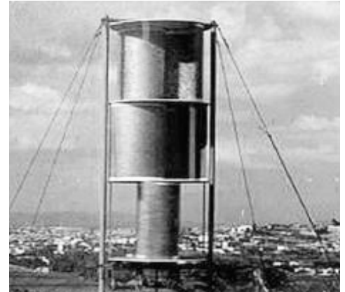
Fig 21. Rotor Savonius
