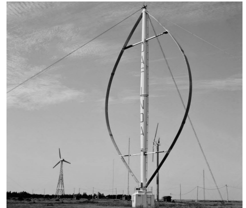
Fig 22. Rotor Darrieus
