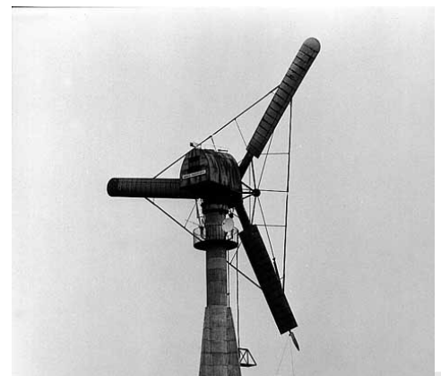
Fig 23. Aerogenerador de 200kW, Dinamarca
