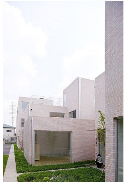
Ilustración 122, exterior apartamentos Seijo, SANAA, 2007
