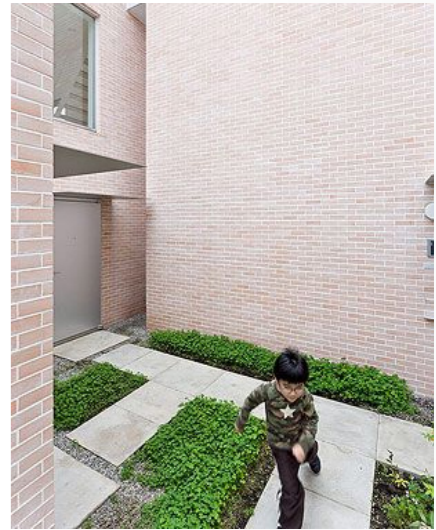
Ilustración 121, exterior apartamentos Seijo, SANAA, 2007
