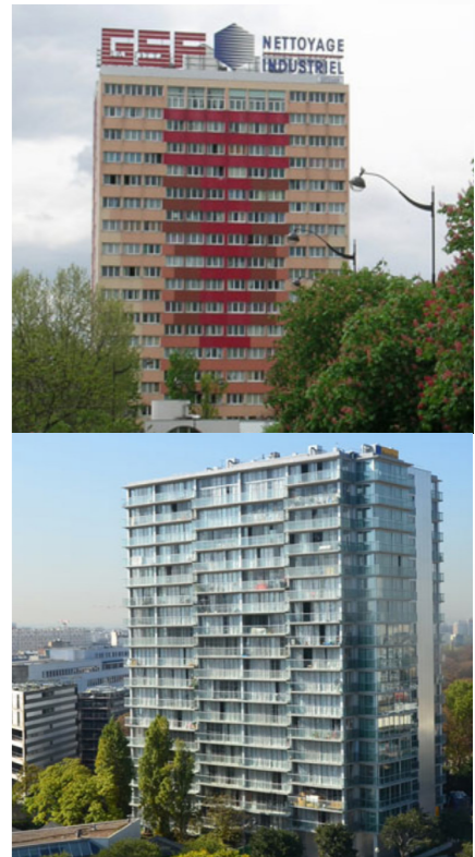
Ilustración 27, transformación proyecto Bois le pretre, Lacaton y Vassal, 2011
