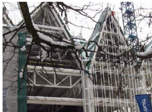
Imagen 26 Cerchas vistas a través de la fachada
