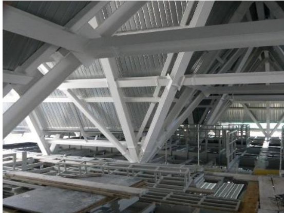
Imagen 23 Estructura de techo
