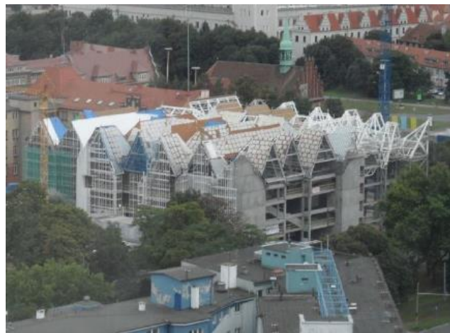
Imagen 22 Ejecución de la cubierta
