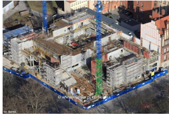
Imagen 20 Elementos de hormigón ejecutados
