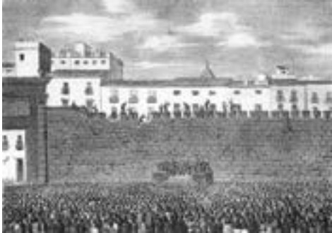
Figura 21. Derribo de la muralla
