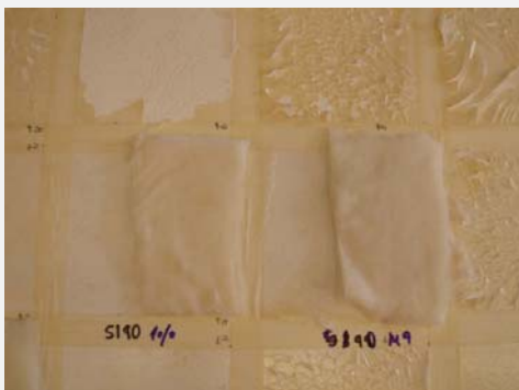
Detalle tras el retiro del portante
