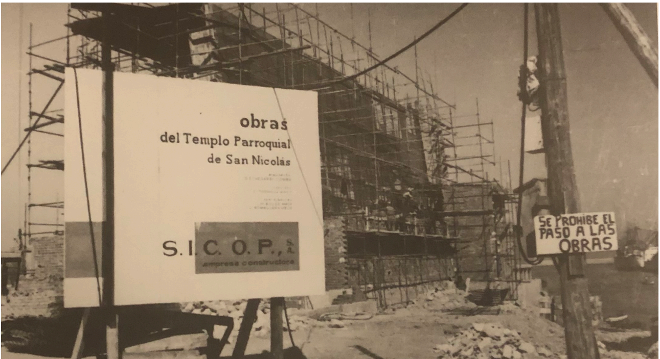
(Imagen.2.4, Imagen de la construcción de la obra)
