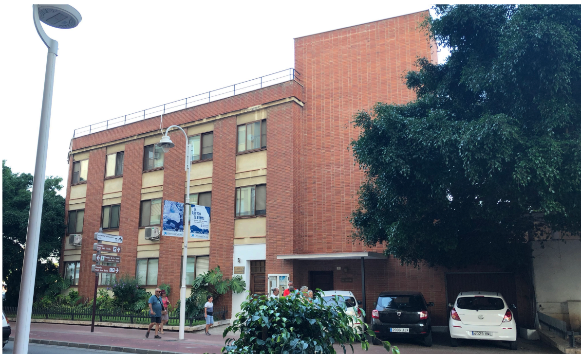
(Imagen.3.17, Fachada principal de la Casa Abadía)
