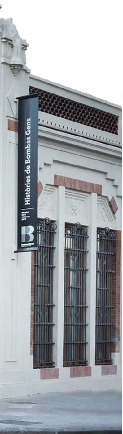
Ilustración 17: Fotografía de la fachada principal. Fuente: < https://www.ramonesteve.com/pro/arquitectura/cultura-y-educacion/bombas-gens/ >
