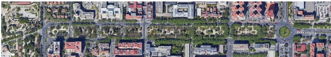
Ilustración 20: Vista aérea Primer Tramo Paseo al Mar. Fuente: Google Earth
