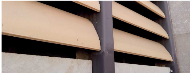
Figura 138. Vista lamas cerámicas, edificio de instalaciones.
