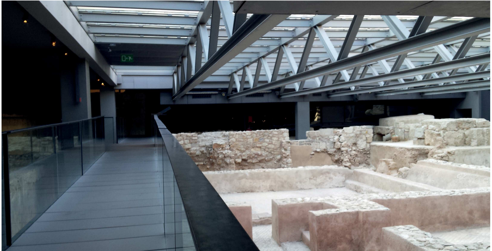
Figura 124. Vista de la estructura del subsuelo, cercha, pilares y vigas.
