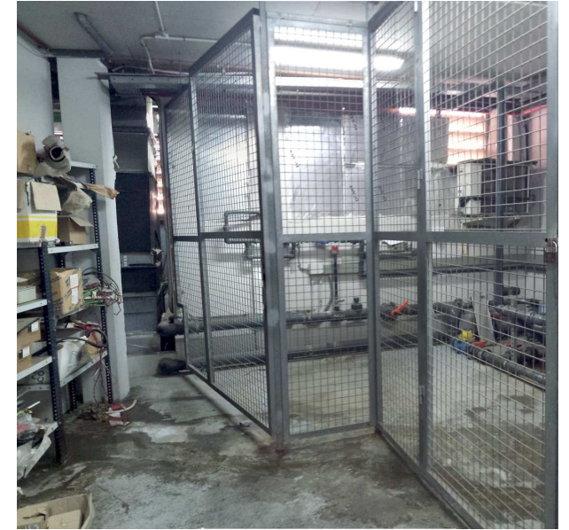
Figura 122. Vista del interior de la planta primera.
