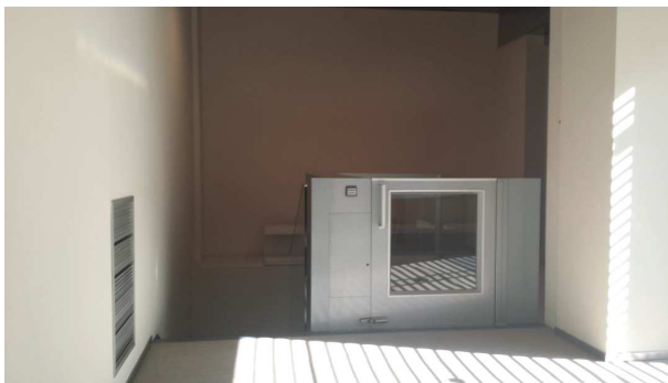
Figura 115. Vista del montacargas que baja a planta sótano.
