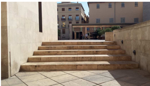
Figura 77. Escaleras de acceso desde la calle de la Leña.
