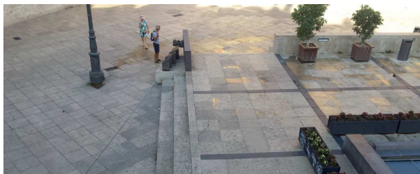
Figura 79. Escaleras de acceso por la plaza de l'Almoína.
