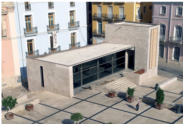
Figura 134. Vista al edificio secundario.
