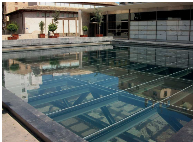
Figura 143. Vista del estanque y edificio principal.
