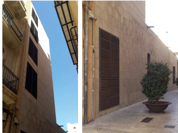
Figura 141. Vistas del edificio de instalaciones.
