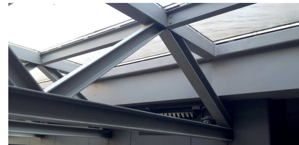
Figura 129. Vista de la cercha en detalle.
