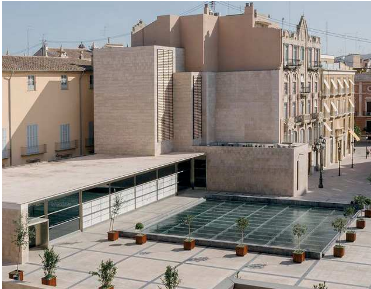
Figura 133. Vista de la plaza de Décimo Junio Bruto. Edificio principal.
