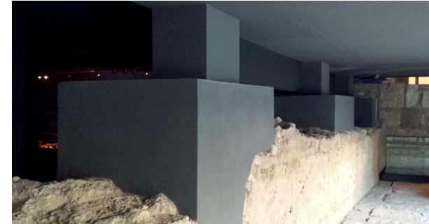
Figura 130. Vista de la cimentación, mediante encepados.
