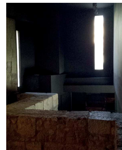
Figura 151. Vista iluminación interior
