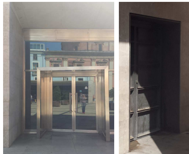
Figura 142. Puerta de acceso edificio principal y secundario.
