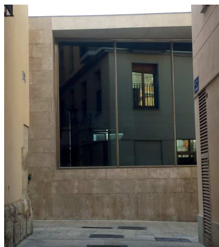
Figura 149. Vista del gran ventanal.
