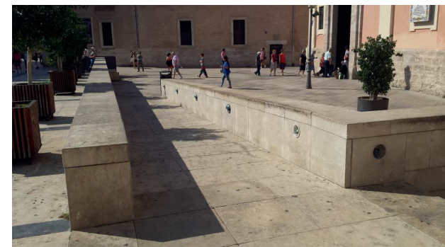
Figura 78. Rampa de acceso desde la calle de la Leña.
