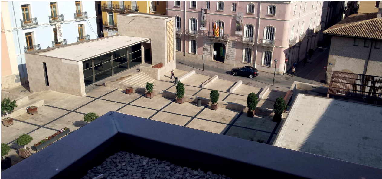
Figura 76. Perspectiva desde la cubierta del edificio de instalaciones.
