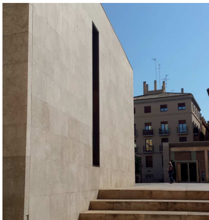
Figura 146. Vista rasgadura en el lateral del edificio secundario que da a la plaza.
