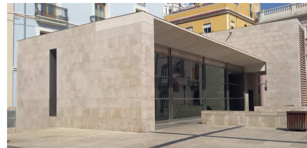
Figura 106. Vista del edificio secundario.
