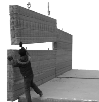
PASO 4. Colocación de piezas mediante bulones en losa de cimentación
