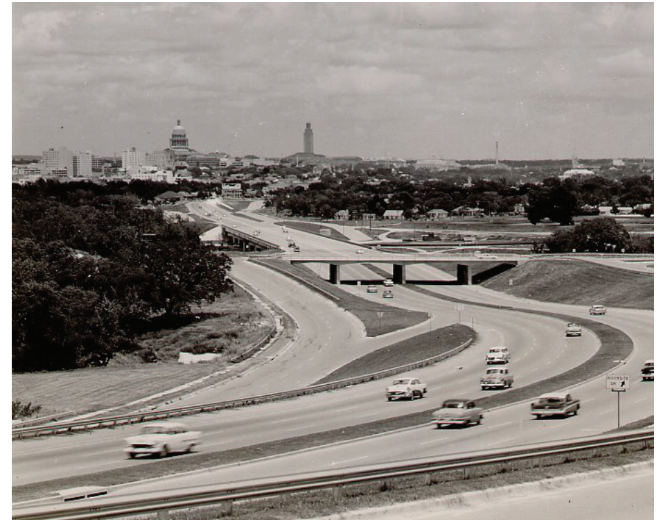
Fig 18. La autopista la I-35 tras su construcción. Al fondo se observan los tres elementos que representan las tres zonas de la ciudad. De izquierda a derecha, la silueta del Downtown, la gran cúpula del Capitolio y la torre de la Universidad.
