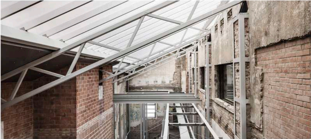
Imagen 13. Centro Cívico Lleialtat Santsenca 1214, recuperado de: harquitectes.com
