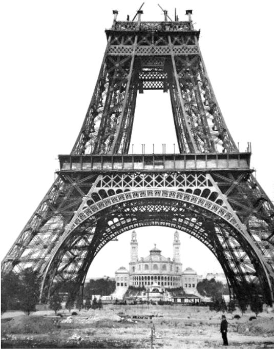
Figura 6. Proceso constructivo de la Torre Eiffel en 1888, G. EIFFEL, 1889.
