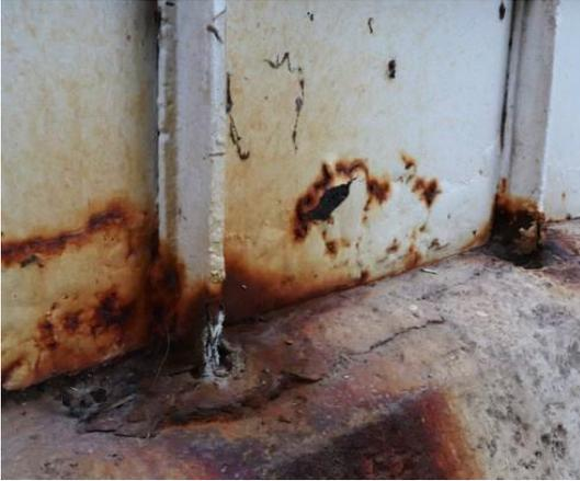
La estructura metálica del invernadero presenta distintos grados de oxidación dependiendo de la zona en la que se encuentre, centrándose el mayor grado de degradación en el encuentro con el zócalo.
