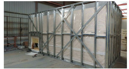
FIGURA 63: Módulo en proceso de fabricación.
