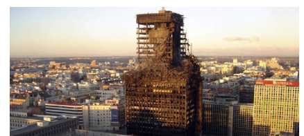
FIGURA 23: Edificio Windsor destruido en 2005 por un incendio.
