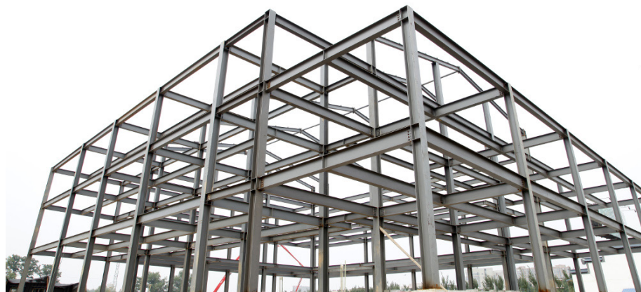
FIGURA 46: Estructura metálica porticada de uso convencional conformada a base de perfiles de acero laminados en caliente.
