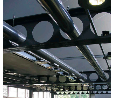
FIGURA 50: Vigas aligeradas que permiten el paso de instalaciones.
