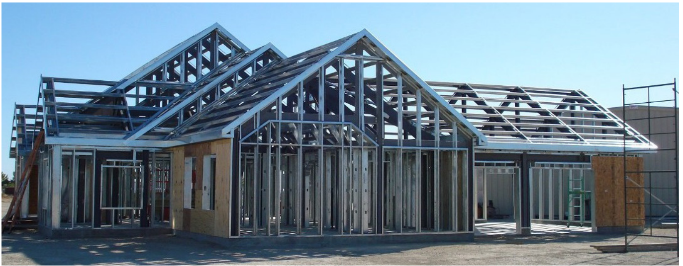
FIGURA 60: Vivienda unifamiliar construida a través del sistema conocido como Steel Frame.
