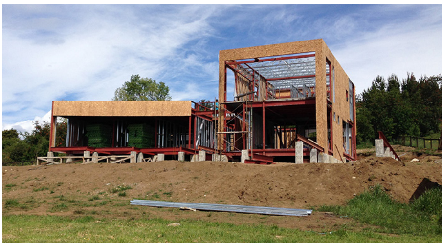
FIGURA 94: Construcción de la casa donde se muestra la estructura resistente junto con el refuerzo de la estructura del steel frame.
