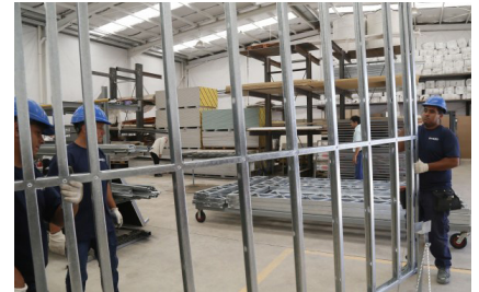
FIGURA 64: Operarios manipulando un panel prefabricado.
