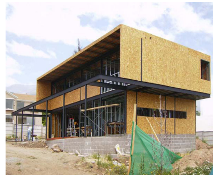
FIGURA 103: Construcción casi terminada de la vivienda.
