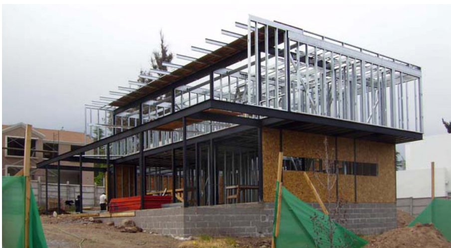
FIGURA 101: Construcción de la vivienda a base de la estructura de steel frame.
