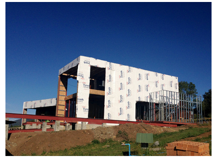
FIGURA 96: Vivienda en construcción las zonas de steel frame.
