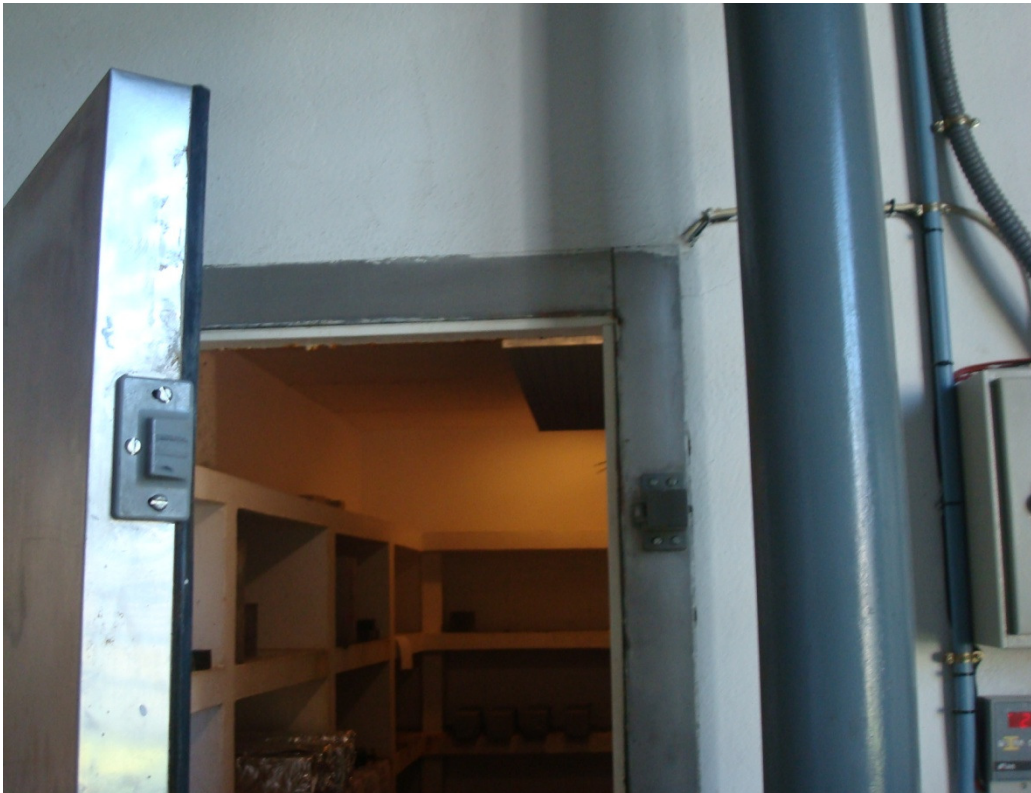
*Imagen 3.13. Cámara húmeda
