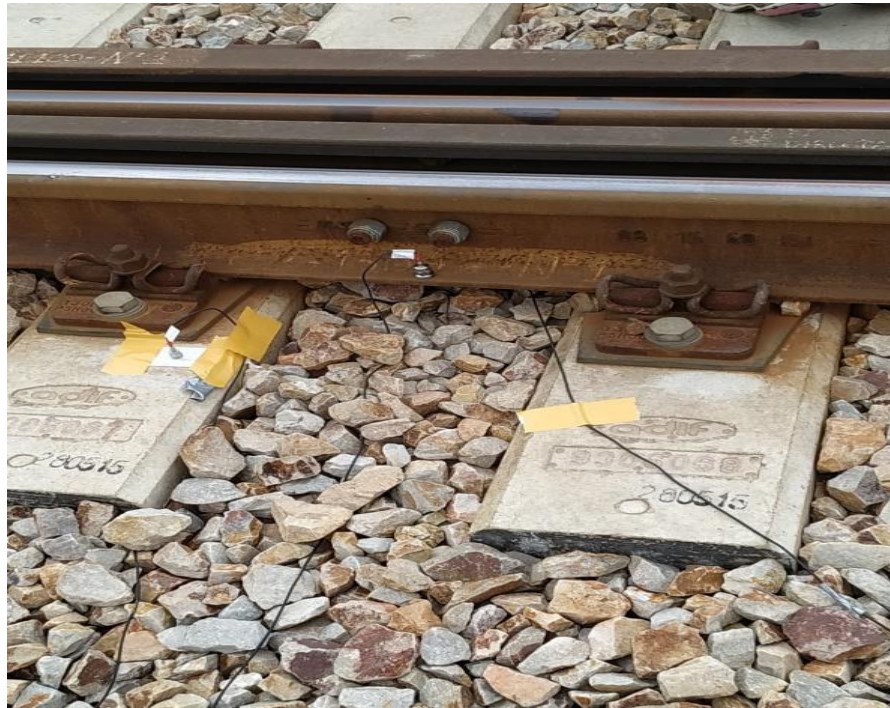
Figura 21. Acelerómetros piezoeléctricos en carril y traviesa Fuente: Elaboración propia
