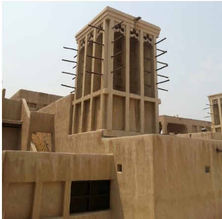
Figura 48. Torre de viento de tres huecos verticales. Museo del Jeque Saeed Al Maktoum, Dubái. (Fuente: Neila, 2014)
