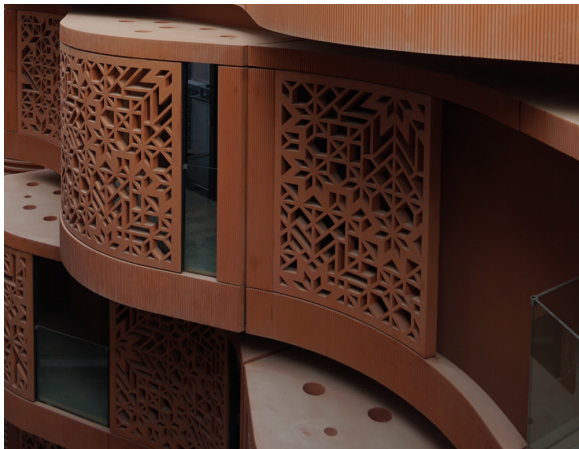
Figura 56. Mashrabiya en la fachada de un edificio residencial. (Fuente: ACME en Flickr)
