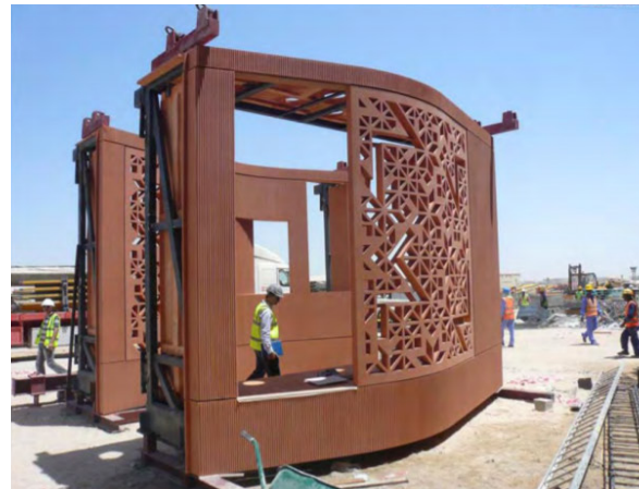
Figura 57. Montaje de la fachada de los edificios de residencias del MIST. (Fuente: Ross Palmer, 2011: 13)
