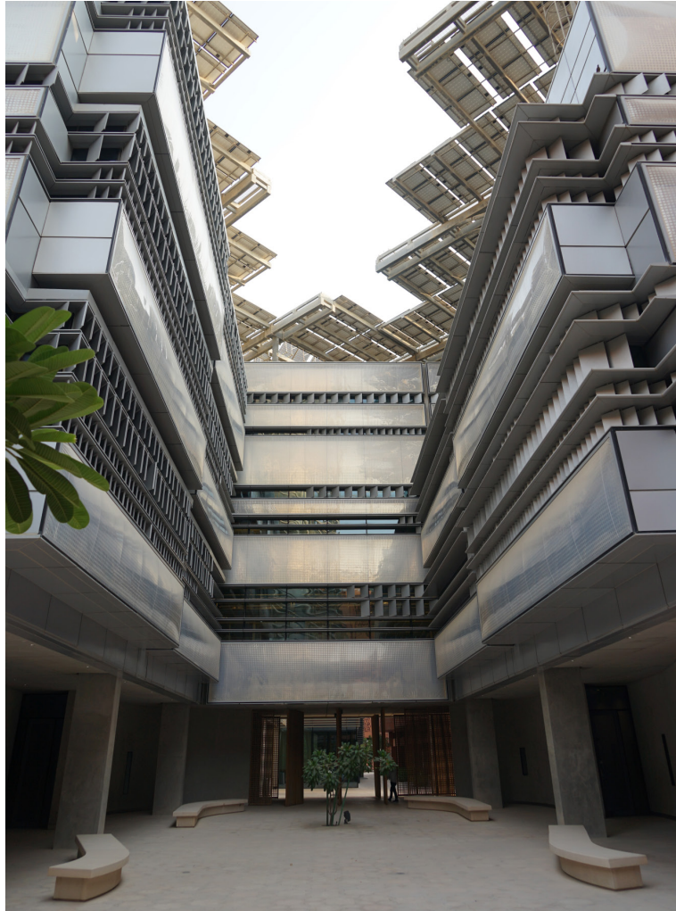
Figura 61. Placas solares fotovoltaicas salientes en los edificios del MIST. (Fuente: ACME)
