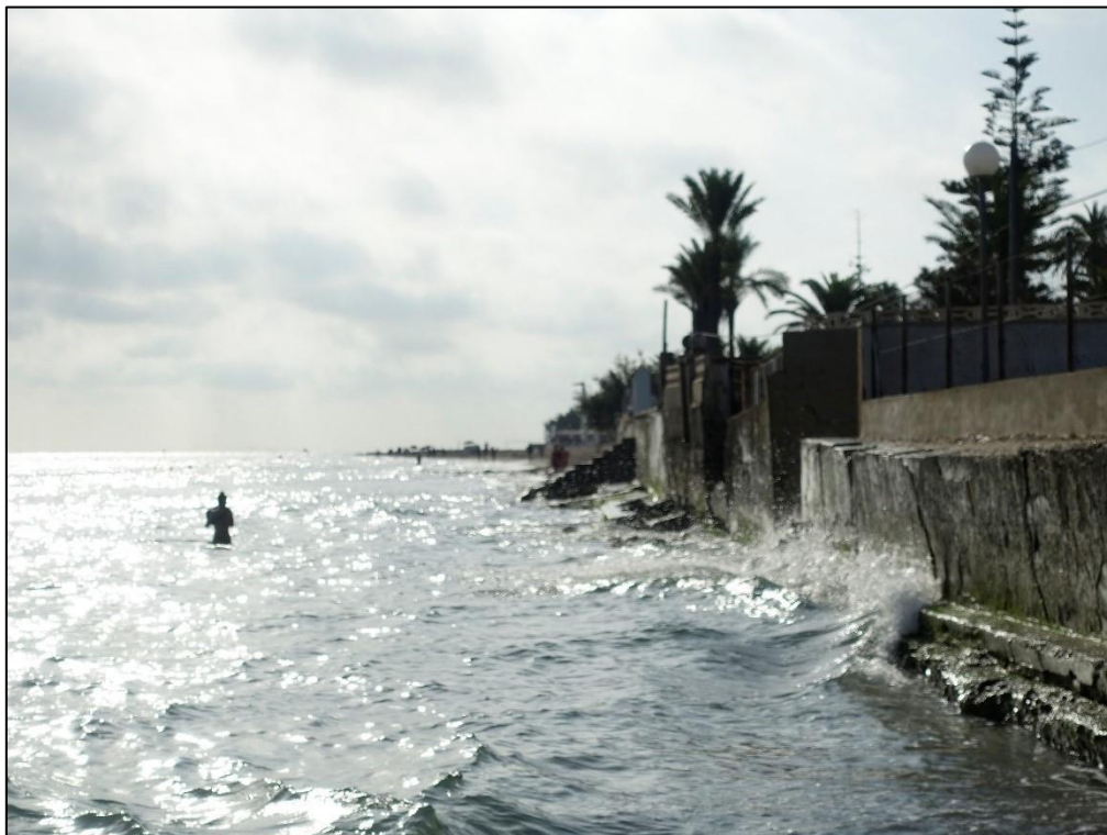
Figura 3. Estado actual del frente costero Les Marines-Blay Beach
