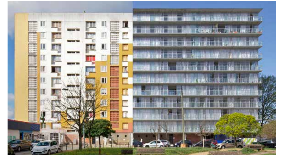
FIGURA 61: Antes y después de la intervención (Lacaton y Vassal)
