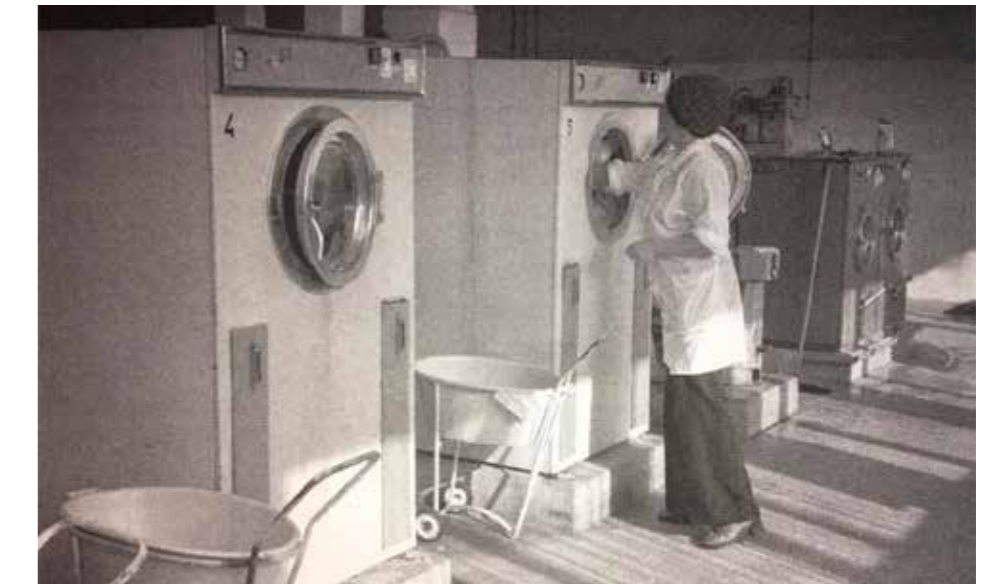
FIGURA 20: lavanderias en planta baja Rataje 1945 (Blokowska pg.63)
