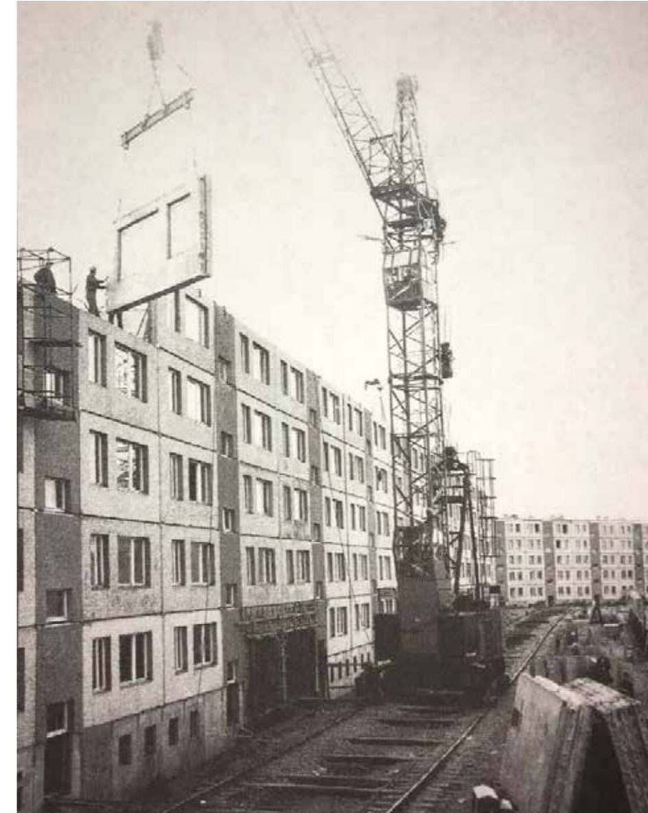
FIGURA 25: Transporte a obra de paneles prefabricados (Blokowiska pg.70) 1967
