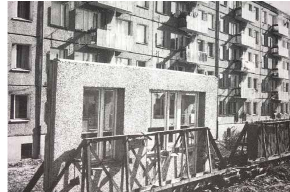
FIGURA 21: Transporte a obra de paneles prefabricados (Blokowiska pg.70) 1967
