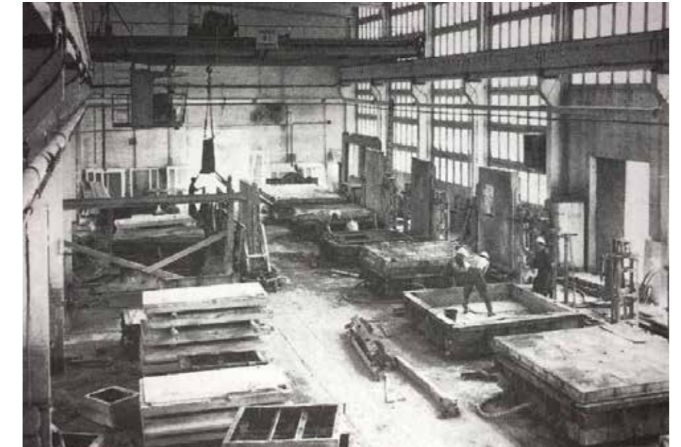
FIGURA 22: Fabricas de paneles prefabricados (Blokowiska pg.73) 1967
