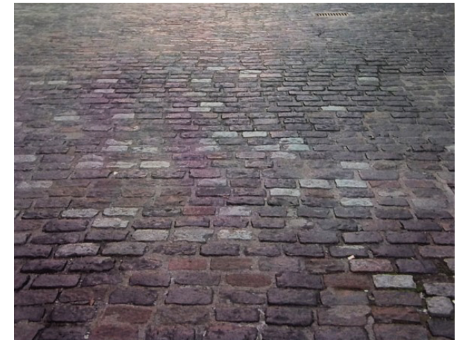
IMG 162: Detalle de pavimentos históricos del patio central
