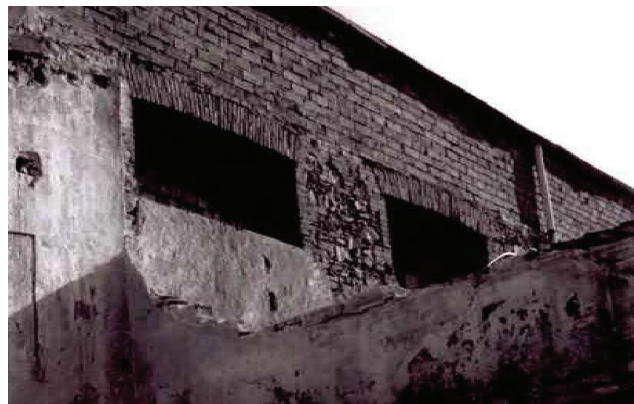
IMG 116: Fachada Nave C anterior a la intervención
