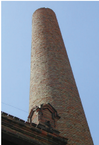
IMG 55: Chimenea en obra de fábrica, Anterior a la intervención
