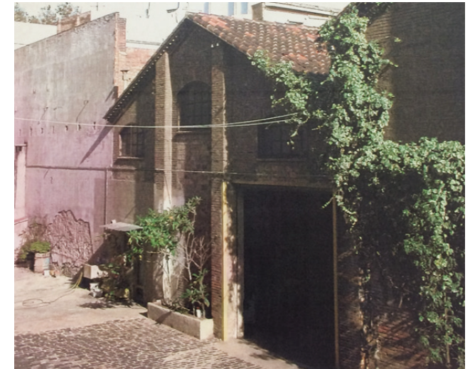
IMG 166: Estado Nave B anterior a la intervención
