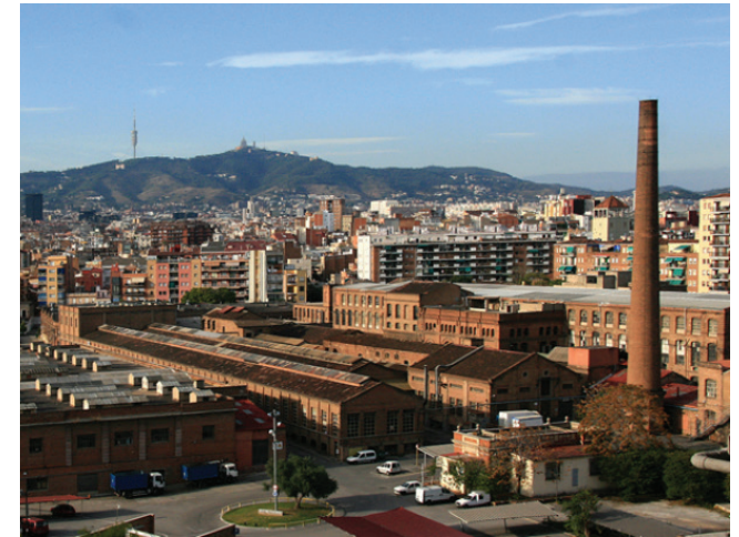
IMG 5: Ejemplo de edificaciones icónicas en las ciudades: Complejo Fabril Can Batlló
