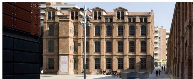
IMG 92: Vista exterior desde la plaza posterior a la intervención
