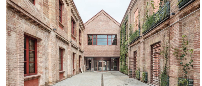
IMG 66: Espacio intermedio entre Nave A y C , Posterior a la intervención
