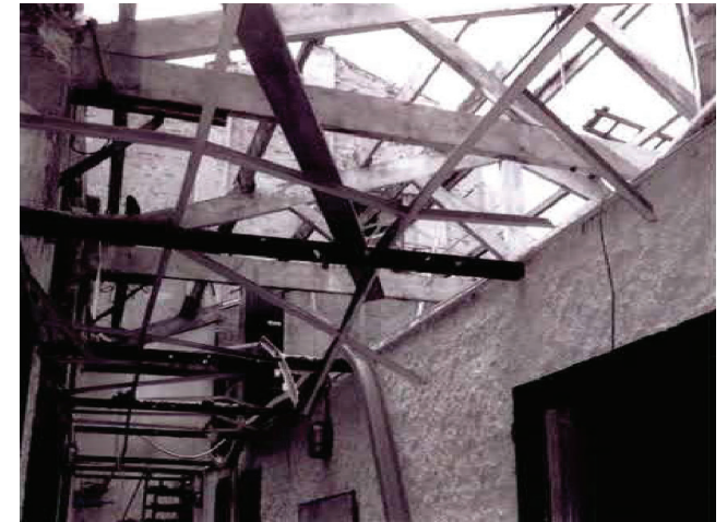
IMG 117: Cubierta Nave C anterior a la intervención
