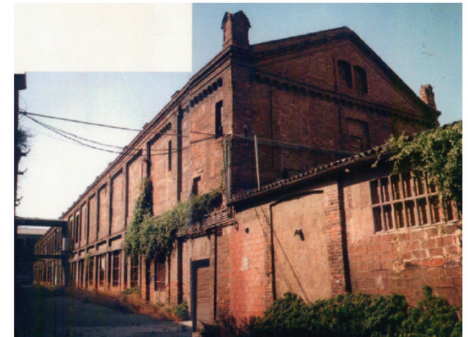
IMG 50: Fotografía Nave A, Anterior a la intervención
