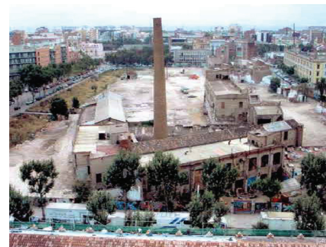
IMG 107: Estado del conjunto fabril anterior a la intervención
