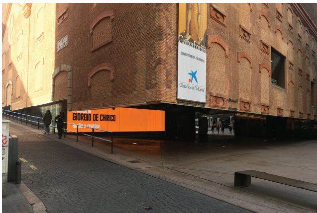
IMG 18: Exteriores proyecto Caixa Forum en la ciudad de Madrid
