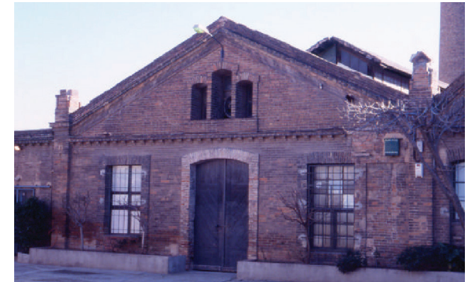
IMG 49: Fotografía Nave A, Anterior a la intervención
