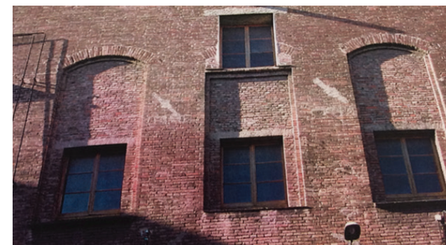
IMG 172: Detalle de Fachada
