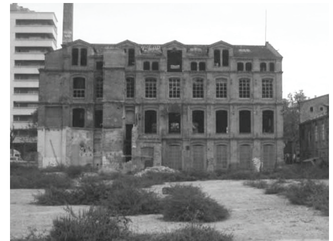
IMG 82: Estado de la Nave A anterior a la intervención
