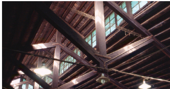
IMG 58: Cercha Tipo Nave A, Anterior a la intervención
