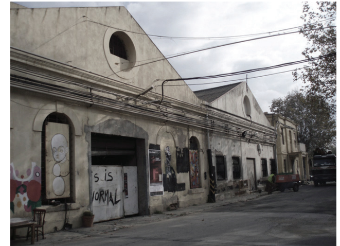
IMG 142: Estado Nave A y B anterior a la intervención
