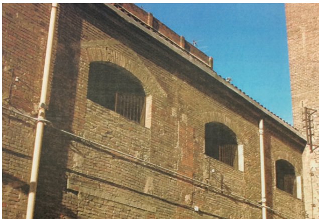
IMG 169: Estado Nave C anterior a la intervención
