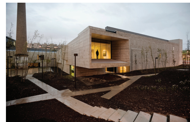
IMG 122: Estado del complejo después de la intervención, Nuevo volumen que remplace a la Nave C
