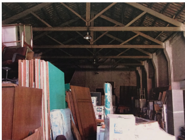
IMG 168: Interiores Nave B anterior a la intervención
