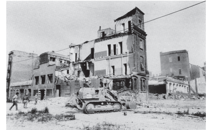
IMG 27: Fotografía histórica de los derribos en el barrio del Poblenou en los años 50
