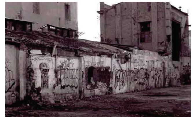
IMG 118: Volumetría Nave C anterior a la intervención
