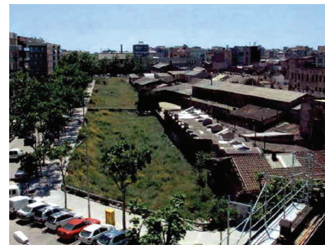
IMG 108: Estado del conjunto fabril anterior a la intervención
