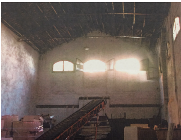
IMG 170: Interiores Nave C anterior a la intervención
