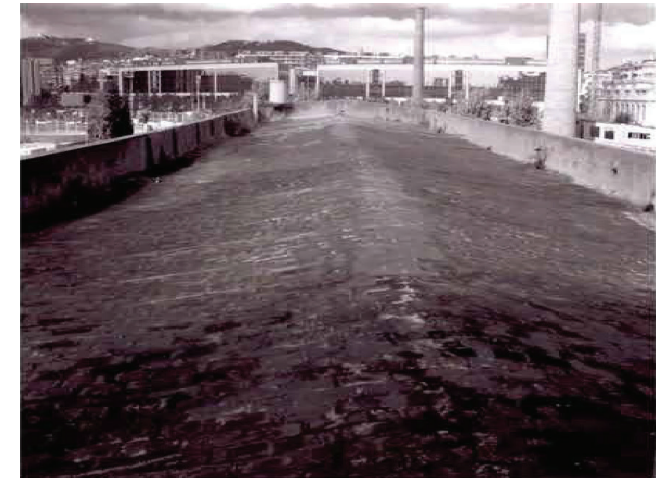
IMG 111: Cubierta Nave A anterior a la intervención
