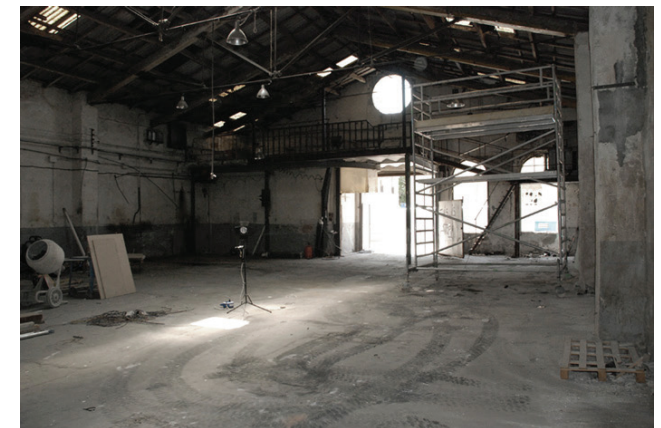
IMG 143: Interior Nave B anterior a la intervención
