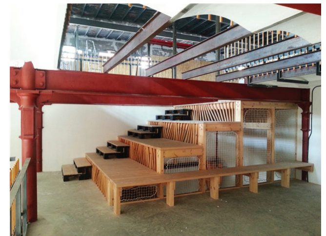
IMG 11: Intervención interior en el complejo fabril de Can Batlló
