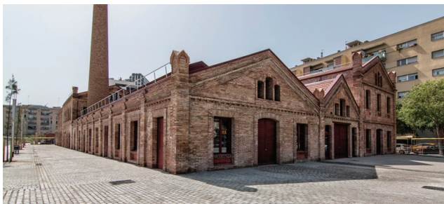
IMG 62: Exteriores complejo fabril , Posterior a la intervención
