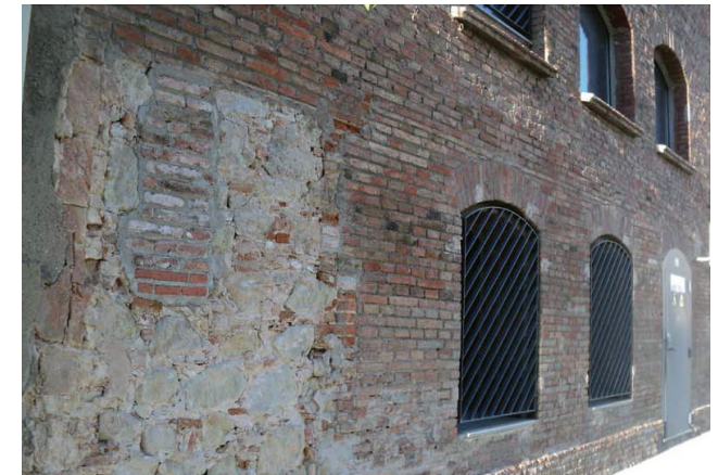
IMG 177: Detalles acabados de fachada
