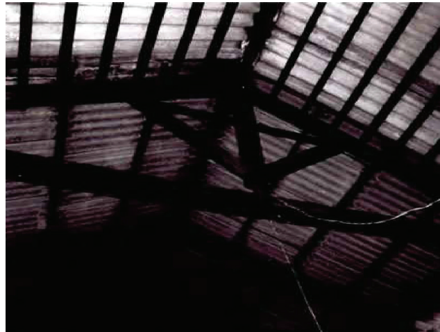
IMG 115: Cubierta Nave B anterior a la intervención
