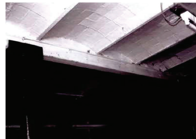
IMG 114: Forjados Nave B anterior a la intervención
