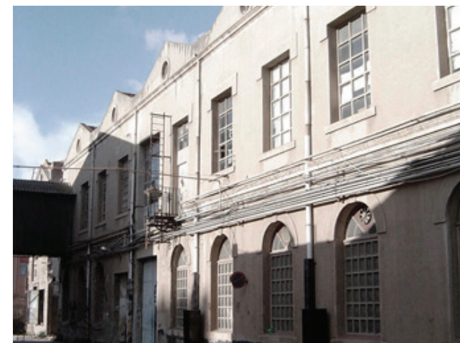
IMG 144: Estado Nave C anterior a la intervención
