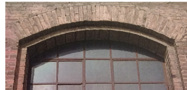
IMG 171: Detalle de ventanas
