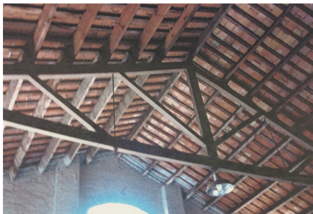
IMG 167: Cubierta Nave B anterior a la intervención
