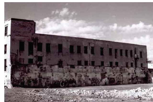
IMG 110: Volumetría Nave A anterior a la intervención
