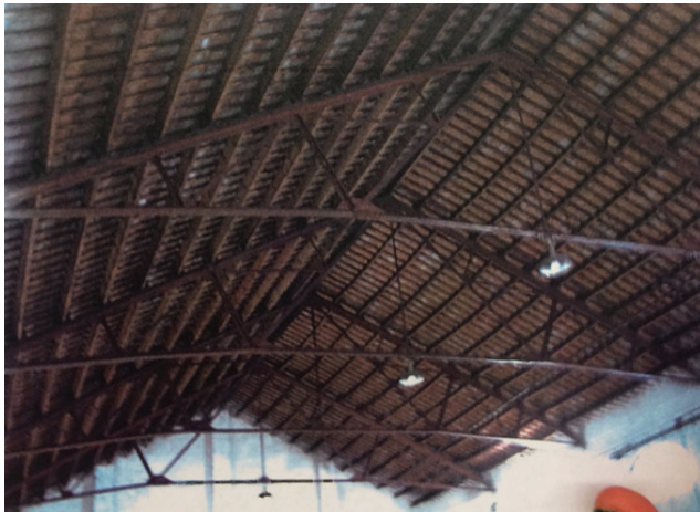
IMG 164: Cubierta Nave A anterior a la intervención
