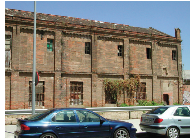
IMG 54: Fotografía exterior Nave C, Anterior a la intervención
