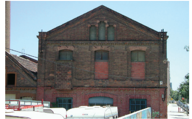
IMG 53: Fotografía exterior Nave C, Anterior a la intervención
