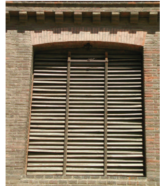
IMG 59: Fotografía Ventana tipo, Anterior a la intervención
