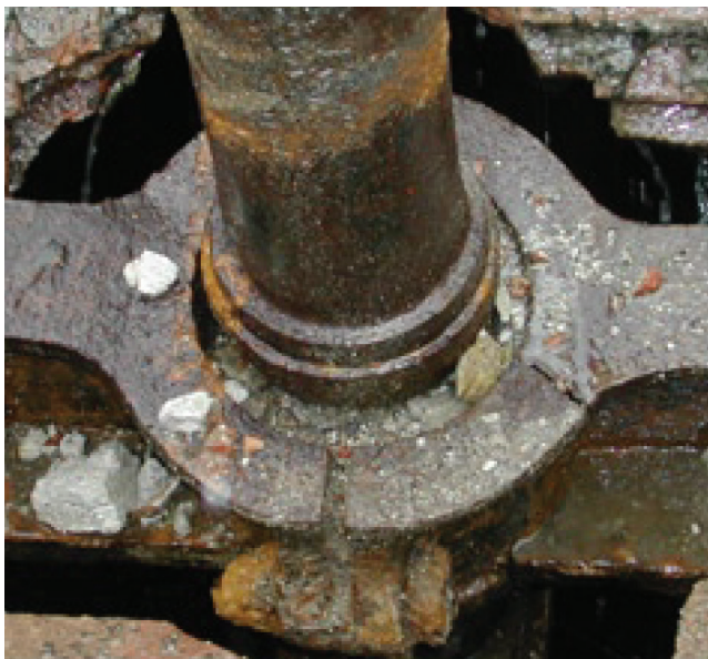
IMG 85: Estado de la estructura anterior a la intervención
