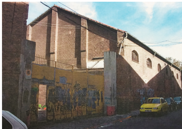
IMG 163: Estado Nave A anterior a la intervención
