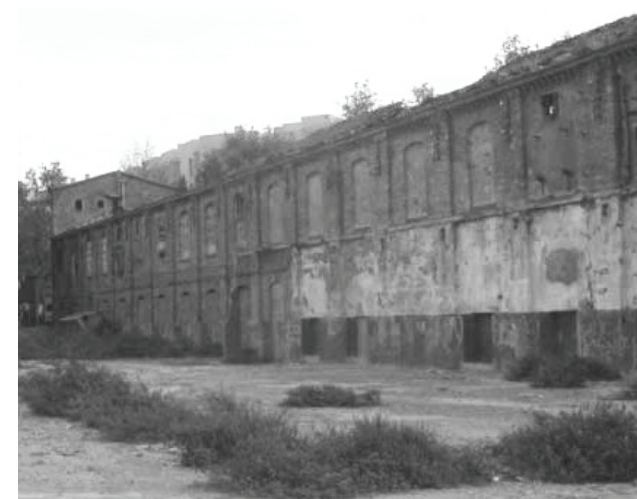
IMG 84: Estado de la Nave A anterior a la intervención
