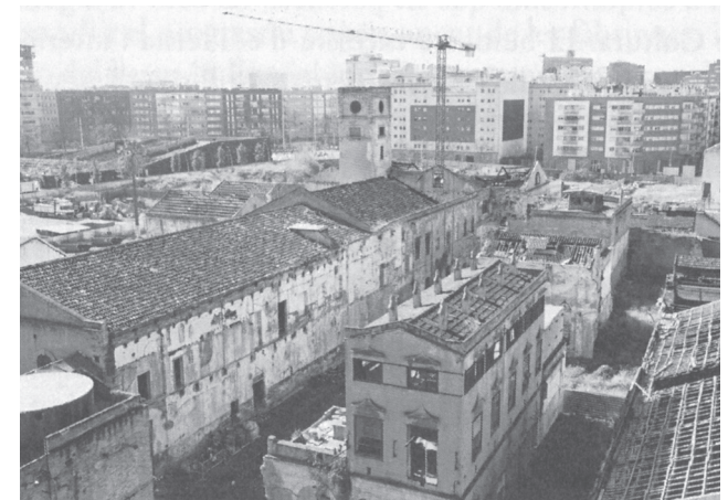
IMG 136: Estado del complejo fabril antes de su intervención
