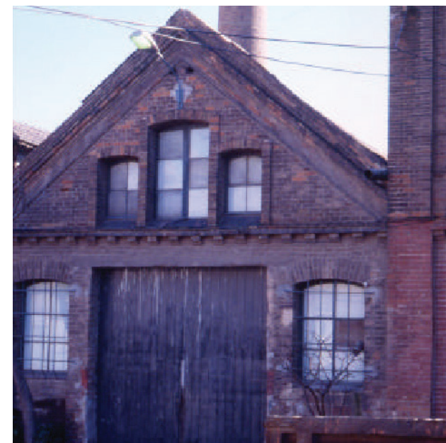
IMG 51: Fotografía Nave B, Anterior a la intervención
