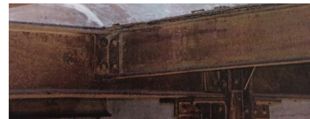
IMG 173: Detalle de union de jacenas metalicas
