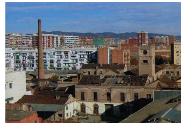
IMG 137: Estado del complejo fabril antes de su intervención
