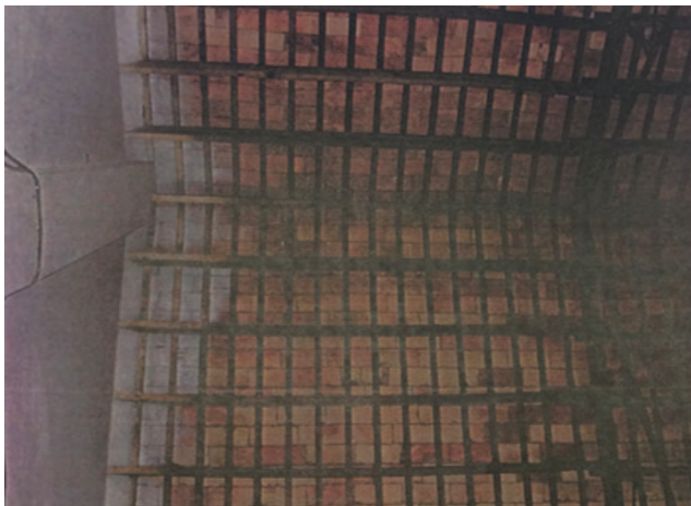
IMG 165: Cubierta Nave A anterior a la intervención
