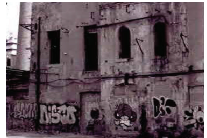
IMG 112: Fachada Nave A anterior a la intervención
