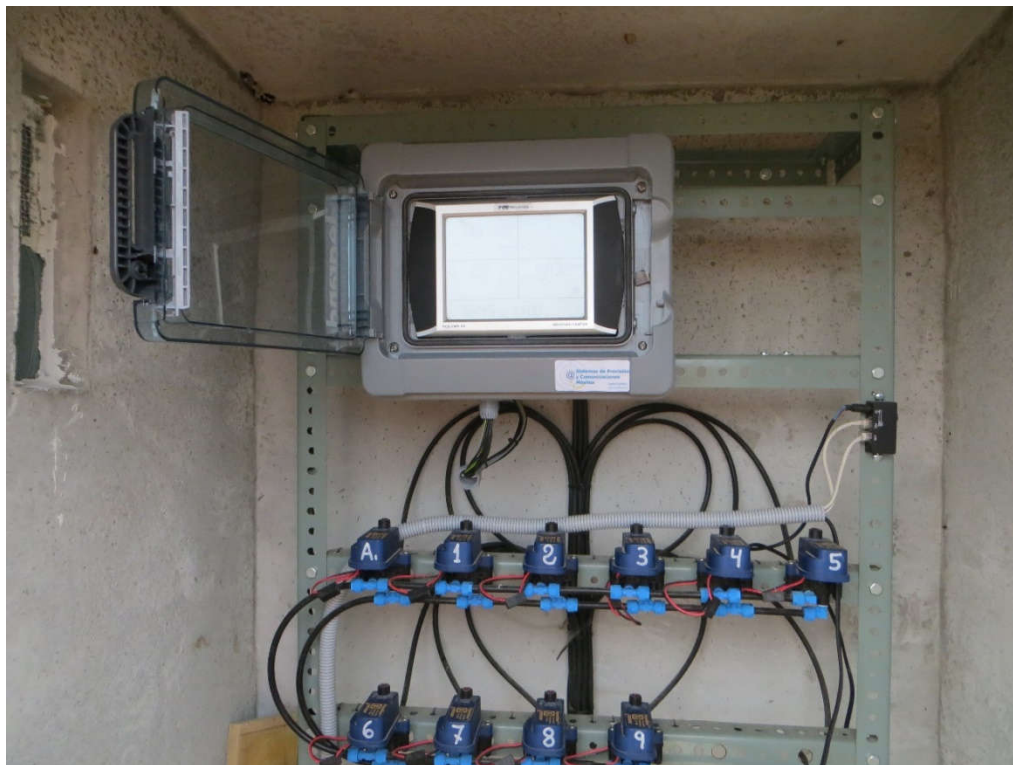
Figura 4.2. Controlador de riego, panel estación meteorológica y solenoides tipo latch.
