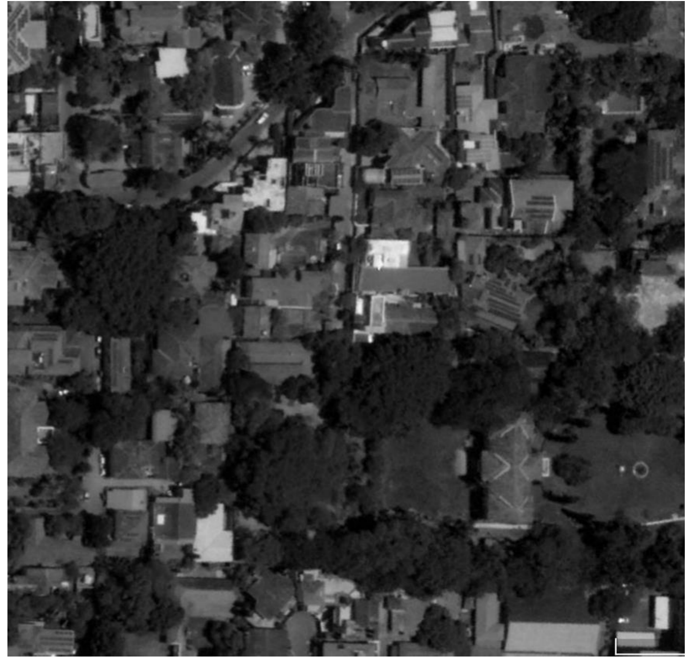
Figura 55. Vista aérea próxima The 33 Lane 77
