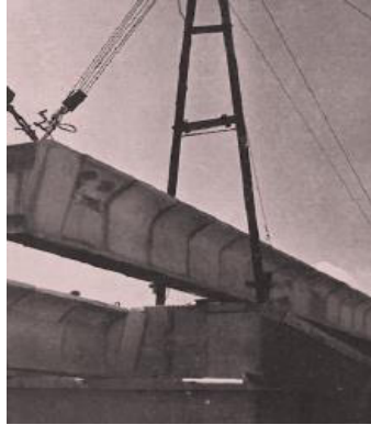
Fig. 70 Construcción del puente.
