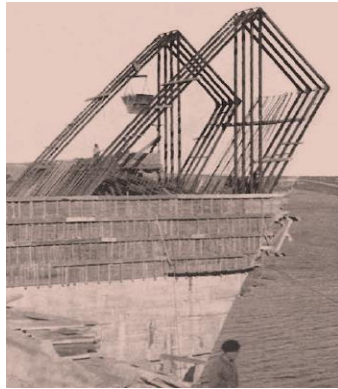
Fig. 63 Arranque del viaducto.
