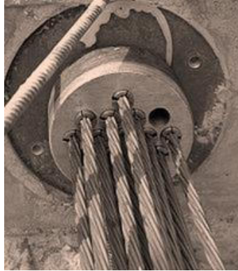
Fig. 76 Anclaje de postesado.
