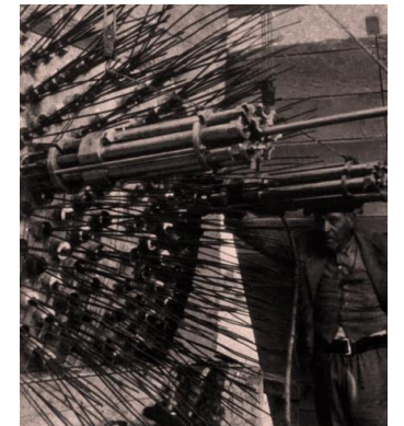
Fig. 32 Tesado de los cables por el Método Barredo.
