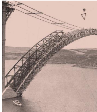
Fig. 60 Construcción de la cercha metálica.
