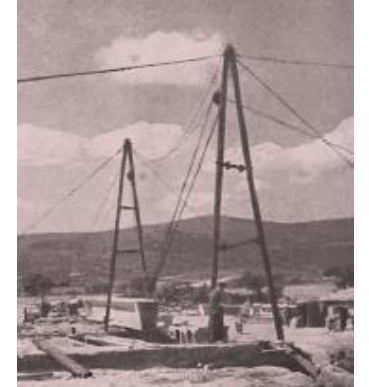
Fig. 68 Construcción del puente.
