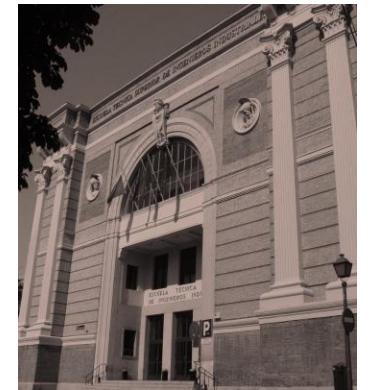
Fig. 3 Universidad de ingeniería industrial de Madrid.
