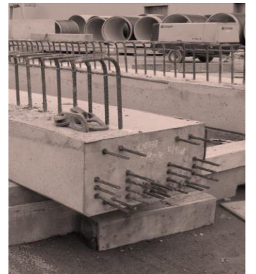
Fig. 24 Elemento de hormigón pretensado.
