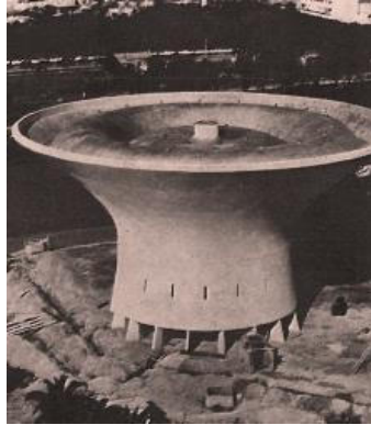
Fig. 53 Vista exterior del depósito.
