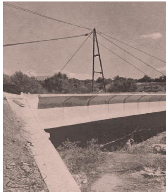
Fig. 65 Vista del puente.
