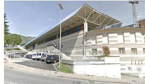
Figura 20. Vista exterior Fachada Sur "Estadio Ipurúa, 2019." Fuente: Google Earth Pro.
