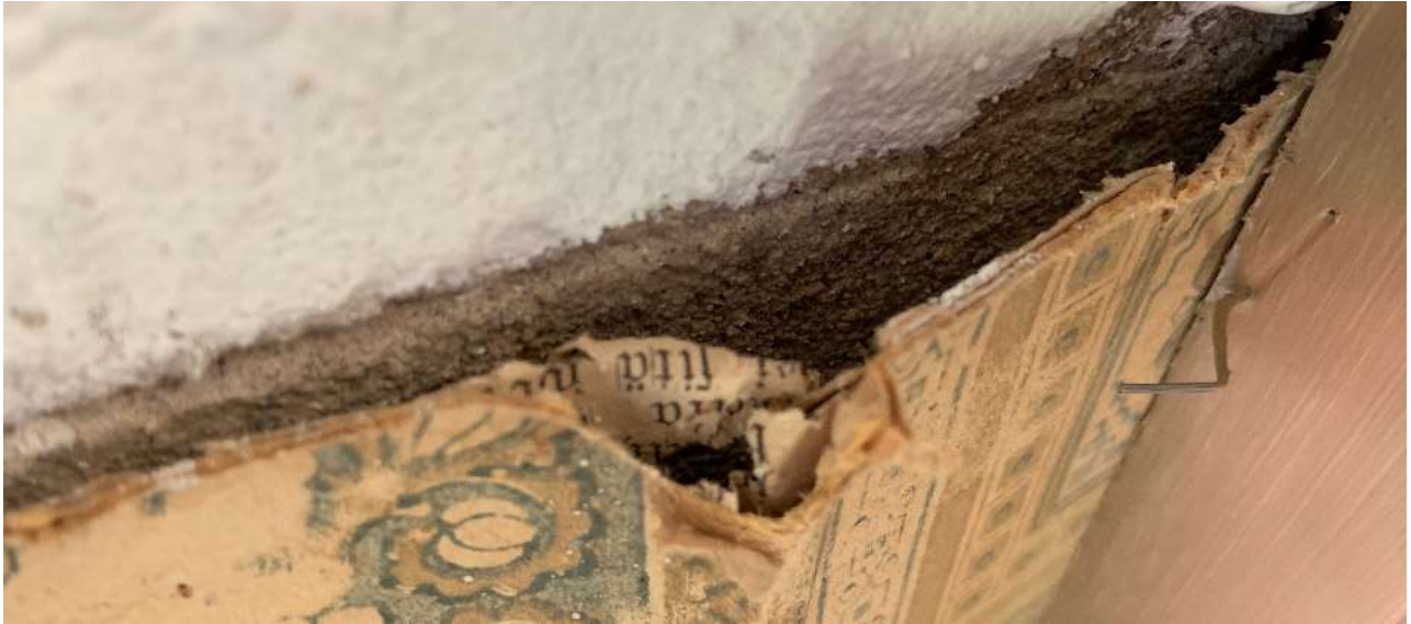
Figura 68: La hoja preparatoria está justo debajo el empapelado. En este detalle se puede apreciar también la presencia de periódicos. (Muro de ladrillos de Tammela, desde el cuarto de ingreso. (f.d.a. 26/09/2019)
