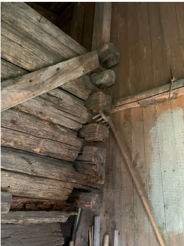
Figura 91 y 92: De izquierda a derecha, primer sistema de encaje de troncos en la esquina. Este tipo de encaje es más aparatoso. (f. depósito de casa Kirsti (12/08/2019), f.d.a. 12/08/2019); sistema de encaje más regular en un almacén de una casa privada (f.d.a. 30/09/2019)
