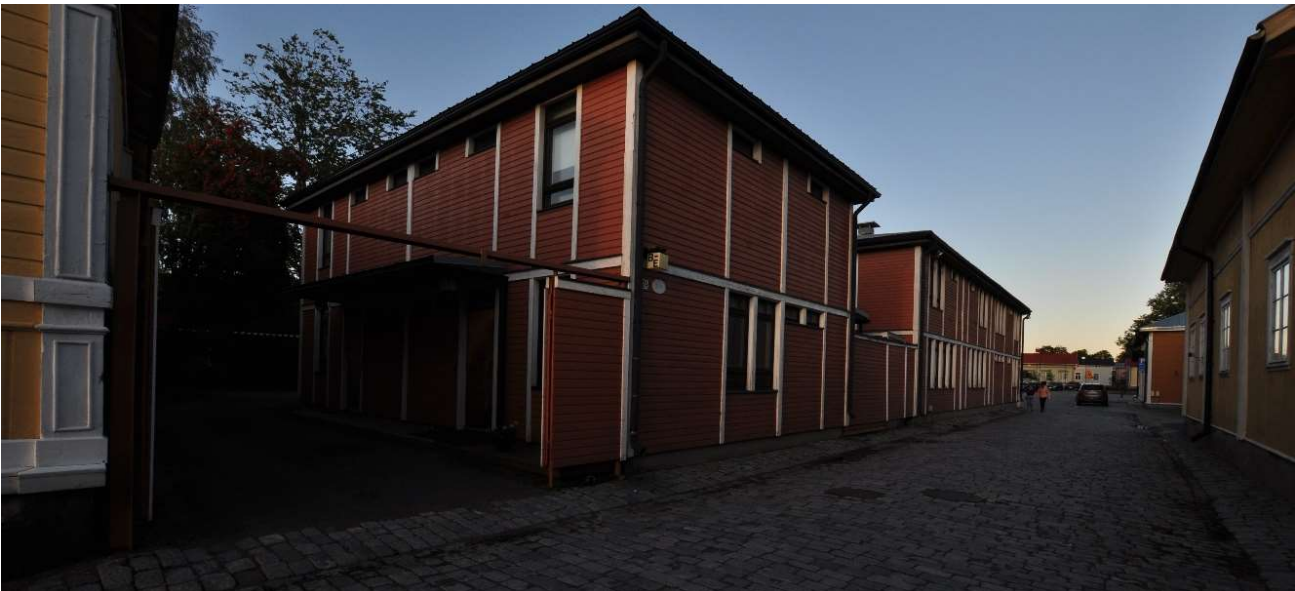
Figura 114: Vista del edificio nuevo recayente a la plaza desde Vanhankirkonkatu (f.d.a. 17/09/2019)
