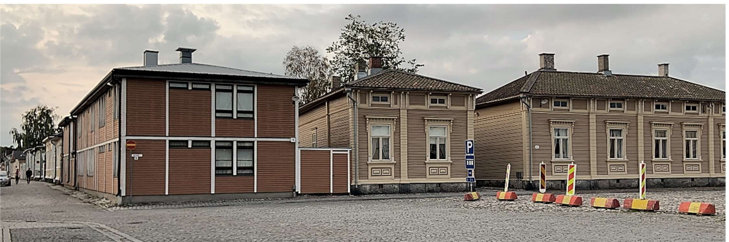
Figura 52: Foto del edificio en Kauppatori (f.d.a. 29/09/2019)
