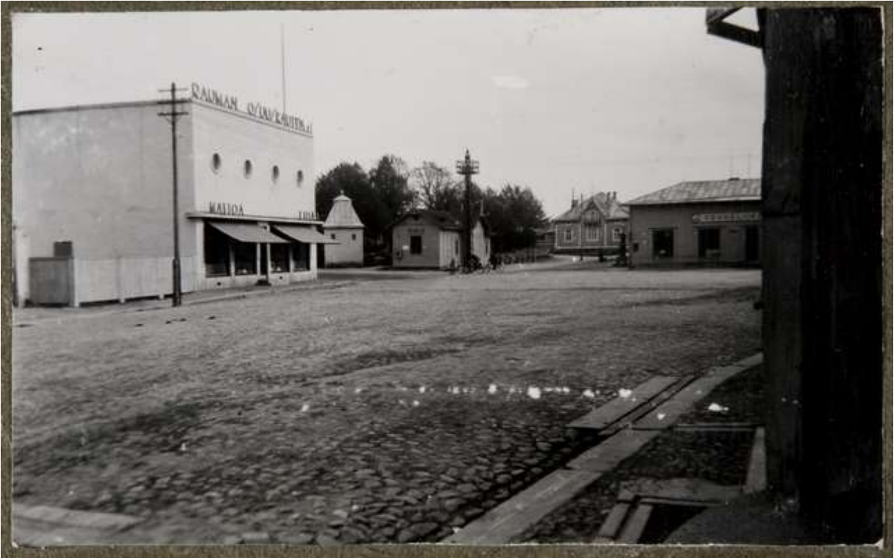
Figura 113: Foto de Kalatori del 1937, sacada del norte-oeste hacia el sureste, mirando al parque de las ruinas de la iglesia de la Santa Trinidad. (Imagen procedente del archivo de National Board of Antiquities – Musketti y consultable en < https://finna.fi/Record/musketti.M012:HK19481120:19 > [accedido el 02/11/2019])
