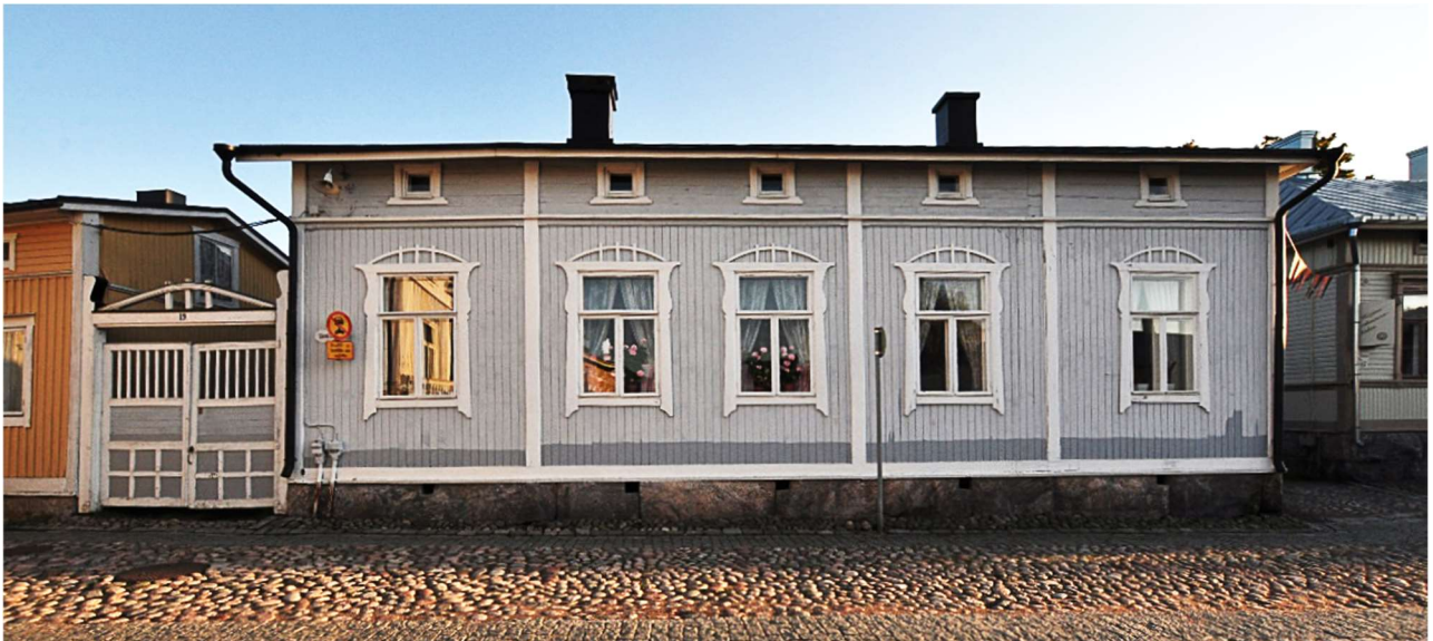
Figura 83: Sótano de altura estándar con una línea de piedra de tamaño medio. (f.d.a. 10/09/2019)
