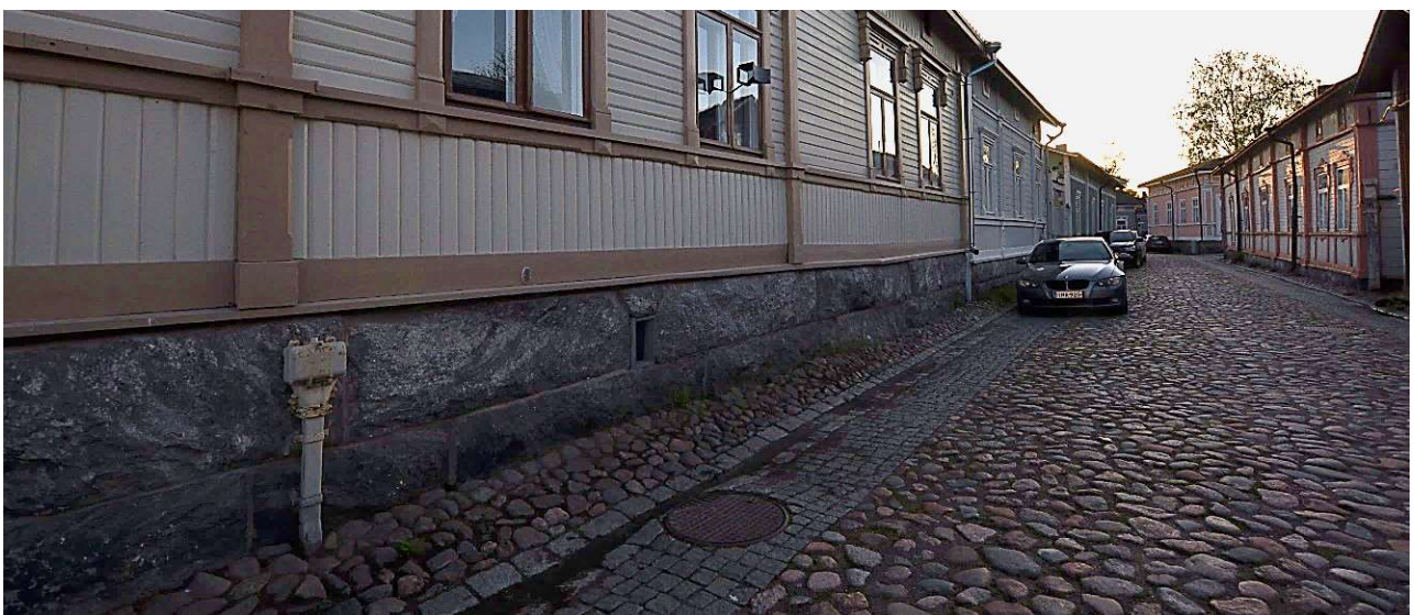
Figura 84: Sótano de altura superior a la media, con dos líneas de piedra. (f.d.a. 10/09/2019)
