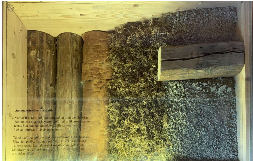
Figura 86: Forjado con troncos como base, musgo, grava y tablon de madera. Este es el tipo más antiguo y tradicional de forjado. En algunos de los troncos se puede apreciar la presencia de corteza que se ha dejado para contribuir al aislamiento. Se aprecia, además, que los elementos empleados son bastante rústicos y de corte más irregular (f.d.a. 18/08/2019)
