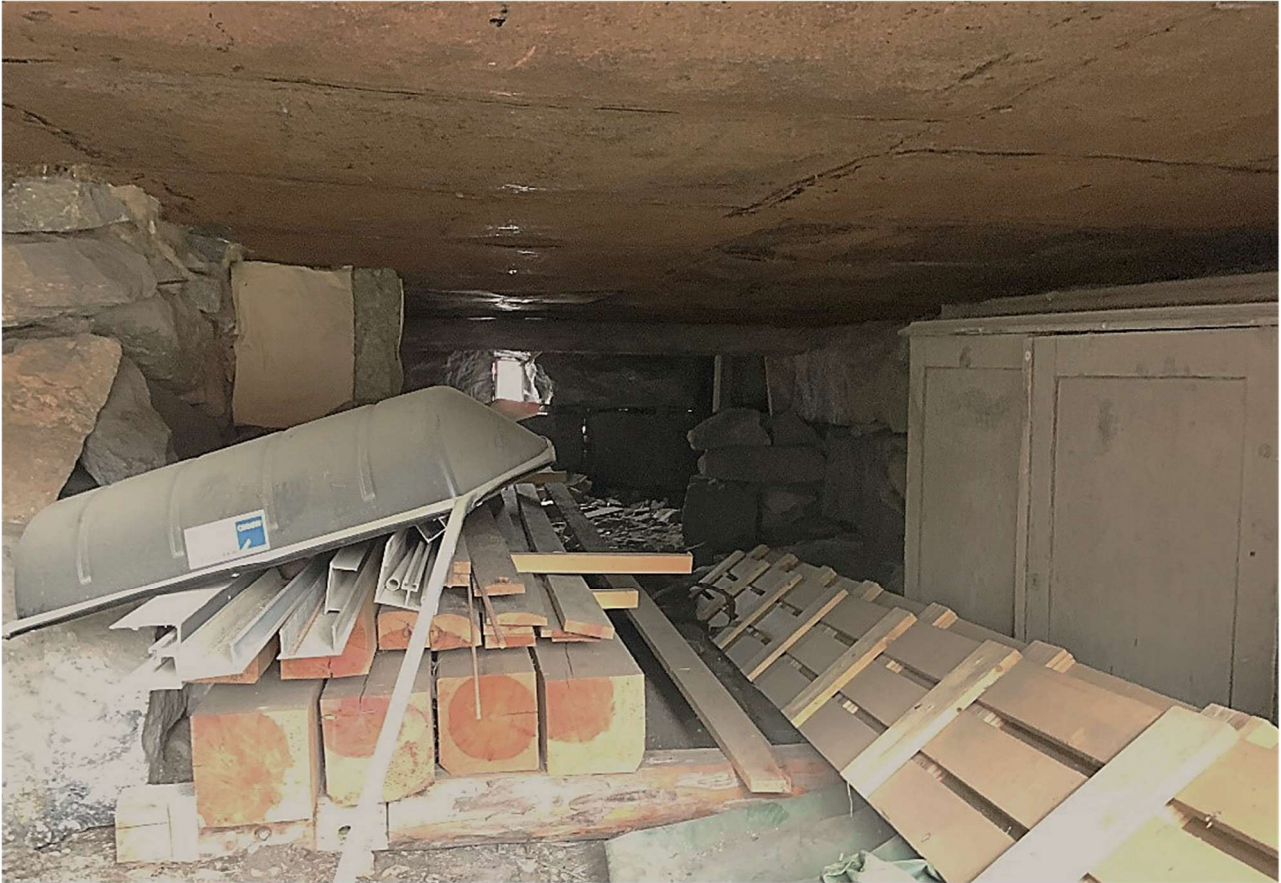
Figura 80: Interior de un sótano en Tammela: se observan, en el fondo y a la derecha, las paredes exteriores, mientras que la agrupación de piedra a la izquierda es la base de soporte del sistema de estufas. En la esquina derecha, además, existe un apilamiento de soporte para la pared intermedia (f.d.a. 20/09/2019)
