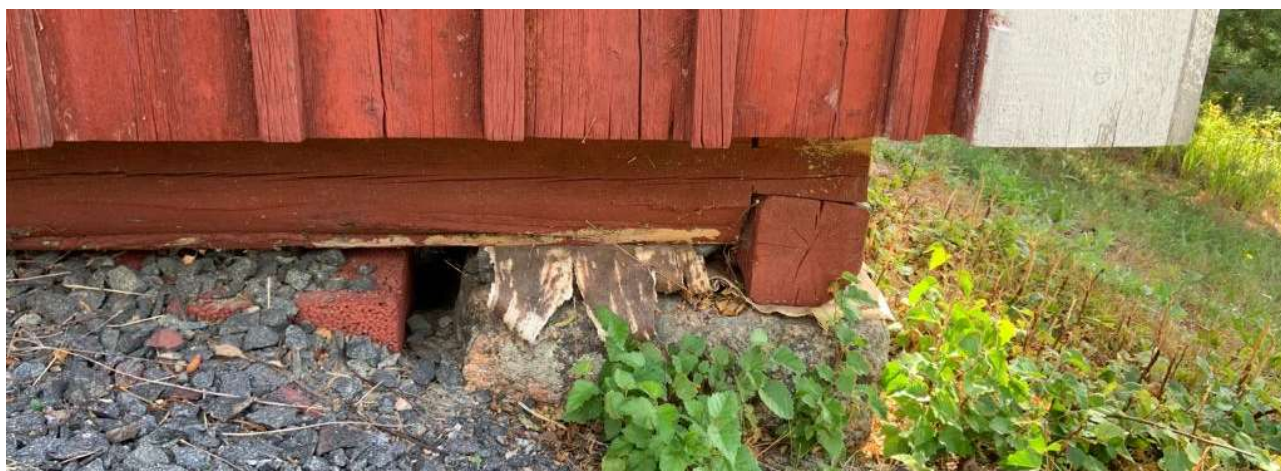
Figura 79: Edificio sin sótano, las vigas maestras apoyan directamente sobre algunas piedras colocadas en las esquinas (almacén en Lappi, f.d.a. 31/07/2019)
