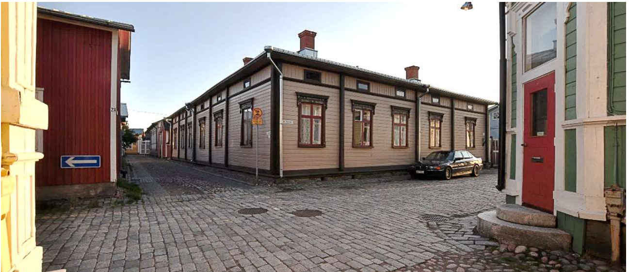
Figura 82: Sótano de altura muy reducida, con apenas una delgada línea de piedra. (f.d.a. 10/09/2019)
