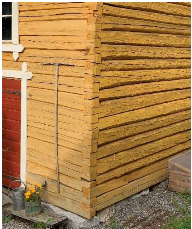
Figura 91 y 92: De izquierda a derecha, primer sistema de encaje de troncos en la esquina. Este tipo de encaje es más aparatoso. (f. depósito de casa Kirsti (12/08/2019), f.d.a. 12/08/2019); sistema de encaje más regular en un almacén de una casa privada (f.d.a. 30/09/2019)
