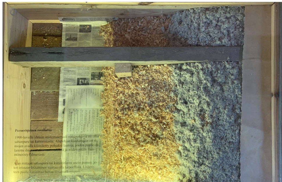
Figura 87: forjado con tablas como base inferior, serrín, fibra de celulosa y tablon de madera. Este tipo de forjado es un modelo bastante difundido y más reciente que el caso anterior. Se aprecia la presencia de periódicos en el fondo, por encima de la base inferior probablemente empleados para realizar un estrato de base sobre el que disponer el aislante útil también para bloquear la salida del calor. Los elementos son mucho más regulares y de corte preciso (f.d.a. 18/08/2019)
