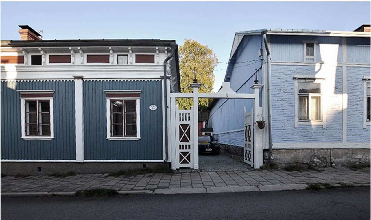
Figura 81: Los sótanos tienen diferentes alturas. Probablemente el edificio de la derecha es relativamente nuevo o ha sido reformado, ya que la altura de la planta de calle es superior a la estándar de este tipo de construcciones. (f.d.a. 10/09/2019)
