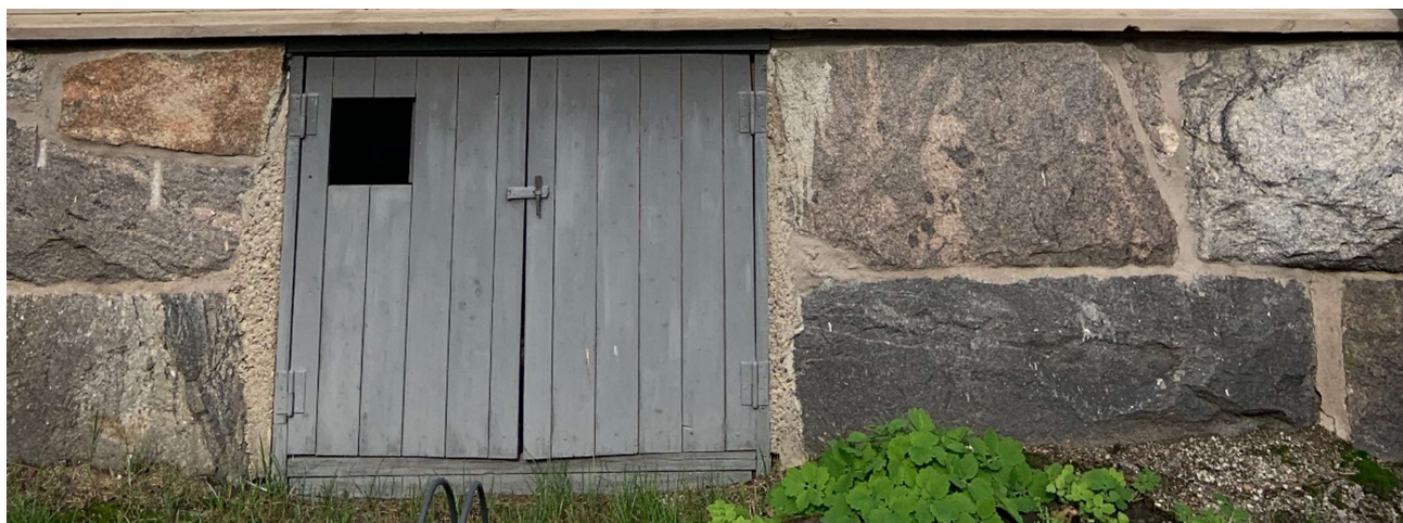
Figura 78: Sótano con dos hiladas de sillares (Tammela, f.d.a. 13/09/2019)
