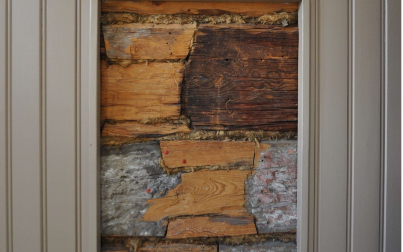
Figura 93: Troncos de la pared expuestos a través de una ventana arqueológica en Tammela. Se pueden apreciar las irregularidades y el aislante, que no solo bloquea frío y ruido, sino que sirve también para nivelar (f.d.a. 26/09/2019)
