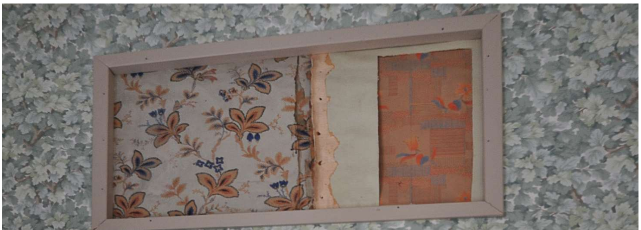
Figura 70: Diferentes capas de empapelados en Tammela (f.d.a. 27/09/2019)
