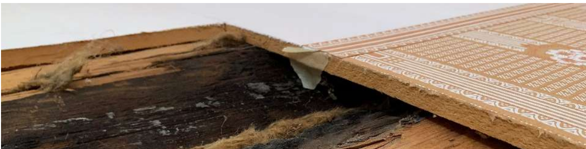
Figura 67: Panel de base en fibra de papel. Se aprecia cómo el panel está justo encima de los troncos y sobre se ha pegado el empapelado (Tammela, cuarto rosa, f.d.a. 26/09/2019)
