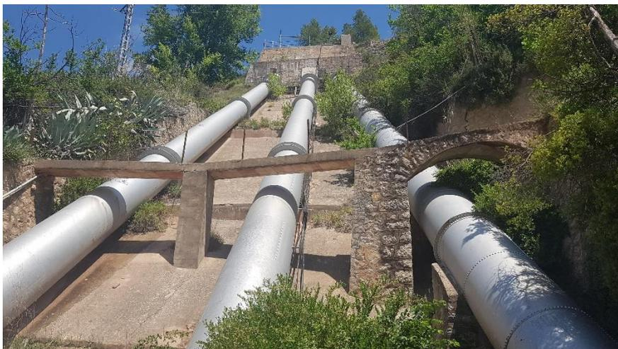
Figura 38. Tuberías de la central de Los Villanuevas. Foto del Autor
