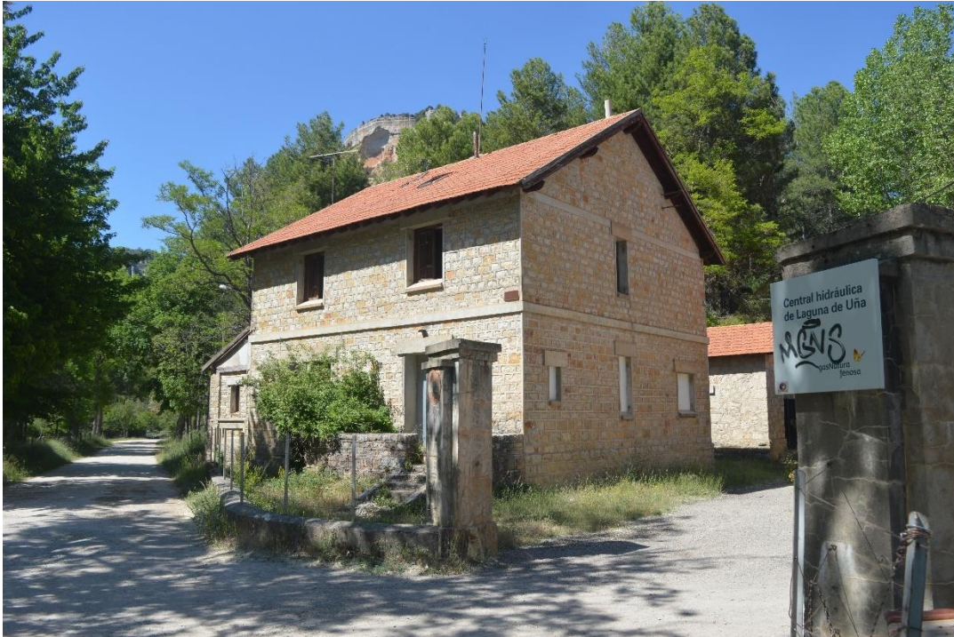
Figura 40. Primer grupo de edificios de la central hidráulica abandonada de la Laguna de Uña
