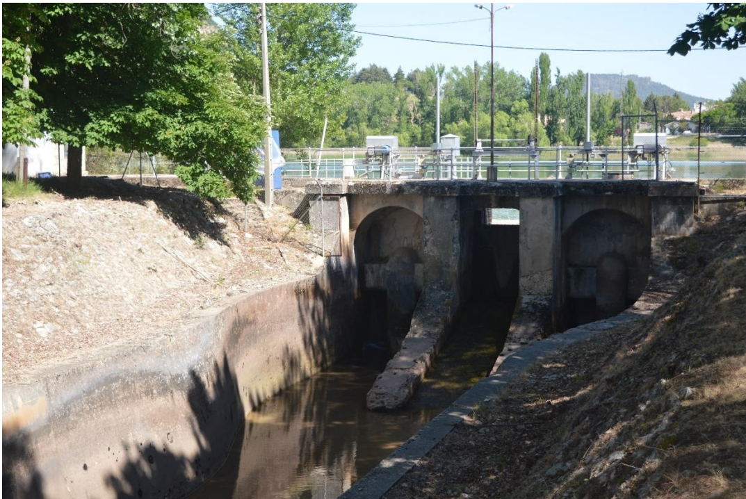
Figura 48. Entrada al canal derivador entre la Laguna de Uña y la central de Villalba
