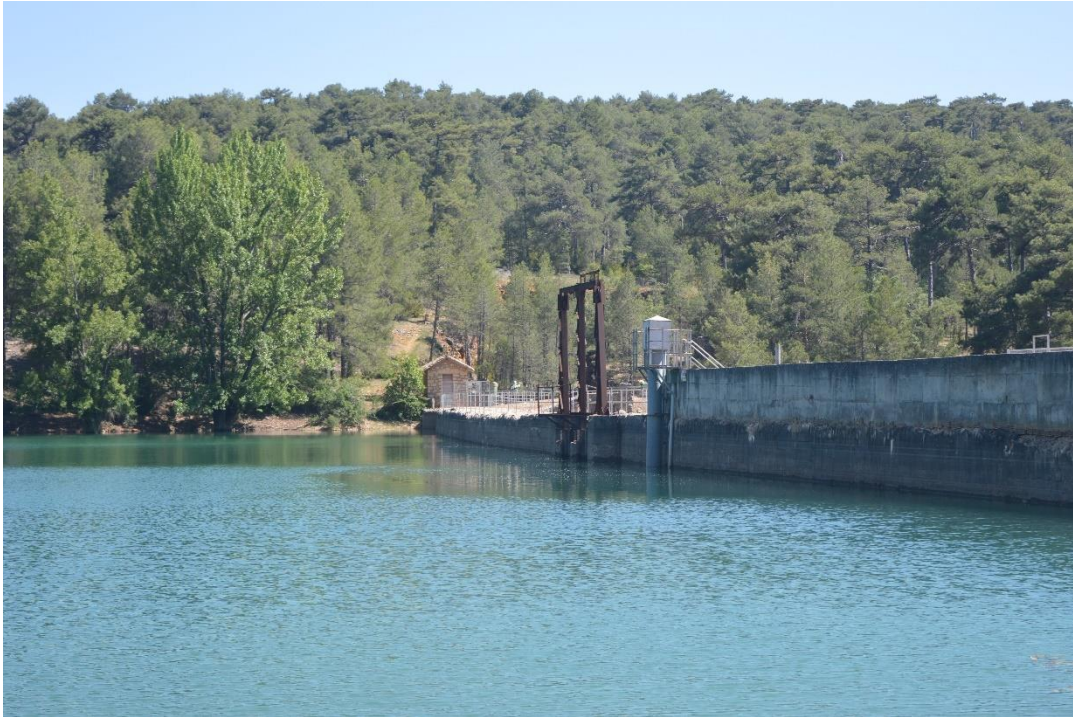
Figura 36. Aliviadero superficial de la presa de La Toba
