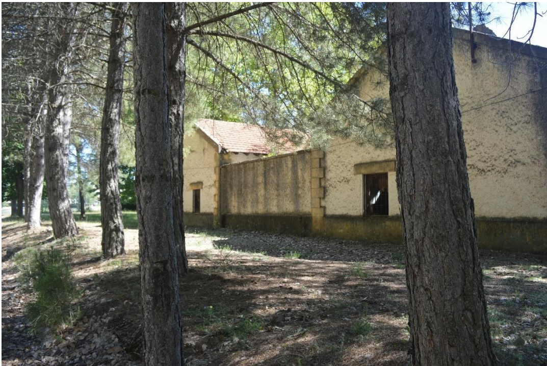
Figura 47. Vista posterior de la central hidráulica de la Laguna de Uña
