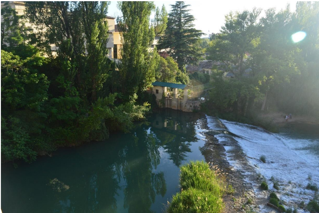
Figura 77. Compuertas de toma y central hidroeléctrica Molino de Santiago
