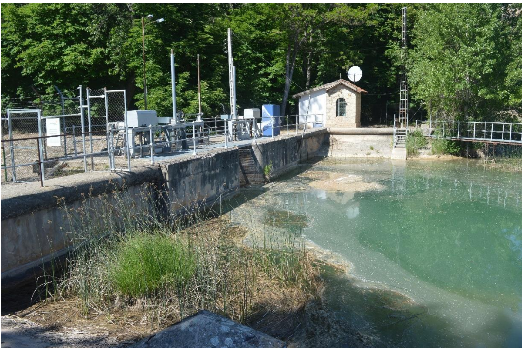
Figura 49. Compuertas de entrada al canal derivador
