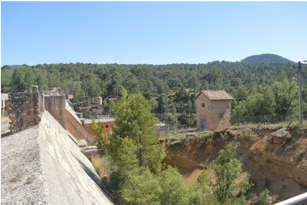
Figura 37. Central hidroeléctrica de pie de presa La Toba
