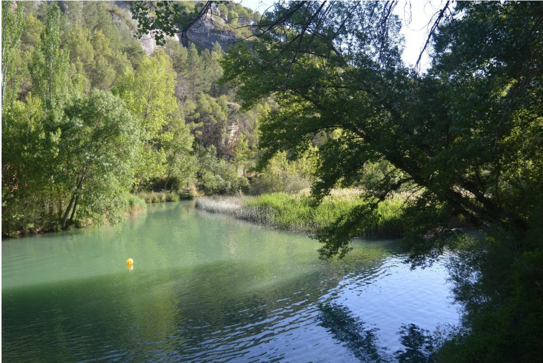
Figura 68. Río Júcar y canal de derivación para la central Las Grajas
