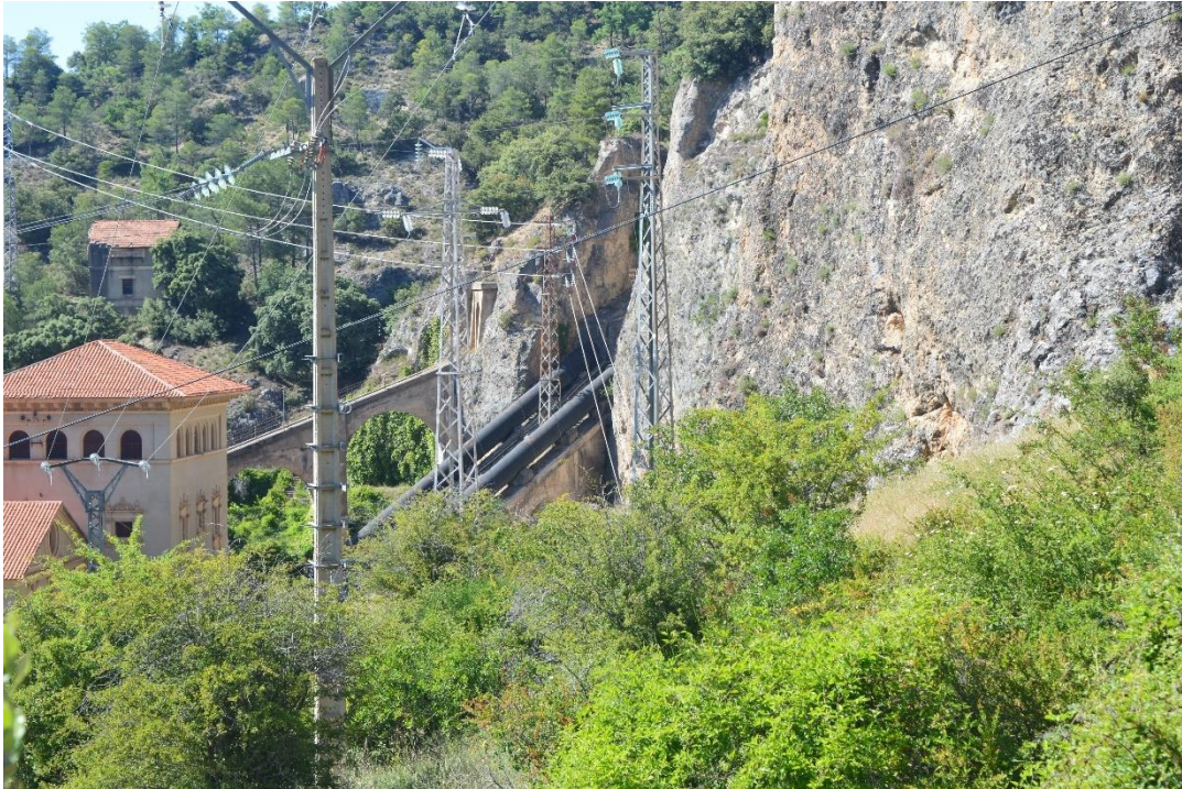
Figura 56. Tuberías forzadas hasta la central hidroeléctrica de Villalba
