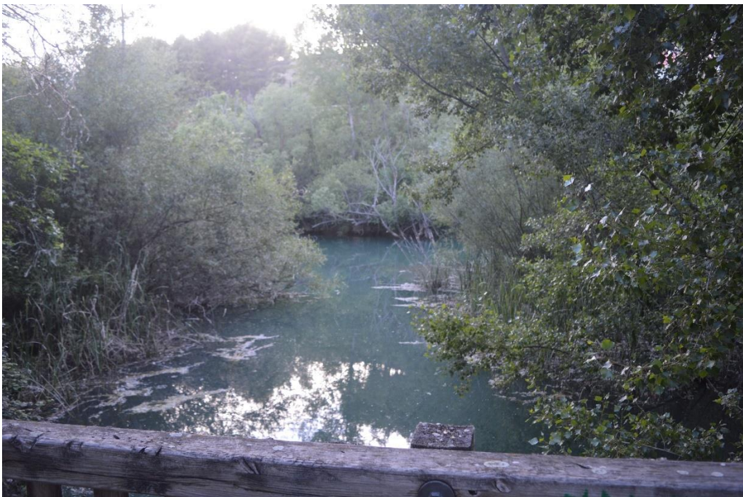
Figura 79. Restitución de la central hidroeléctrica Molino de Santiago al río Júcar
