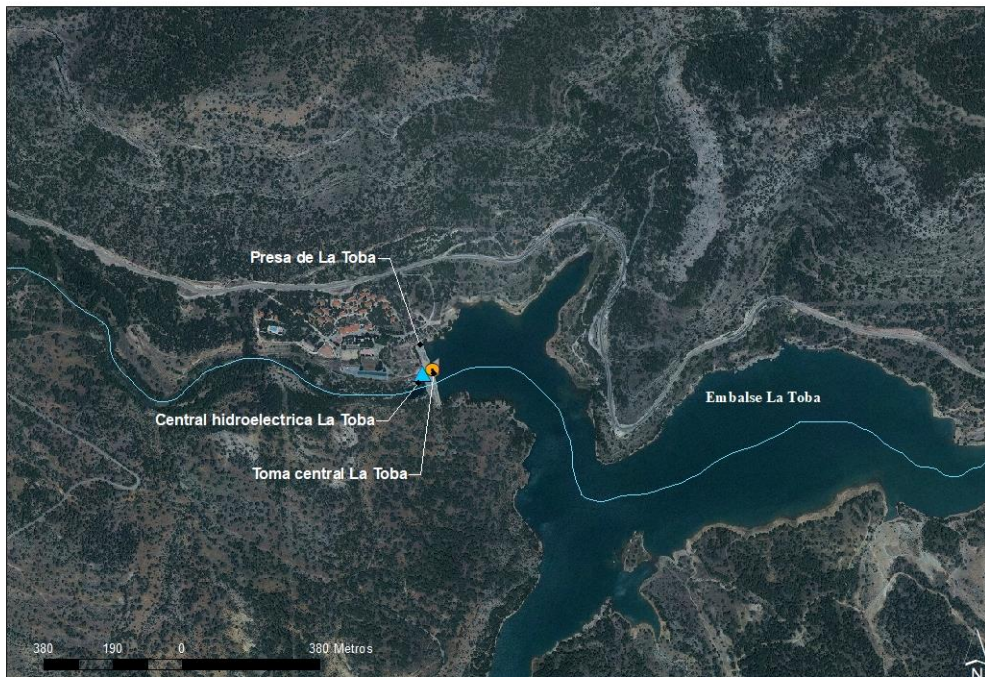
Figura 3. Ortofoto de la central hidroeléctrica de La Toba y el embalse de La Toba escala 1:10.000
