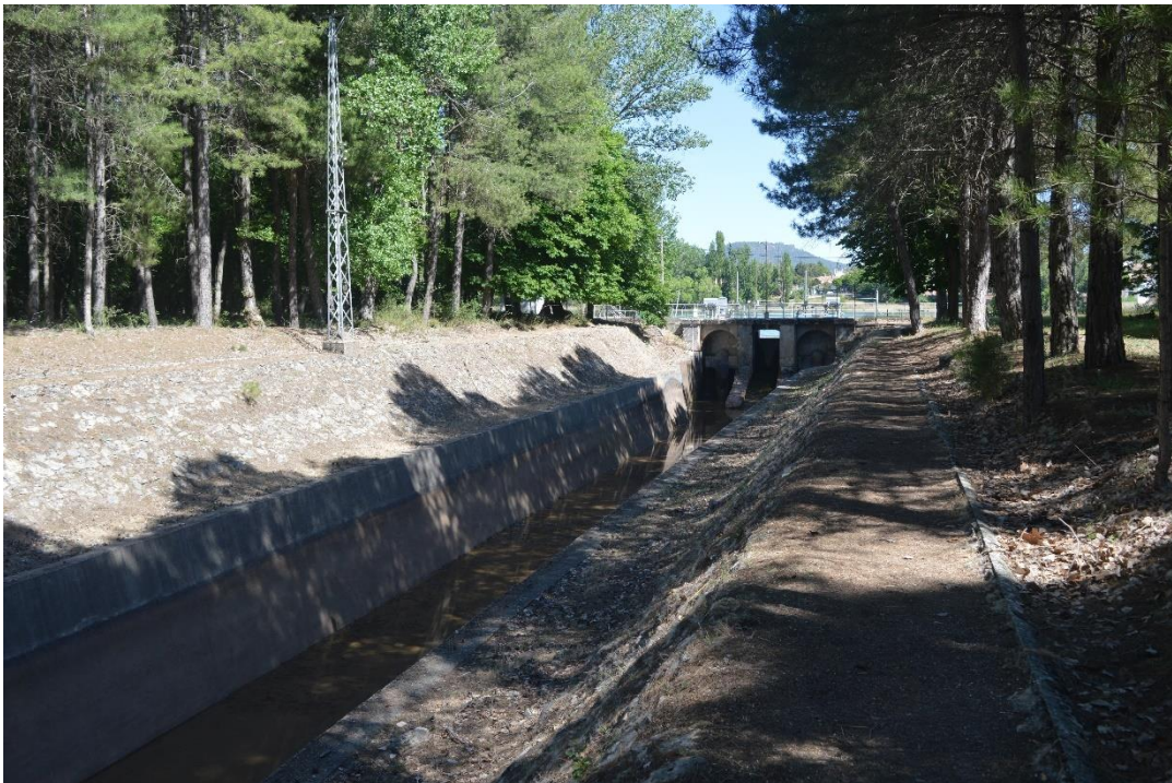
Figura 45. Canal derivador entre la Laguna de Uña y la central de Villalba
