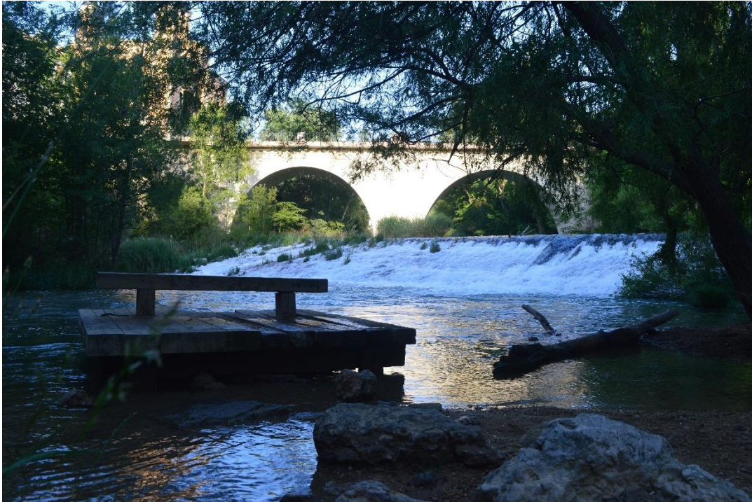
Figura 78. Vista aguas abajo del puente de San Antón y Presa de San Antón o Molino de Santiago
