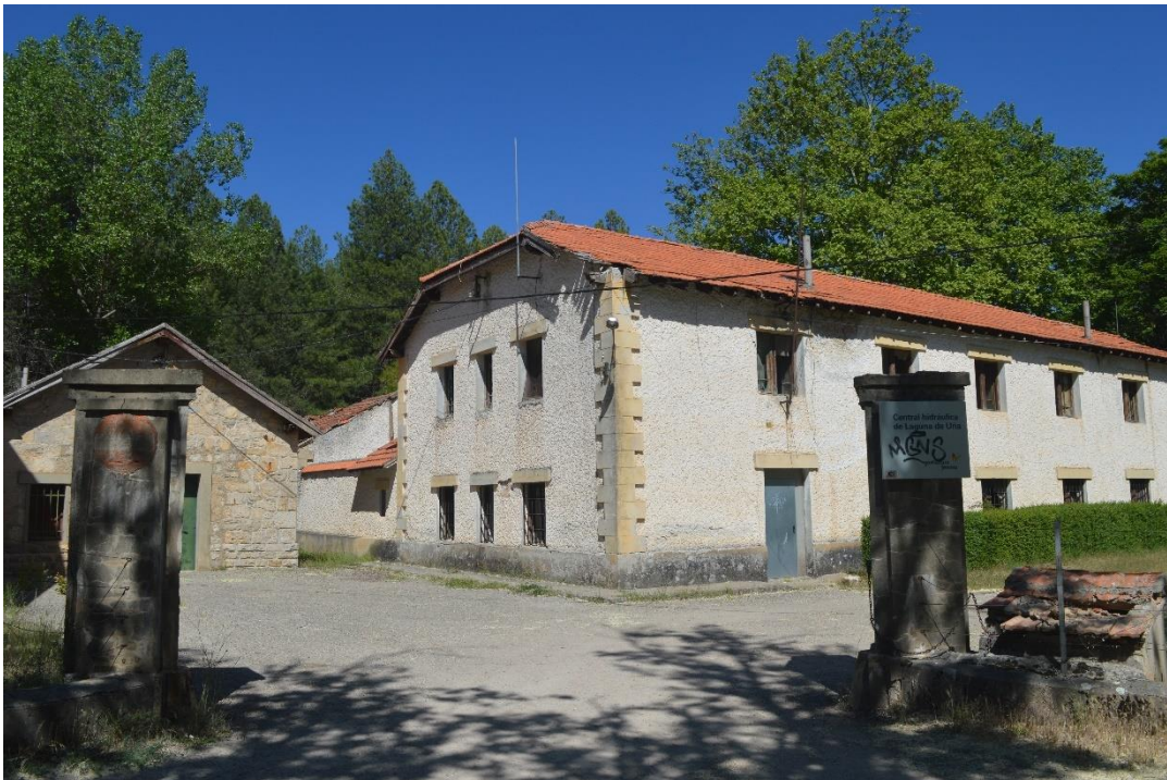
Figura 41. Segundo grupo de edificios de la central hidráulica abandonada de la Laguna de Uña
