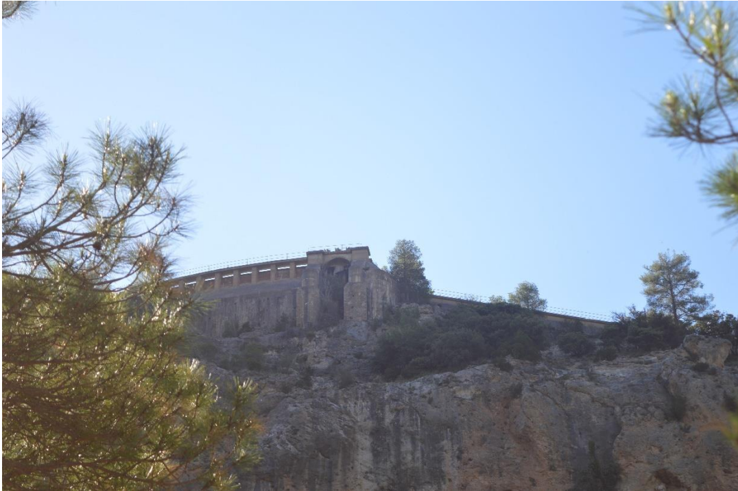
Figura 64. Depósito de El Salto
