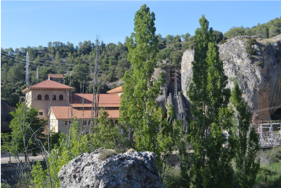
Figura 66. Vista alternativa de la central de Villalba y las tuberías forzadas
